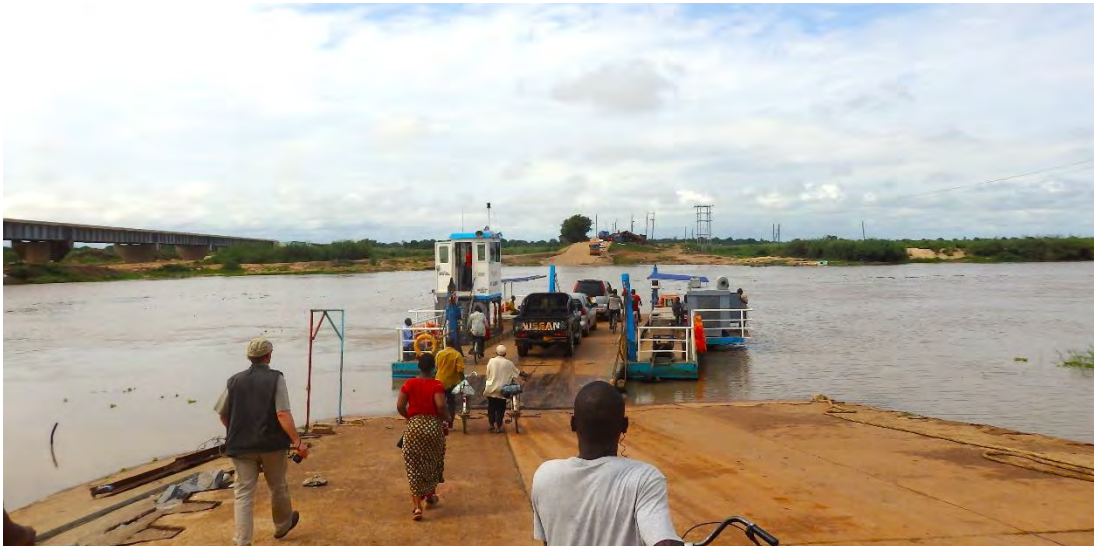
Photo 13. Embarcadère et pont en construction à Kivukoni (Réalisation : E. Ngyie, 03/2017)
