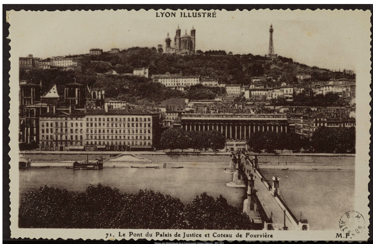
FIGURE 1.5 – Lyon illustré. 71. Le pont du palais de justice et coteau de Fourvière. M. F. Années 1920. Collection Fonds Bry, tous droits réservés. Source : Médiathèque de la Communauté Urbaine d'Alençon. https://bibliotheque-numerique-patrimoniale.cu-alencon.fr/idurl/1/4202 (consultée le 20/10/2021).
