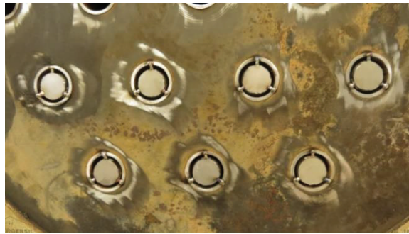
Figure 6-3 : Photos des inserts hydrauliques après mises en place
