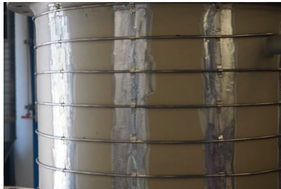
Figure 6-5 : Photographie des cordons chauffants mis en place sur la paroi extérieure de la calandre
