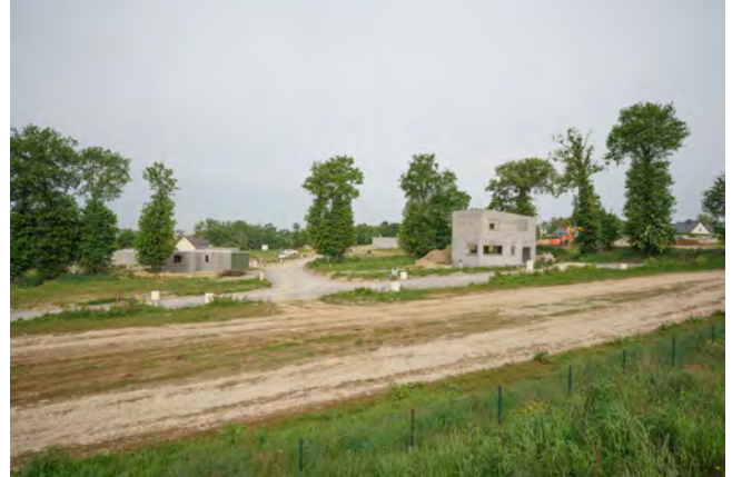
Figure 174 Vignoc, lotissement en cours de construction, 2019.
