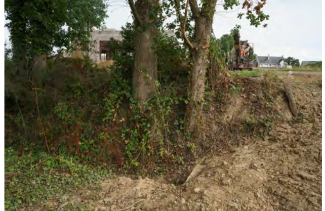
Figure 176 Vignoc, talus du bocage entamé par les machines de chantier.
