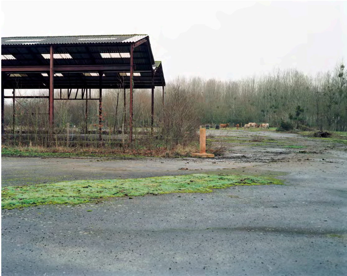
Figure 5 Les Amis du Transformateur, Saint-Nicolas de Redon, 2013.
