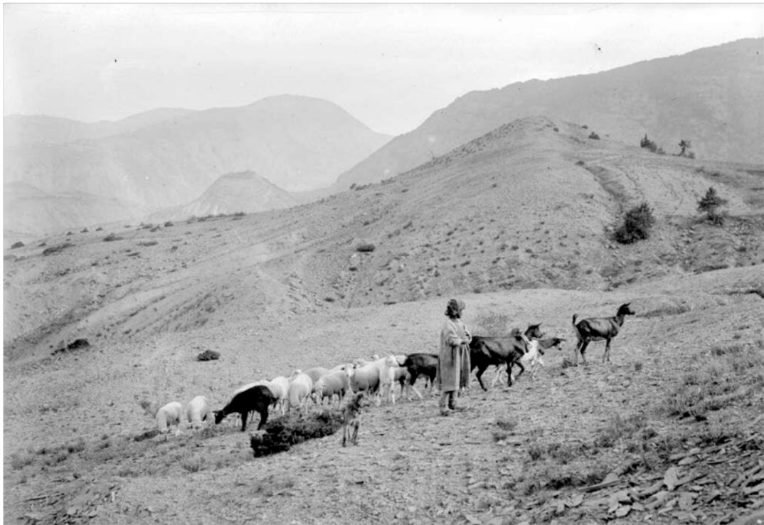
Figure 26 Communaux et forêt communale. Rive droite du torrent de Bréziers. Mont Colombis au fond, 1913, Service de Restauration des Terrains de Montagne, archives départementales des Hautes-Alpes, 21 Fi 3039.
