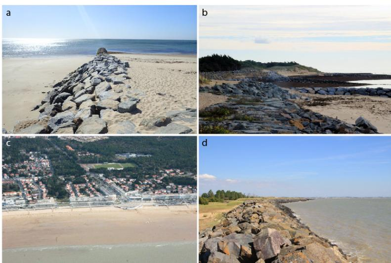
En ce qui concerne les ouvrages de protection, Kerguilic *et al.* (2019) (Annexe 1) distinguent les ouvrages transversaux tels que les épis (Figure 2-a, 2-b) et longitudinaux tels que les brise-lames, perrés, murs, enrochements, remblais (Figure 2-c) et les ouvrages de protection contre la submersion marine telles que les digues (Figure 2-d).
