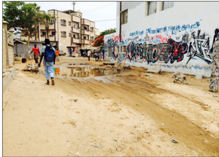
Photo 6 : Rue de la commune d'arrondissement de Yeumbeul Sud : exemple de l'état des infrastructures routières
