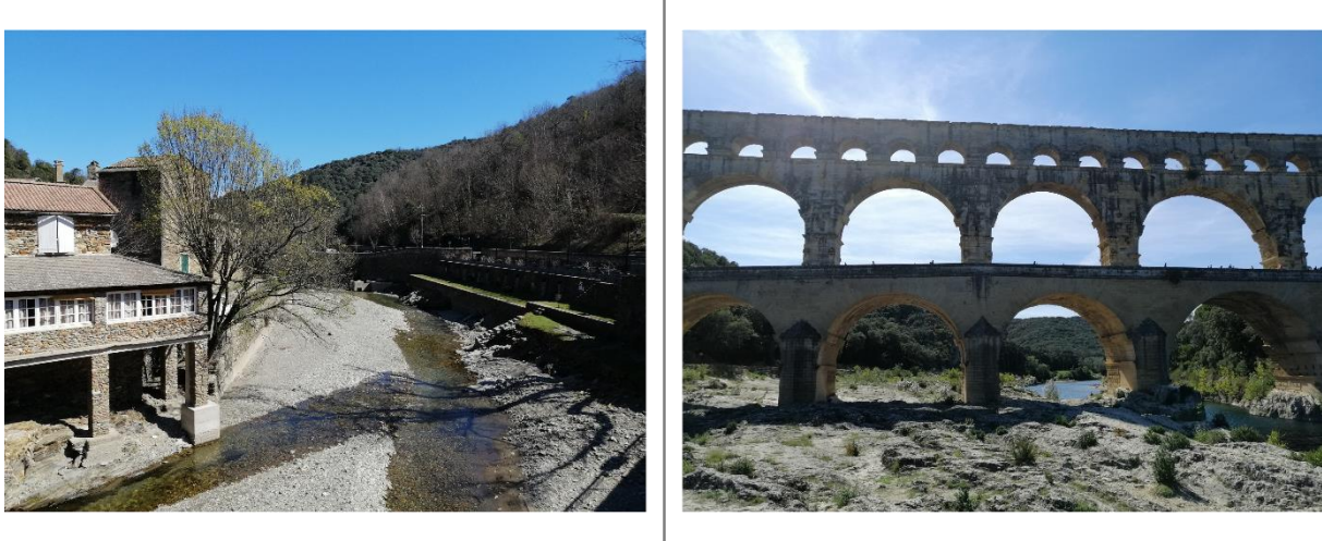
Figure 11 : Photographies de la confluence des deux ruisseaux borgnes au village des Plantiers en amont, et du Site du Pont du Gard en aval (crédits : Antoine FRICARD, 2021)
