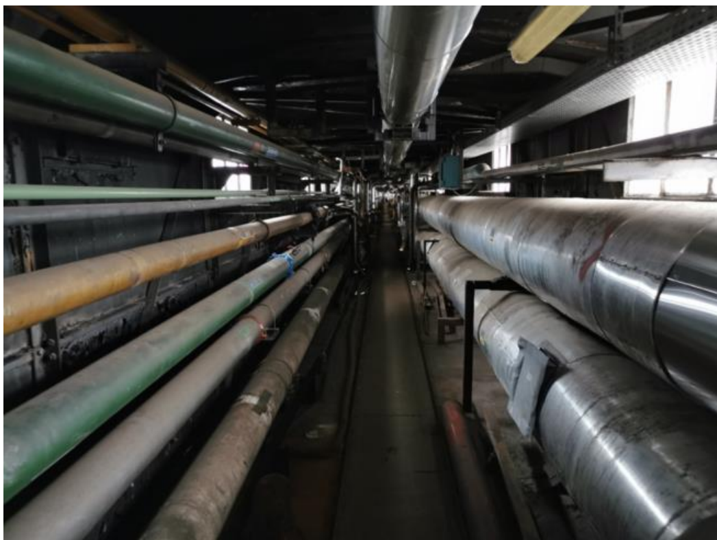
Figure 21. Exemple d'un lieu d'activité d'un technicien de maintenance.
