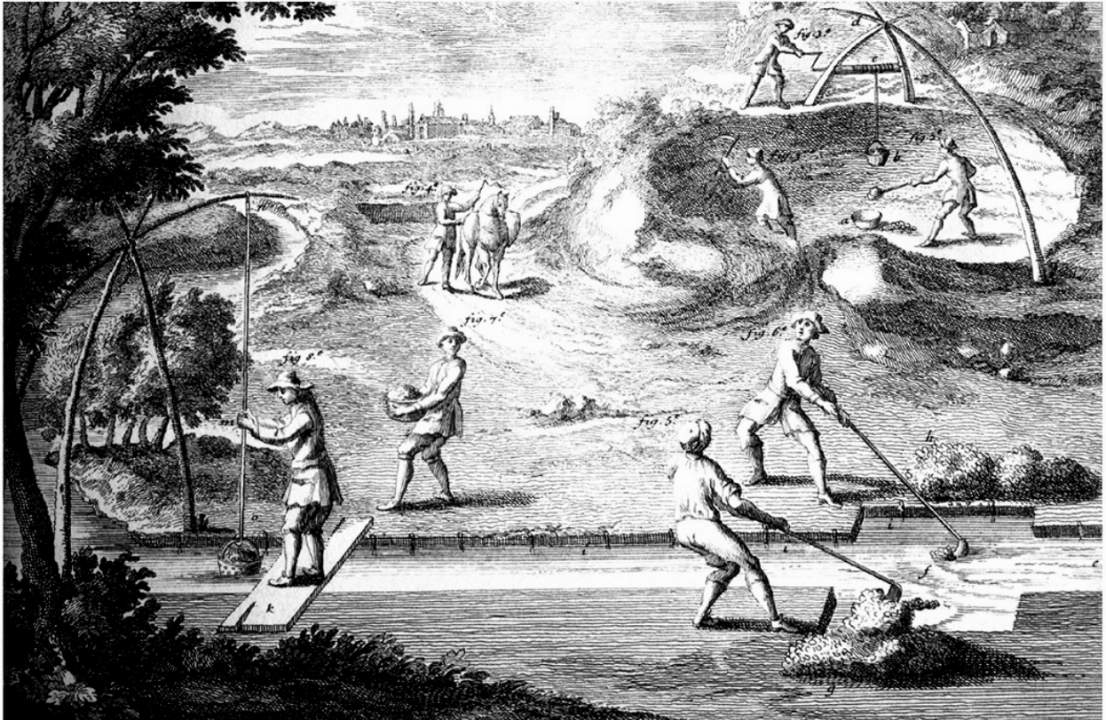
En haut, à droite, extraction du minerai. Au centre la mine extraite est conduite au lavoir à dos de mulet. En bas, à droite, deux ouvriers lavent la mine dans un bassin. À gauche, l'ouvrier passe au crible, appelé « égrappoir », une charge de minerai déjà lavé.
