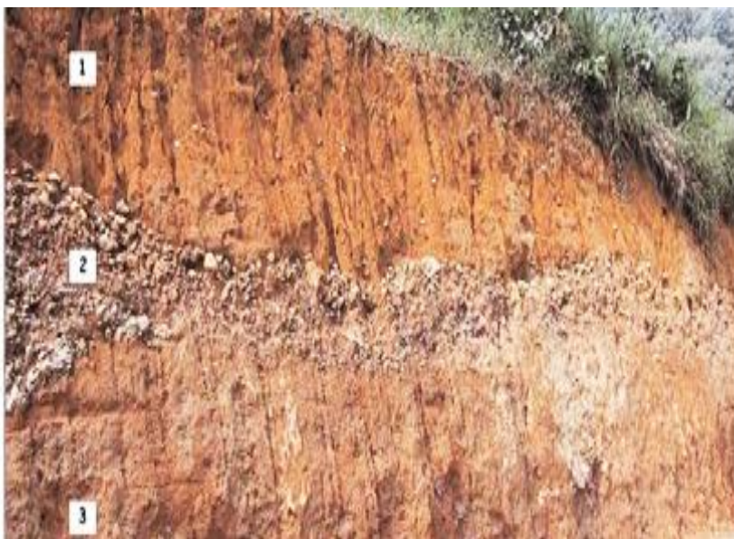
Figure 20: Stone line dans le talus de l'axe routier Médoumane-Lalara. 1 : Formation de couverture meuble sablo-argileuse ; 2 : Stone-line ou ligne de matériaux grossiers ; 3 : Altérites de la roche mère sous-jacente (Oslisly et Assoko, 2006)
