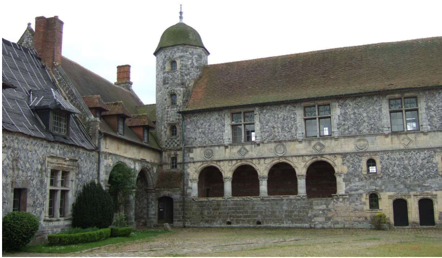
Fig. 458. Les Maillets. Bâtiment principal et aile méridionale dans la cour, état actuel.
