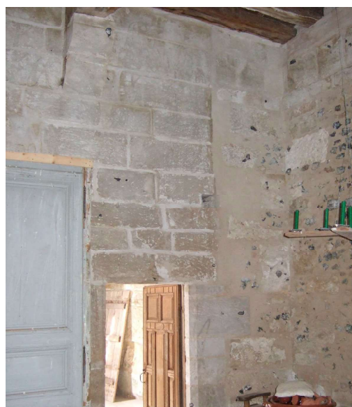
Fig. 409. Heubécourt. Mur nord de la sallette . Porte ouvrant sur la chapelle.
