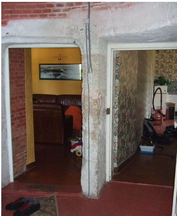
Fig. 384. Héronnelles. Cage de l'escalier au rez-de-chaussée. Portes de la cuisine (à droite) et de la grande salle (à gauche).
