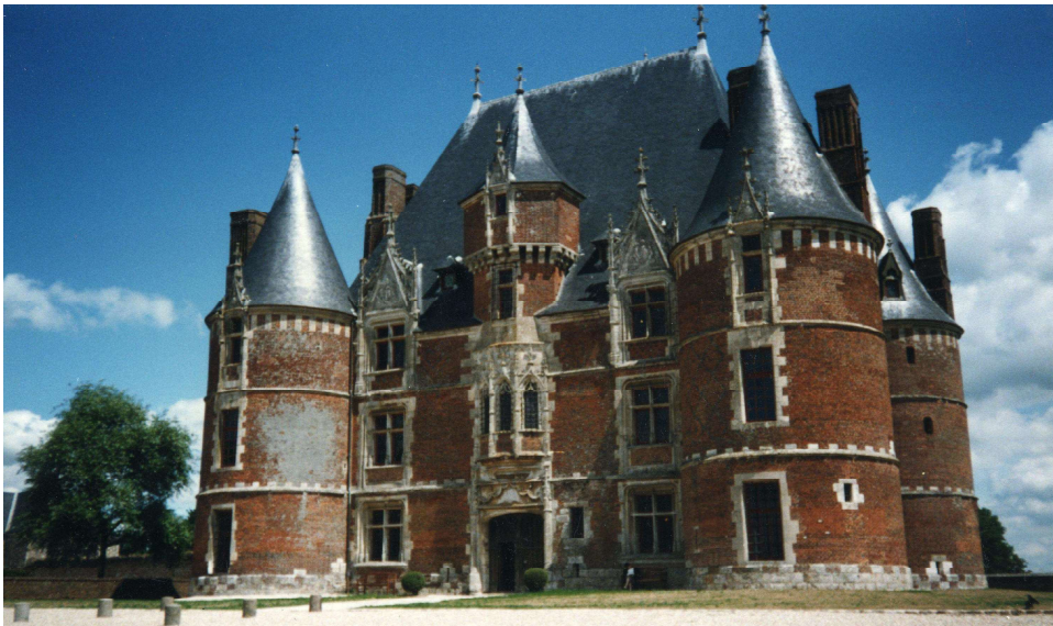
Fig. 478. Martainville. Façade principale (ouest) de la maison seigneuriale, état actuel.
