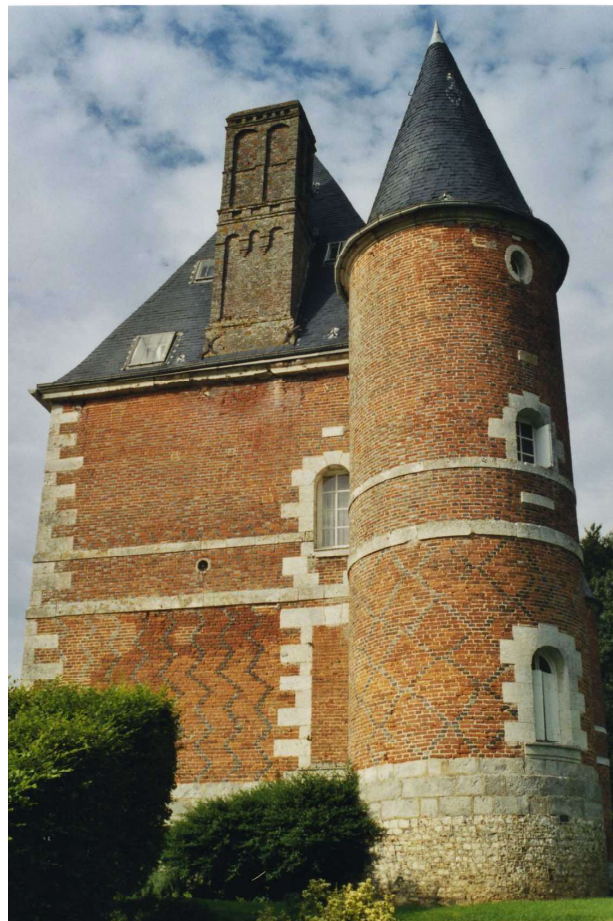
Fig. 560. Le Plain-Bosc. Bâtiment principal. Côté sud.
