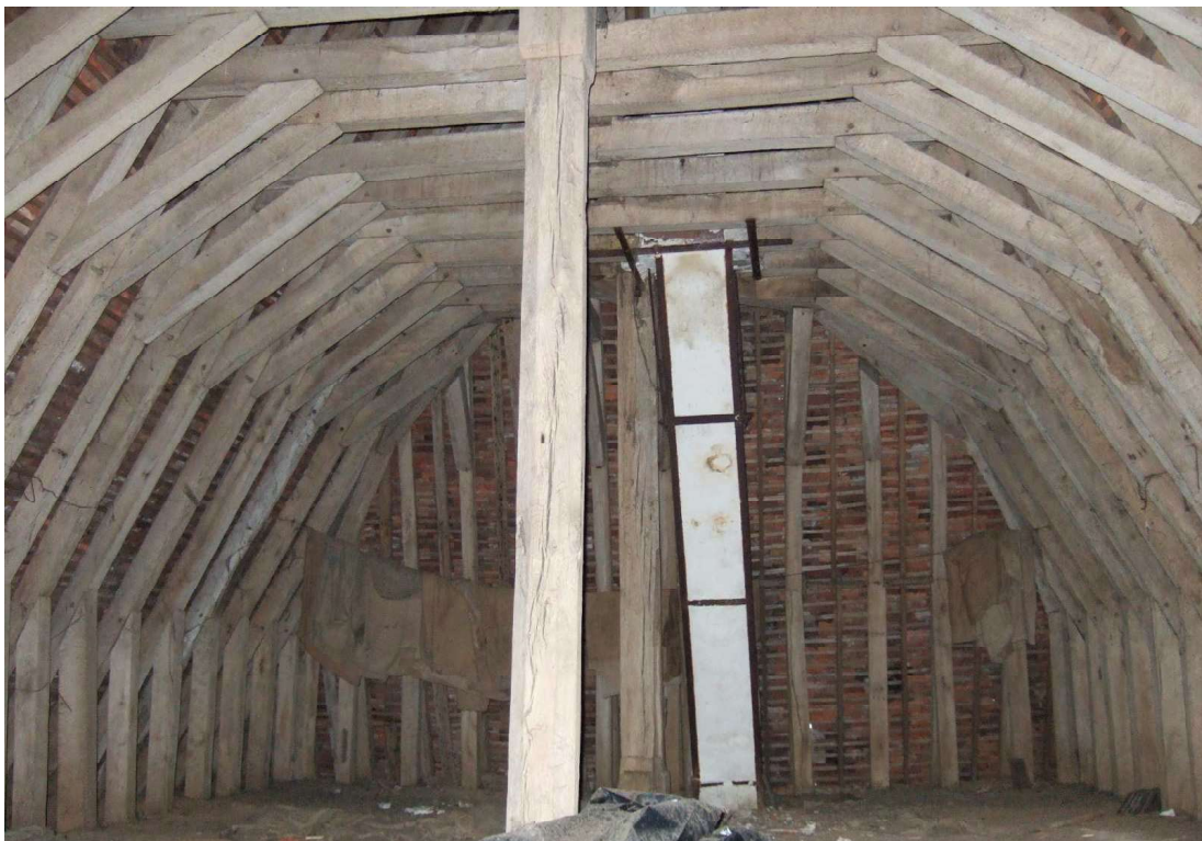
Fig. 447. Longuelune. Charpente du comble.
