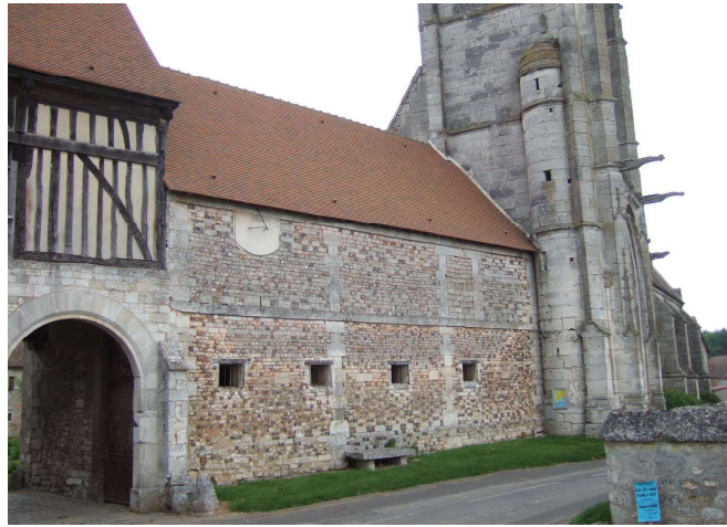
Fig. 501. Le Mesnil-Jourdain. Corps de bâtiment entre le corps de logis secondaire et l'église paroissiale. Elévation sur rue.
