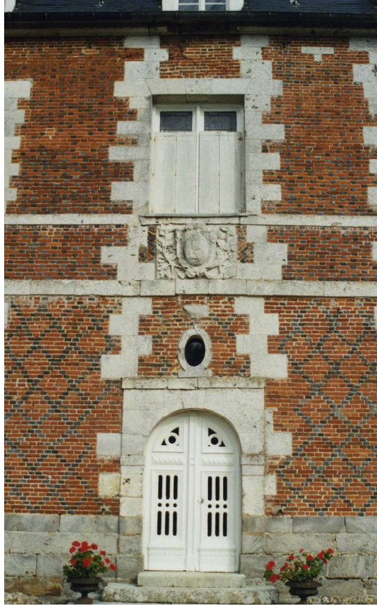
Fig. 557. Le Plain-Bosc. Bâtiment principal. Façade sur cour. Porte d'entrée.
