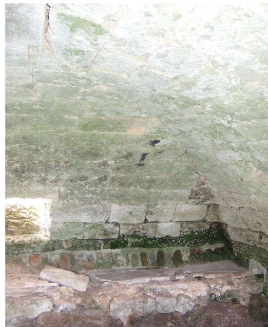
Fig. 483. Mentheville. Voûte de la cave semi-enterrée du colombier.
