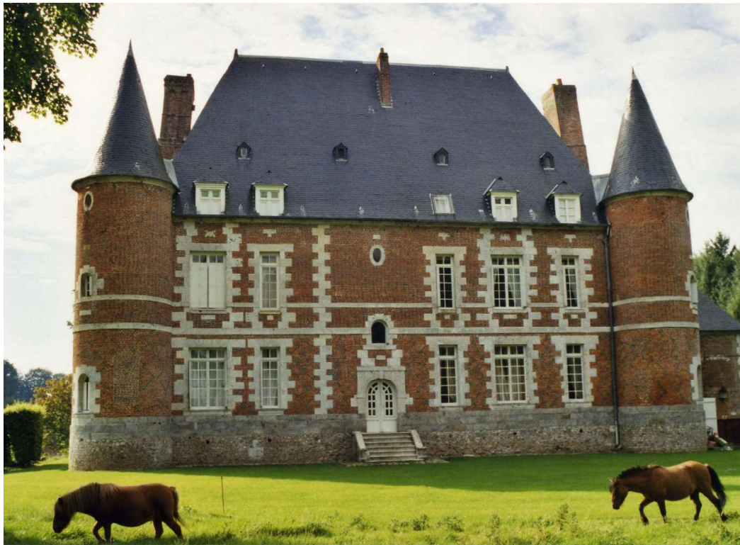
Fig. 558. Le Plain-Bosc. Bâtiment principal. Façade postérieure (est).
