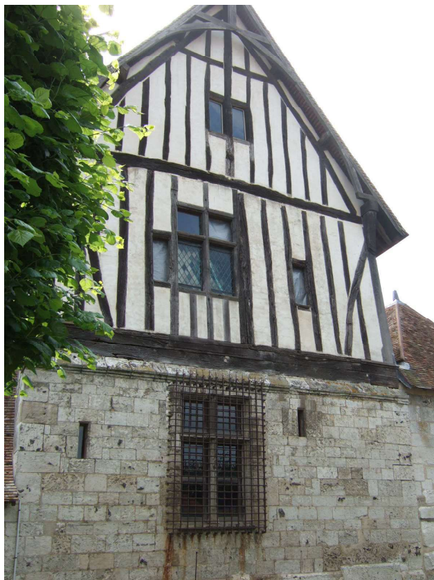
Fig. 401. Heubécourt. Bâtiment principal. Mur pignon oriental, état actuel.
