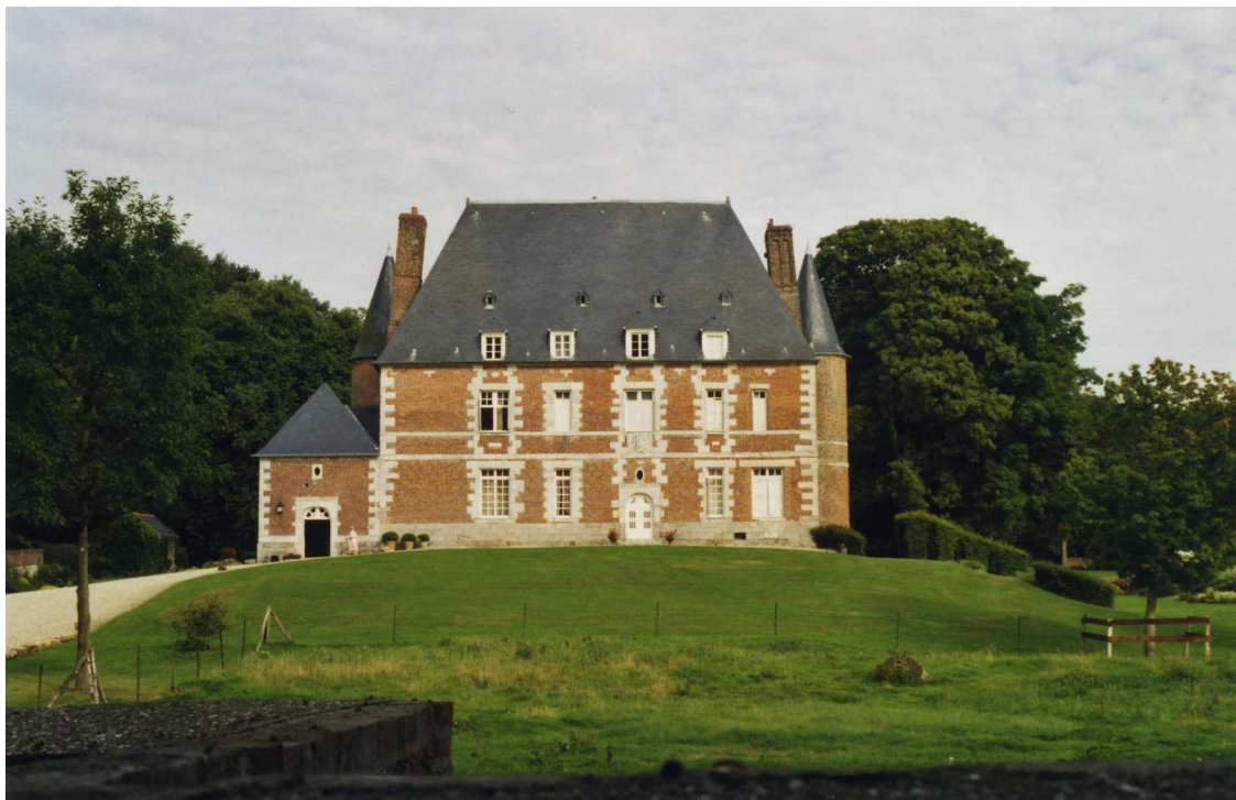
Fig. 556. Le Plain-Bosc. Le bâtiment principal vu à l'ouest.
