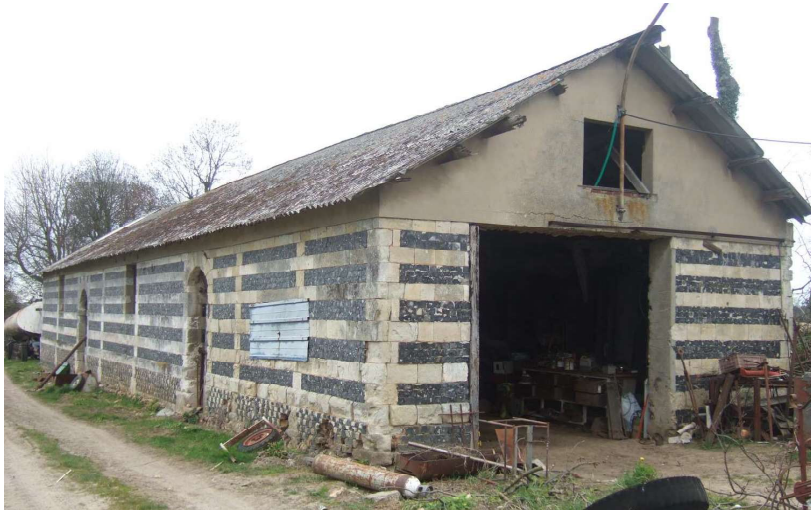
Fig. 376. Le Hérault. Bâtiment des écuries au nord de la cour, état actuel.
