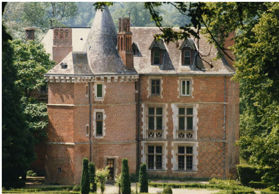
Fig. 535. Normanville. Bâtiment principal. Elévation postérieure (sud).
