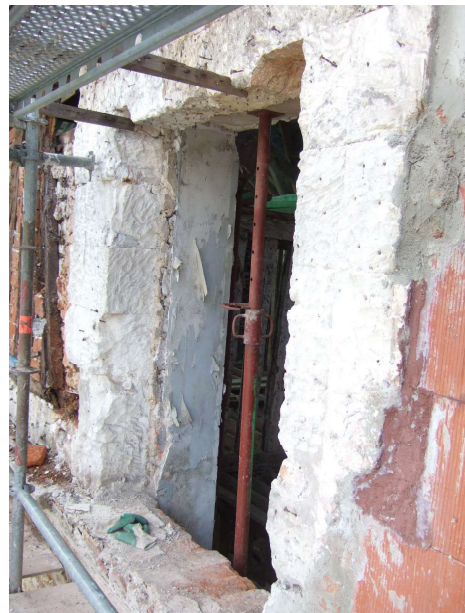
Fig. 527. Les Mottes. Vestiges d'un devant de lucarne de la façade sur cour, état en 2007.
