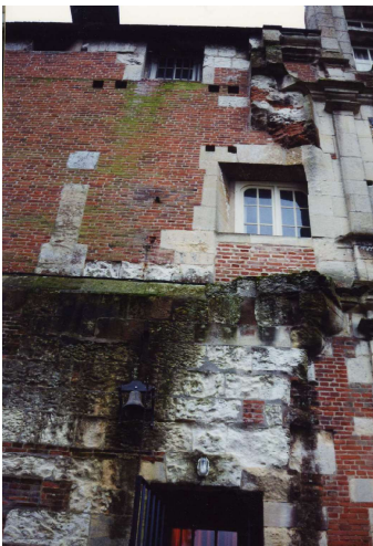
Fig. 591. Sénitot. Bâtiment principal. Partie gauche (est) de la façade postérieure.
