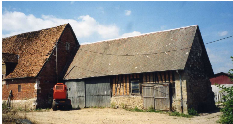
Fig. 539. Perriers-sur-Andelle. De gauche à droite : petite grange, remise et écuries.
