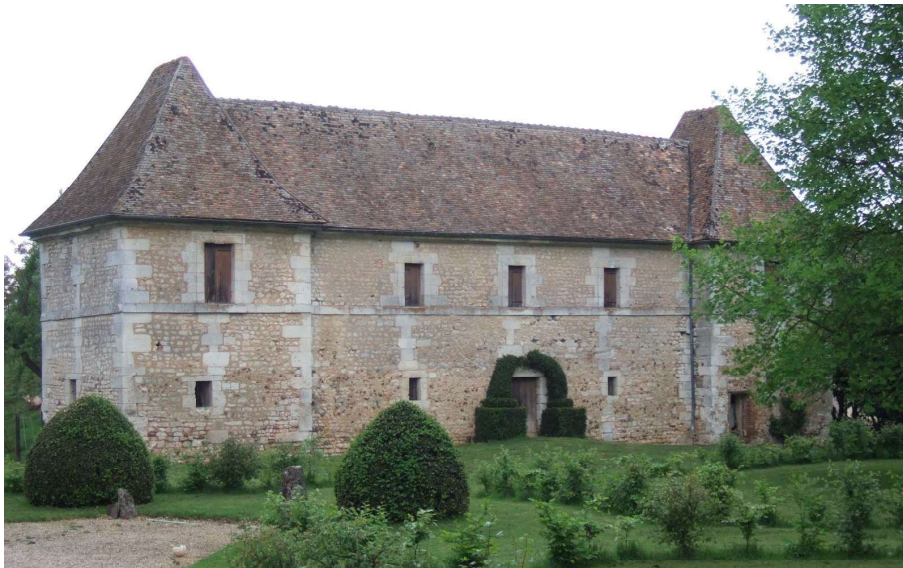
Fig. 505. Le Mesnil-Jourdain. Le « château » (élévation sud) vu de l'entrée dans la cour, état actuel.
