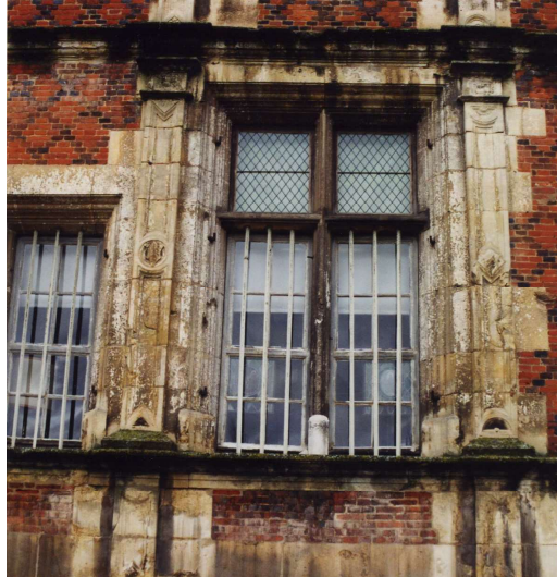
Fig. 586. Sénitot. Bâtiment principal. Façade principale. Fenêtres du rez-de-chaussée.
