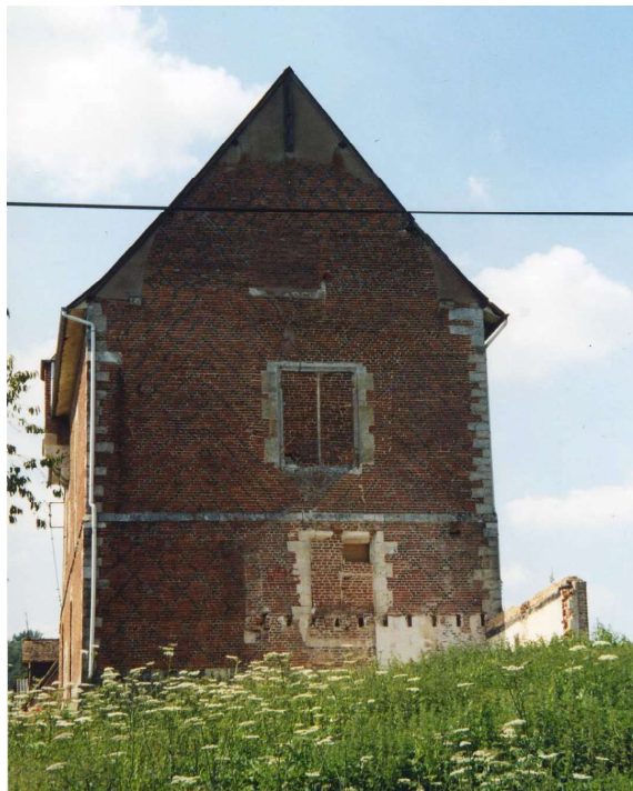
Fig. 544. Perriers-sur-Andelle. Bâtiment principal. Mur pignon vers la vallée de l'Andelle (est).
