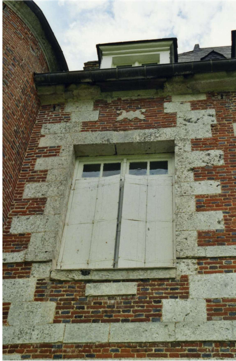
Fig. 559. Le Plain-Bosc. Bâtiment principal. Fenêtre de la façade postérieure.
