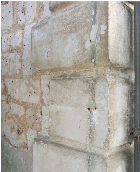
Fig. 526. Les Mottes. Chaîne d'angle harpée du corps central, état en 2007.
