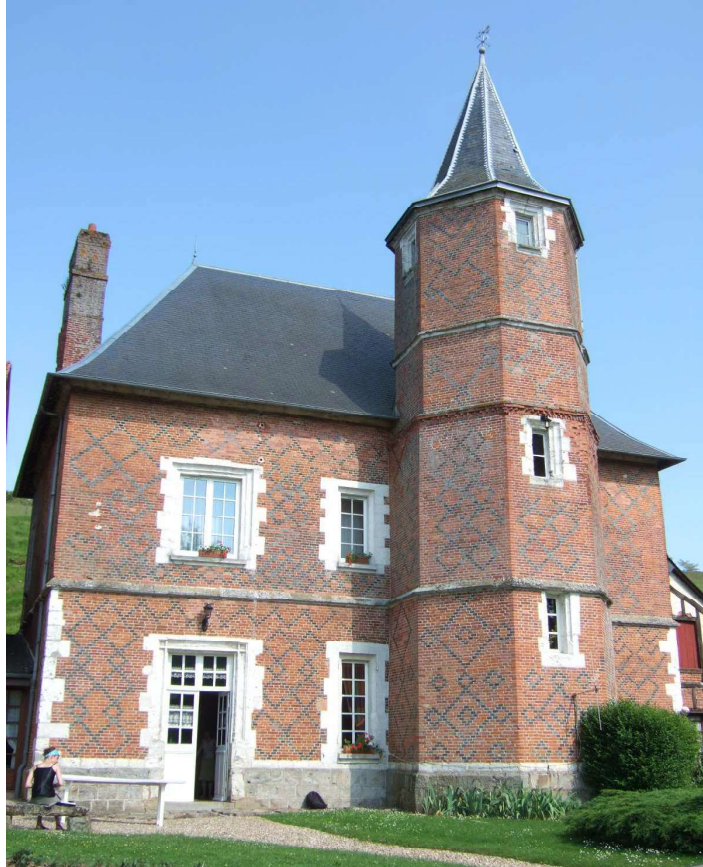
Fig. 381. Héronnelles. Façade antérieure du bâtiment principal.
