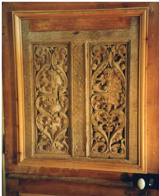
Fig. 575. Les Rocques. Bâtiment principal. Ancien châssis à claires-voies d'une fenêtre remonté dans une porte actuelle.
