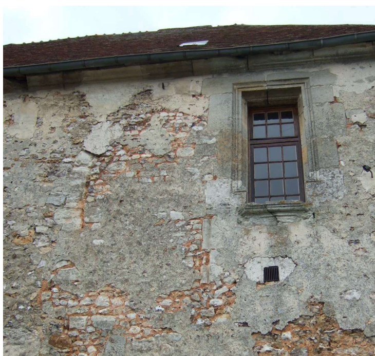
Fig. 566. Prey. Bâtiment principal. Façade principale. Fenêtre au premier étage. A gauche, la porte d'entrée murée du logis primitif.
