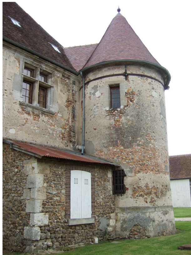
Fig. 568. Prey. Bâtiment principal. Façade postérieure (nord).
