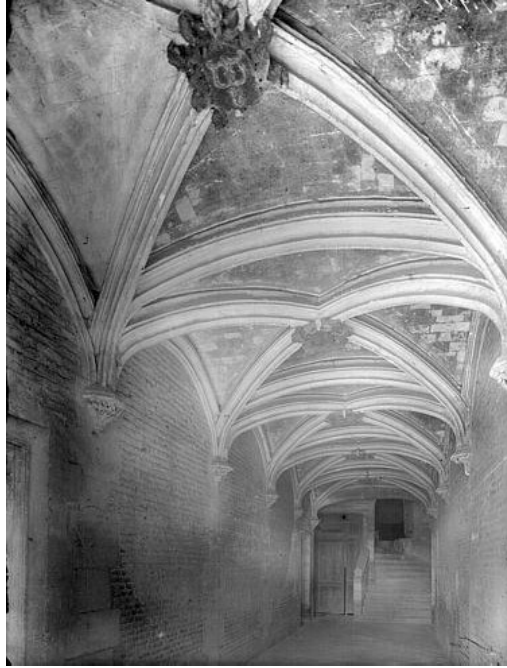
Fig. 477. Martainville. L' allée au rez-de-chaussée de la maison seigneuriale en 1920 (cliché MH 59981).
