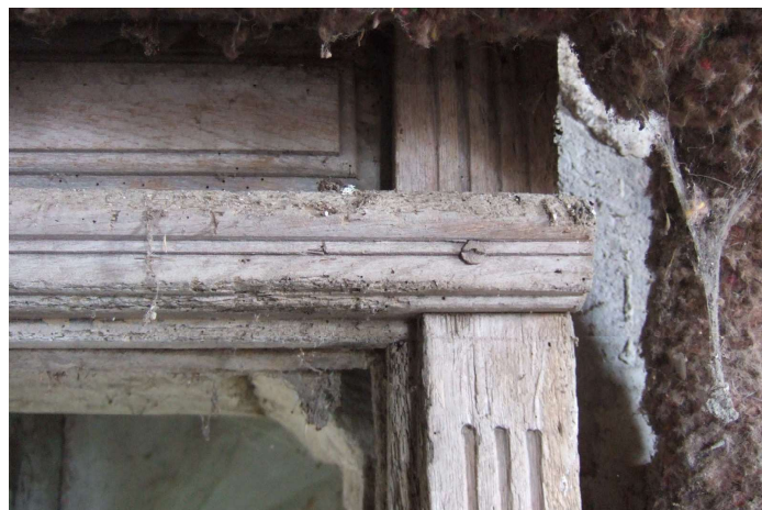
Fig. 490. Mentheville. Détail du chambranle en bois à l'entrée de la chambre sud au premier étage.
