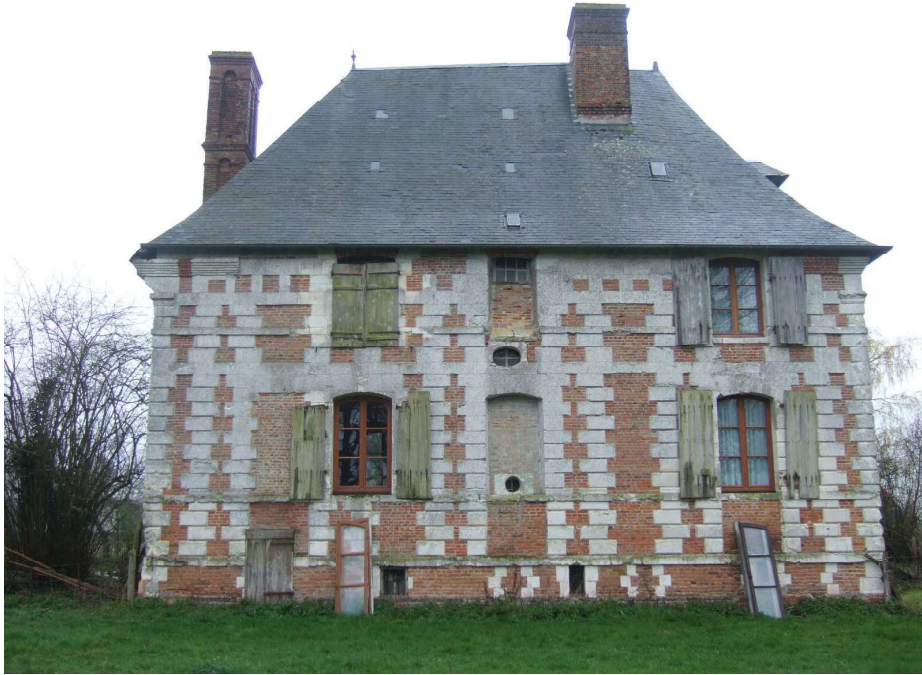
Fig. 427. Jouveaux. Façade postérieure de l'aile droite.
