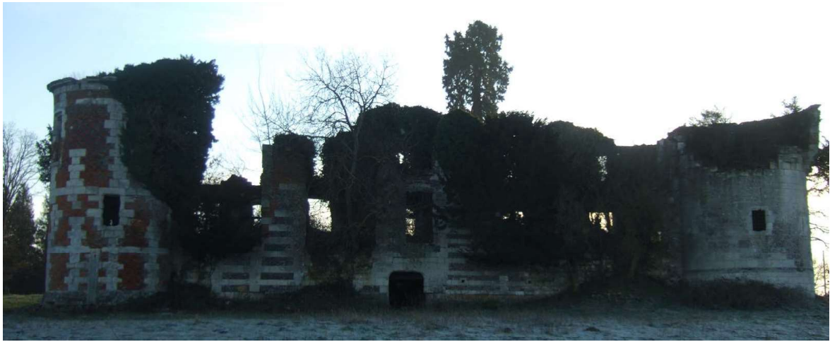
Fig. 417. Houlbec. Façade postérieure (ouest).
