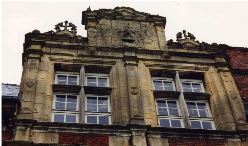
Fig. 587. Sénitot. Bâtiment principal. Grande lucarne au centre de la façade principale.
