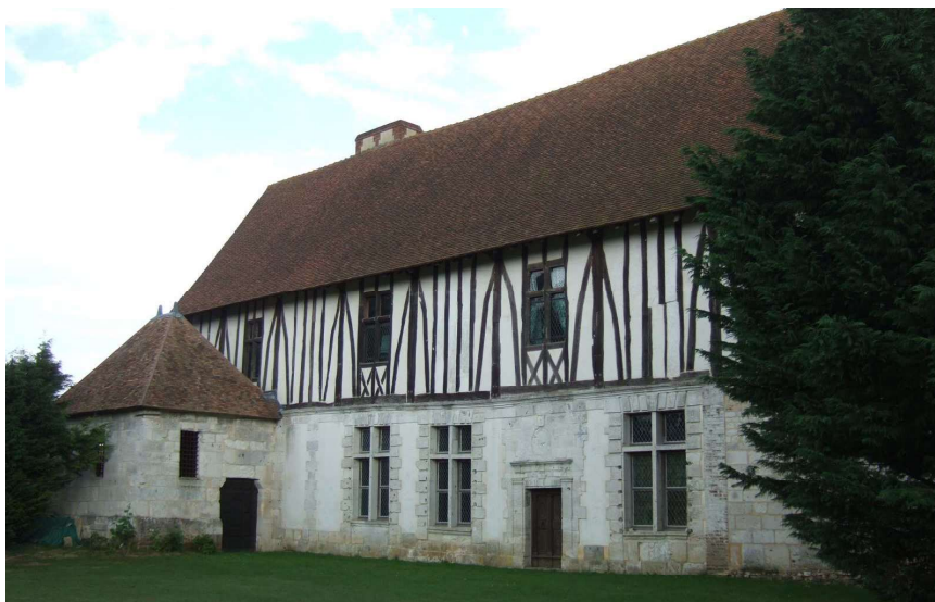
Fig. 398. Heubécourt. Bâtiment principal. Façade postérieure, état actuel.
