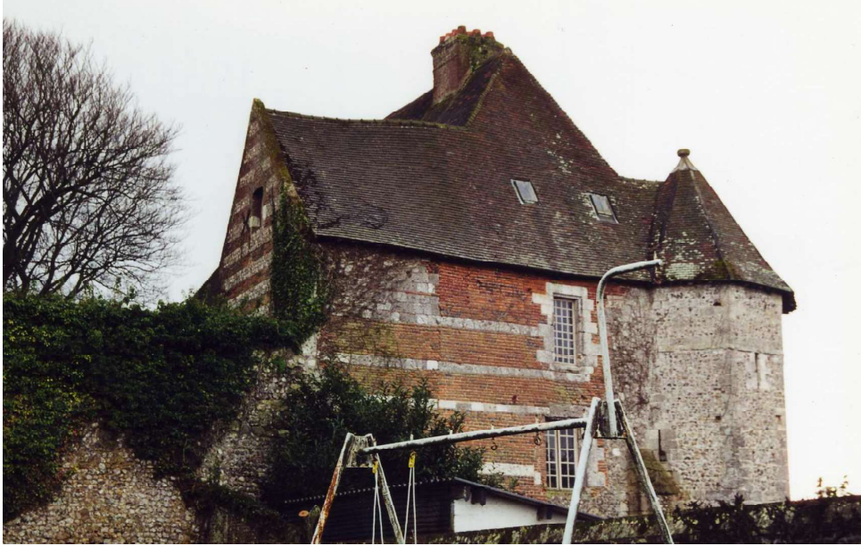
Fig. 432. Les Loges. Bâtiment principal vu au nord.
