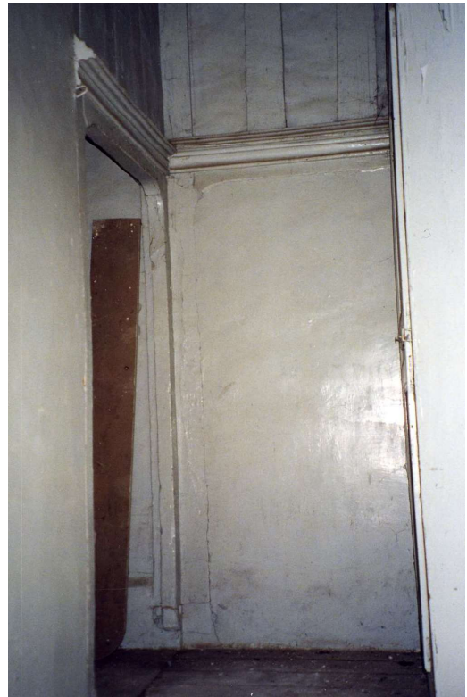
Fig. 551. Perriers-sur-Andelle. Bâtiment principal. Le petit espace de dégagement du premier étage : la porte de l'escalier à gauche, la porte (murée) de la grande chambre en face.
