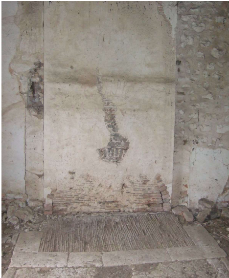
Fig. 511. Le Mesnil-Jourdain. Le « château ». Vestiges de la cheminée de la chambre du pavillon occidental.
