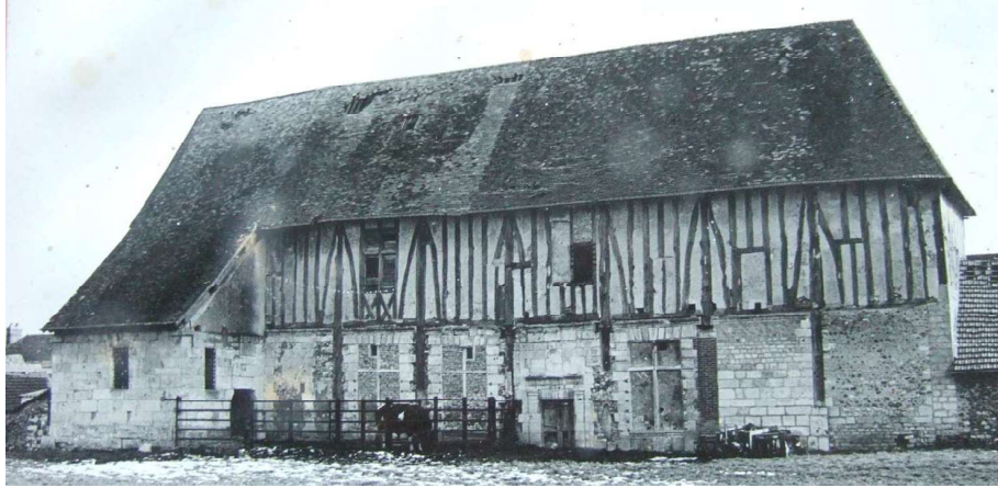
Fig. 397. Heubécourt. Bâtiment principal. Façade postérieure au début des années 1970 (Coll. part.).
