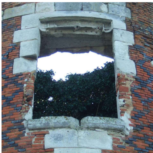
Fig. 419. Houlbec. Fenêtre au premier étage de la tourelle nord-ouest.
