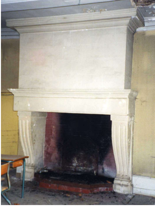
Fig. 528. Les Mottes. Cheminée de la grande salle , état en 2002.
