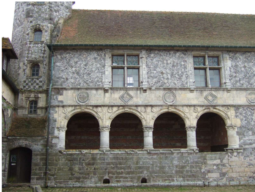
Fig. 459. Les Maillets. Le portique dans-cœuvre de l'aile méridionale.
