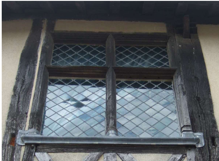
Fig. 392. Heubécourt. Fenêtre côté rue de la pièce au-dessus du porche d'entrée.
