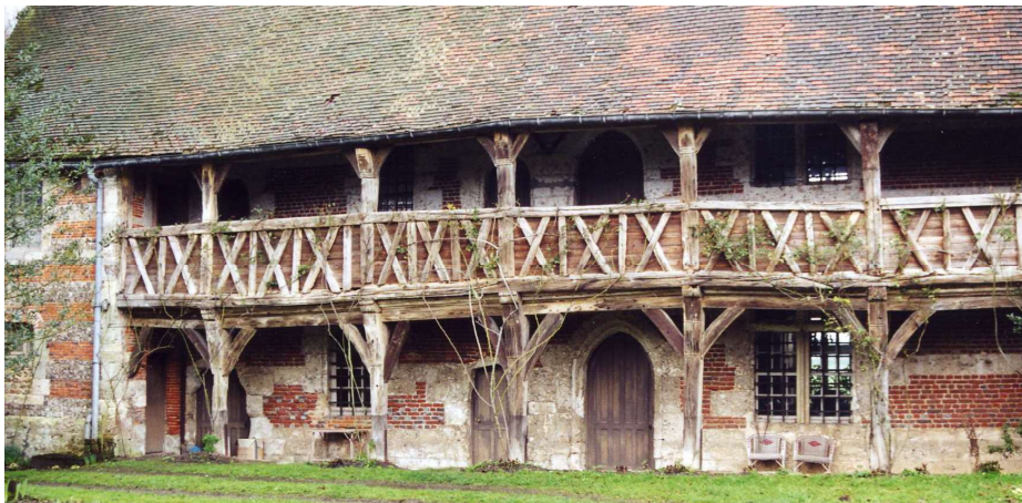
Fig. 434. Les Loges. Bâtiment principal. Façade sur cour (détail).
