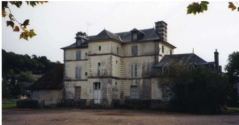
Fig. 525. Les Mottes. Bâtiment principal. Façade postérieure (nord-ouest), état en 2002.
