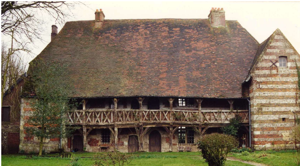
Fig. 433. Les Loges. Bâtiment principal. Façade principale sur cour (est).
