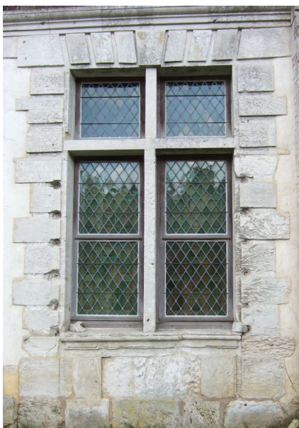
Fig. 399. Heubécourt. Bâtiment principal. Fenêtre côté jardin.
