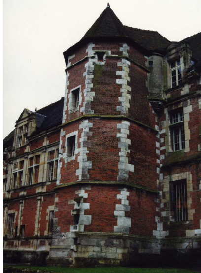
Fig. 589. Sénitot. Bâtiment principal. Tour d'escalier en façade postérieure (nord). En partie inférieure de la tour, vestiges du mur de clôture entre les deux jardins.
