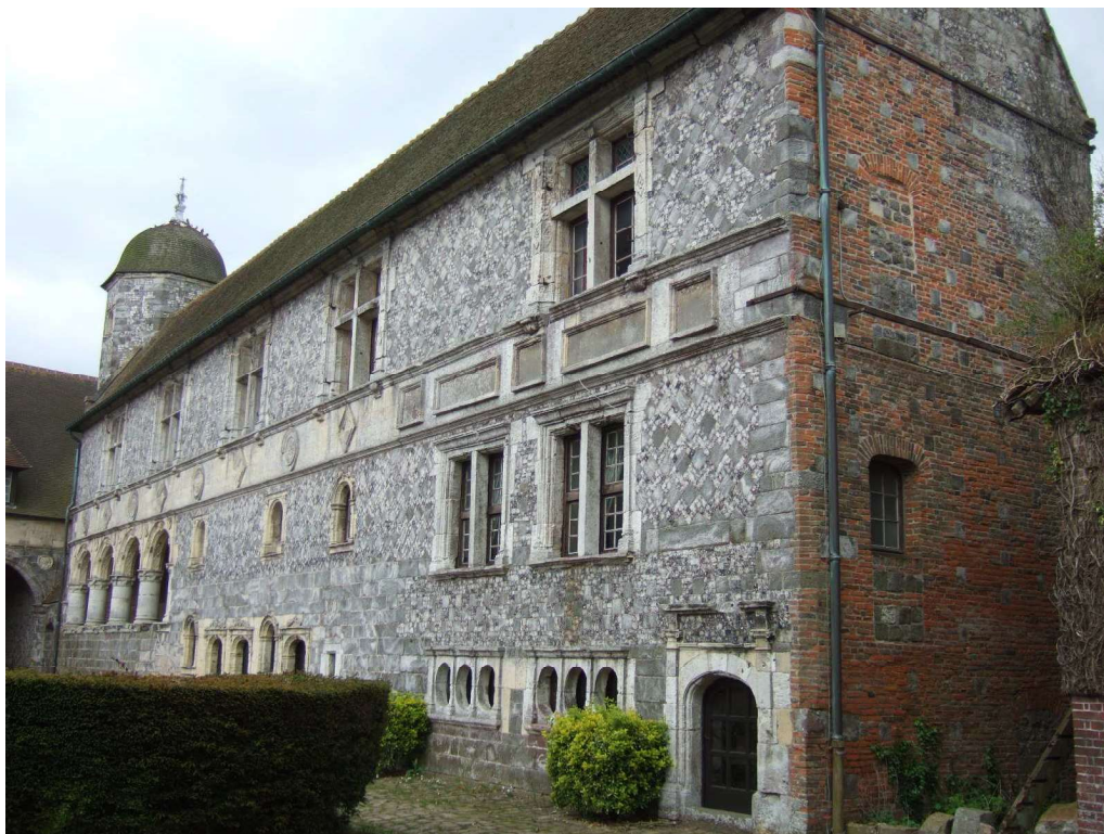
Fig. 460. Les Maillets. Façade de l'aile méridionale sur la cour. Les portes du mur pignon ouest, aujourd'hui murées, ouvraient autrefois sur un bâtiment disparu.
