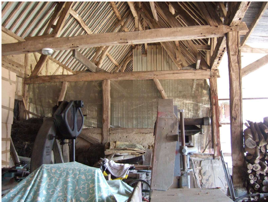
Fig. 387. Héronnelles. La grange. Les mortaises dans les sablières et les rainures aux poteaux indiquent la présence de cloisons en pans de bois fermant la grange côté cour et les emplacements des portes charretières.
