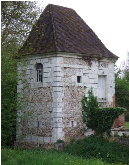
Fig. 522. Les Mottes. La chapelle à l'angle sud de la plate-forme.
