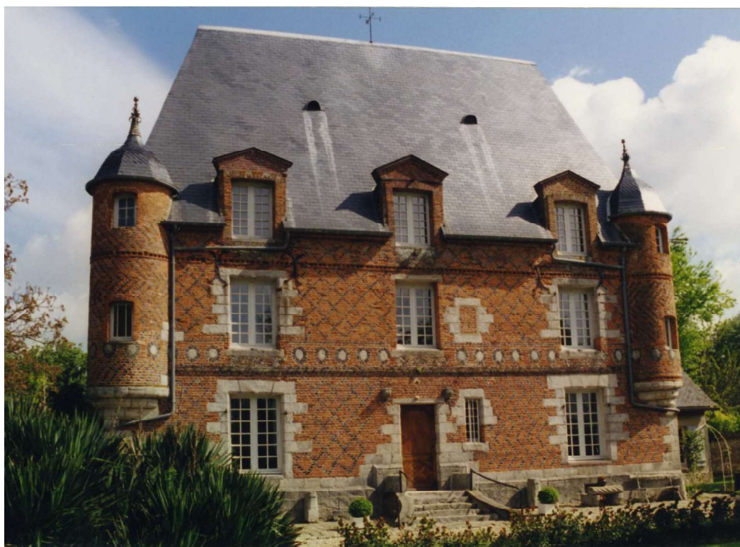
Fig. 578. Saffray. Bâtiment principal. Façade sur cour (sud.).
