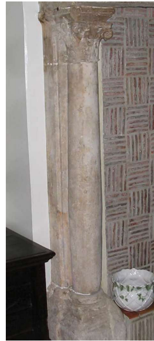
Fig. 406. Le Bus. Colonne corinthienne du piédroit gauche de la cheminée de la sallette .
