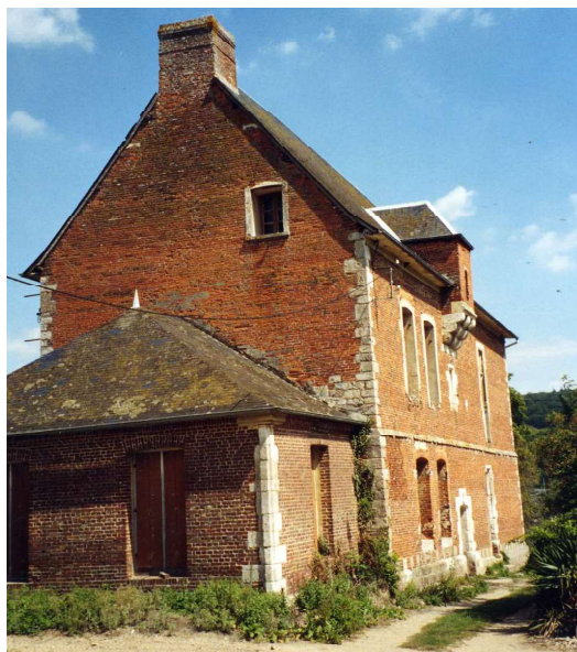
Fig. 540. Perriers-sur-Andelle. Bâtiment principal vu à l'ouest.
