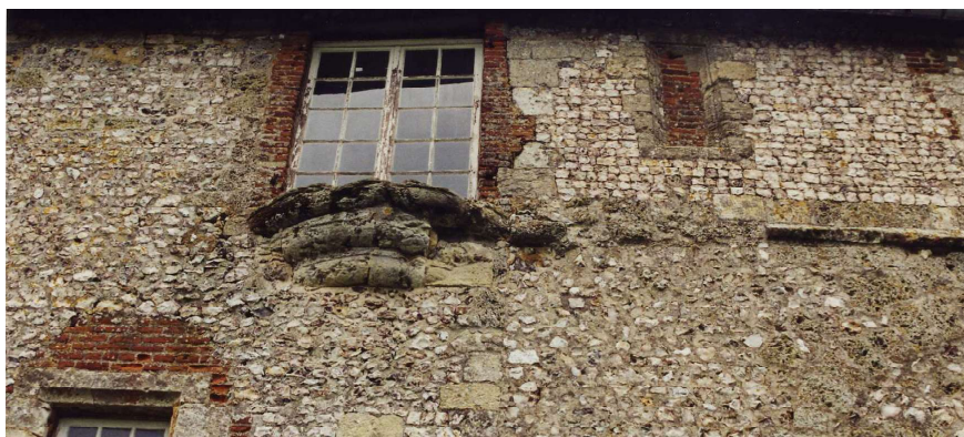
Fig. 431. Les Loges. Bâtiment principal. Façade postérieure. Cul-de-lampe, vestige d'une tourelle en encorbellement.
