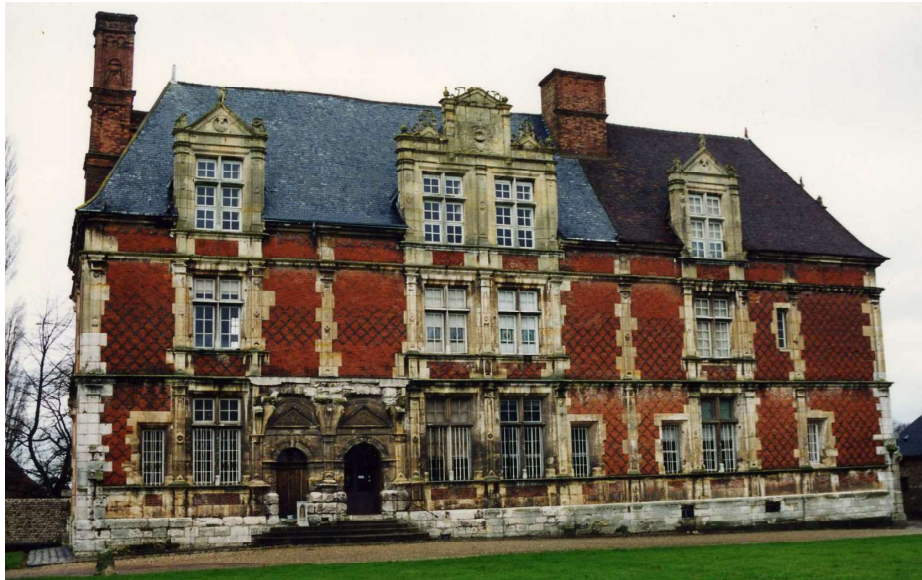
Fig. 584. Sénitot. Bâtiment principal. Façade principale (sud).
