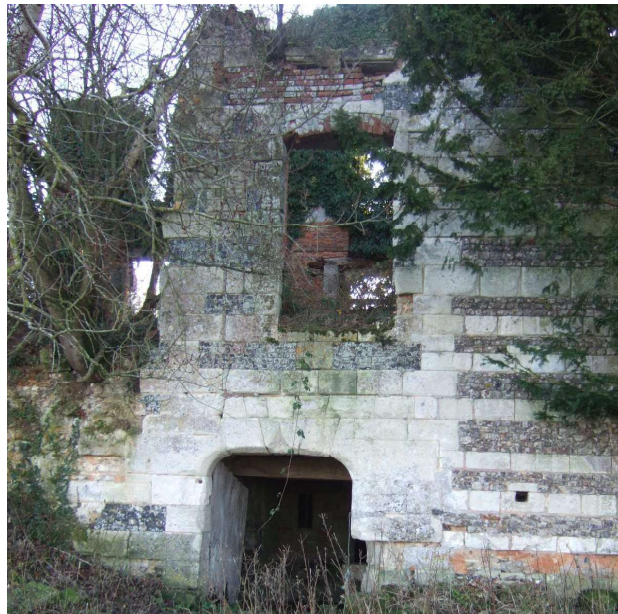
Fig. 418. Houlbec. Façade postérieure. Porte d'entrée du soubassement. A droite de la porte et de la fenêtre du rez-de-chaussée, le raccord de maçonnerie entre les parties septentrionale et méridionale du bâtiment.
