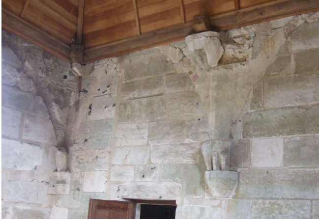
Fig. 410. Heubécourt. La Chapelle. Vestiges de la voûte.
