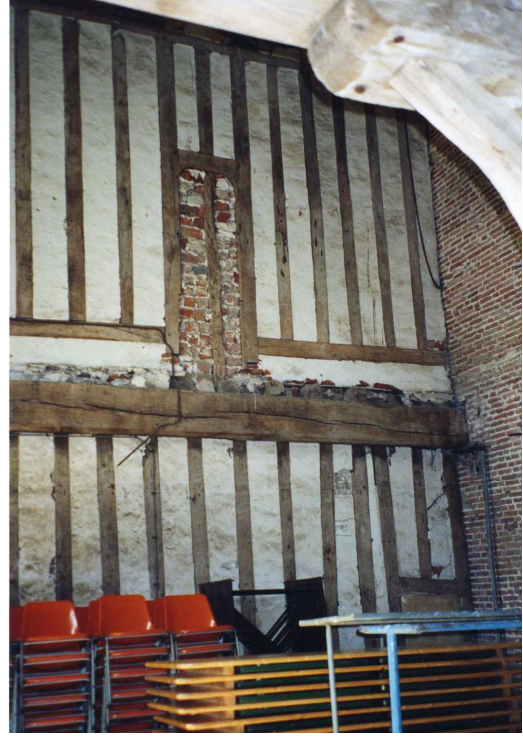
Fig. 549. Perriers-sur-Andelle. Bâtiment principal. Cloison de refend occidental de la grande salle et de la grande chambre .
