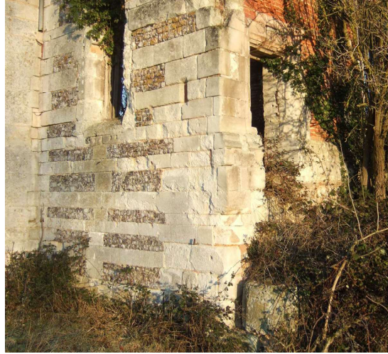
Fig. 416. Houlbec. Mur pignon sud (à gauche) et extrémité de la façade sur cour (à droite).
