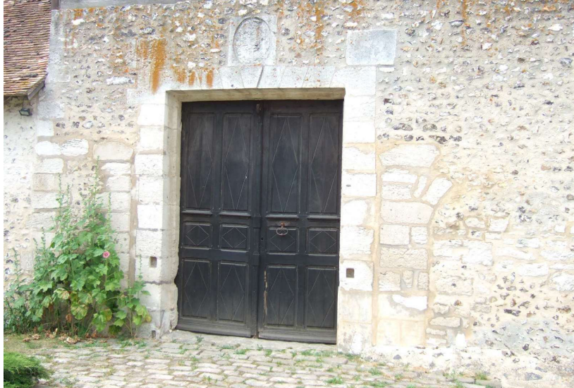
Fig. 391. Heubécourt. Portail d'entrée, état actuel.
