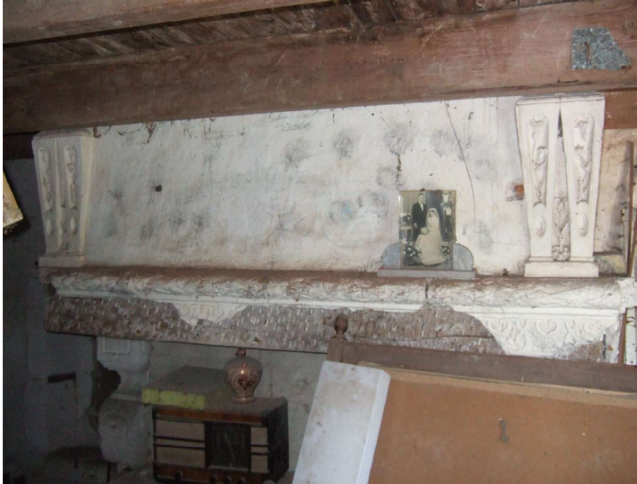
Fig. 374. Le Hérault. Cheminée à décor en stuc de la chambre sud.
