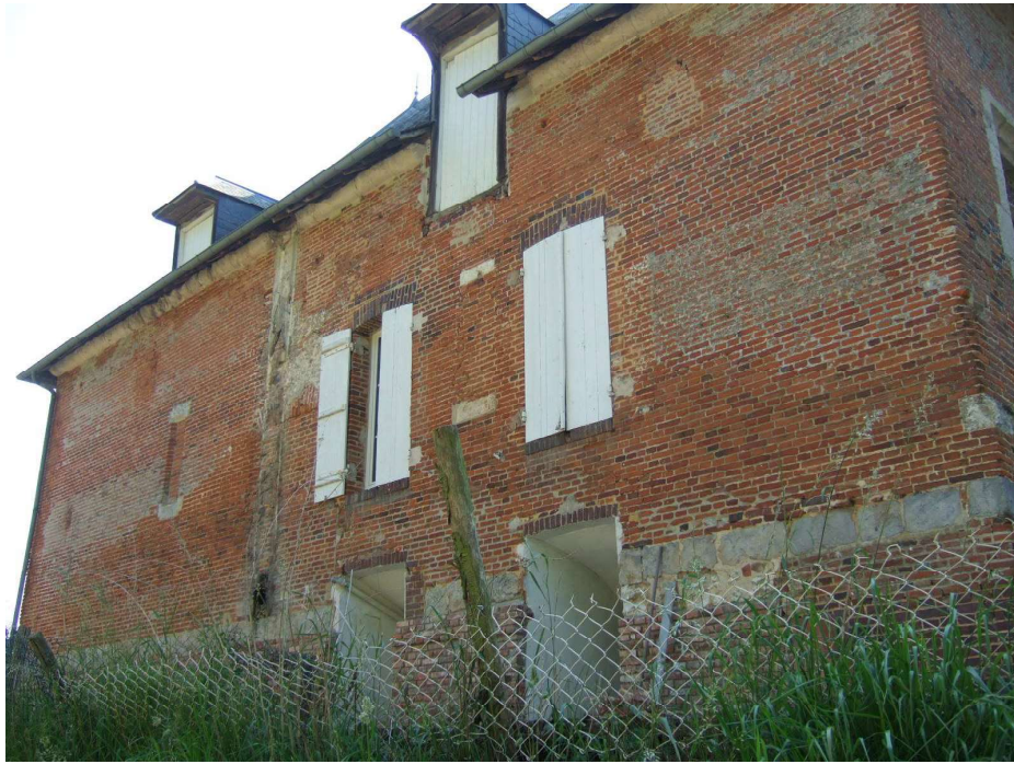
Fig. 383. Héronnelles. Façade postérieure. (Les terres du coteau s'élevaient autrefois jusqu'au bandeau en grès.)
