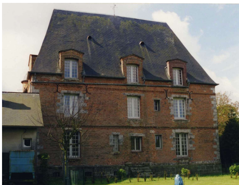
Fig. 580. Saffray. Bâtiment principal. Façade postérieure (nord).
