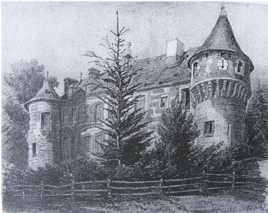
Fig. 413. Houlbec. Façade postérieure de la maison seigneuriale. Dessin d'Amédée de La Rousserie, daté du 30 septembre 1847 (publié par LIZOT 1981).
