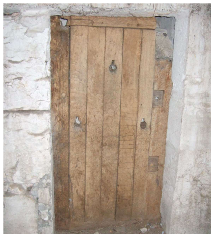
Fig. 503. Le Mesnil-Jourdain. Premier étage. Vantail de la porte ouvrant sur l'église paroissiale (munie de trois petites ouvertures de tir à fente de visée verticale).
