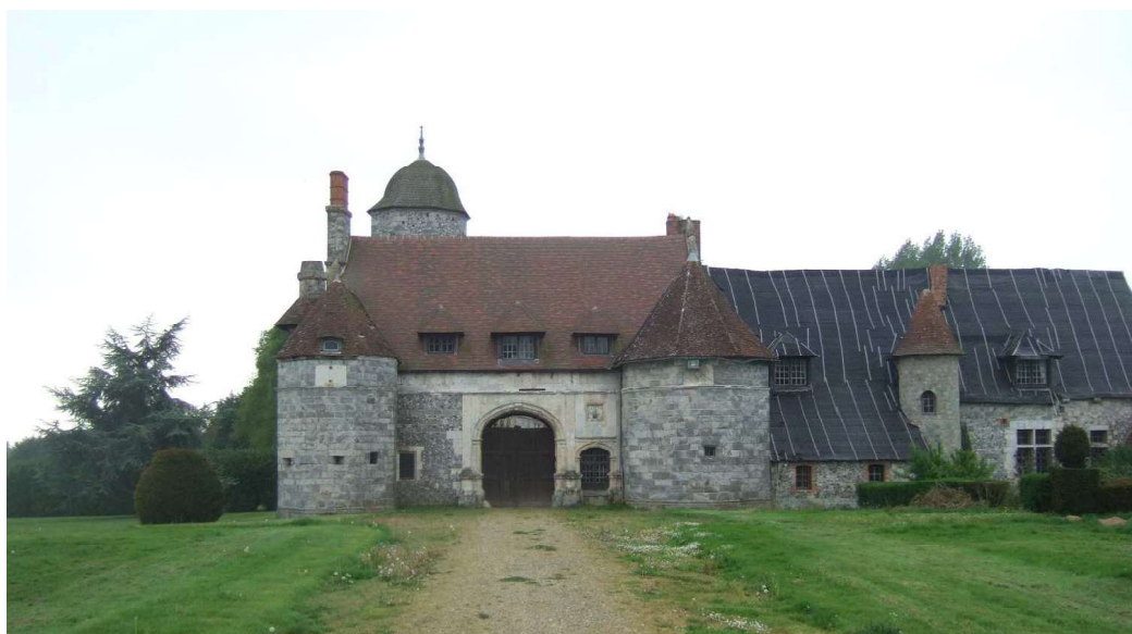
Fig. 453. Les Maillets. Bâtiment principal vu à l'est.
