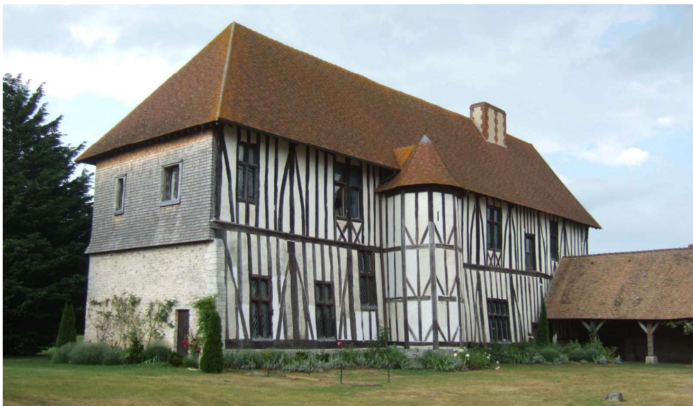
Fig. 396. Heubécourt. Bâtiment principal vu dans la cour, état actuel.
