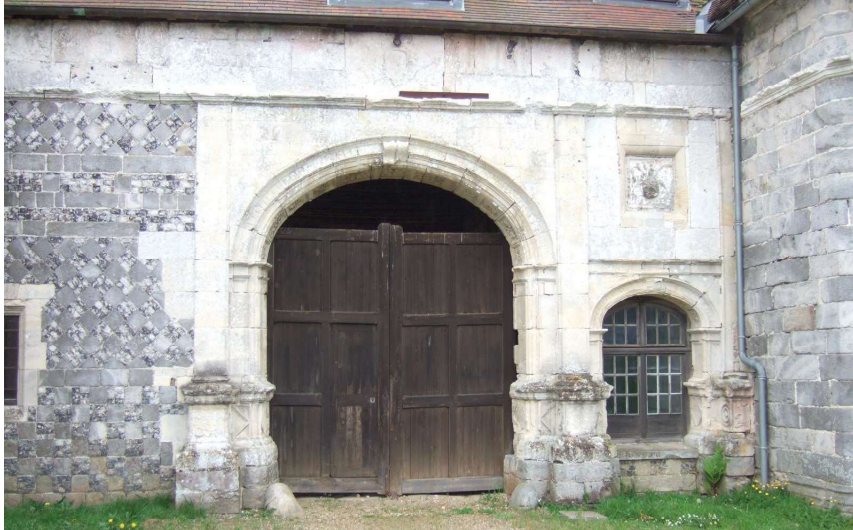
Fig. 454. Les Maillets. Bâtiment principal. Portail d'entrée. Les écus au-dessus des deux portes sont martelés. Les piédestaux et leurs bases de chaque côté des entrées portaient des colonnes en délit aujourd'hui disparues.
