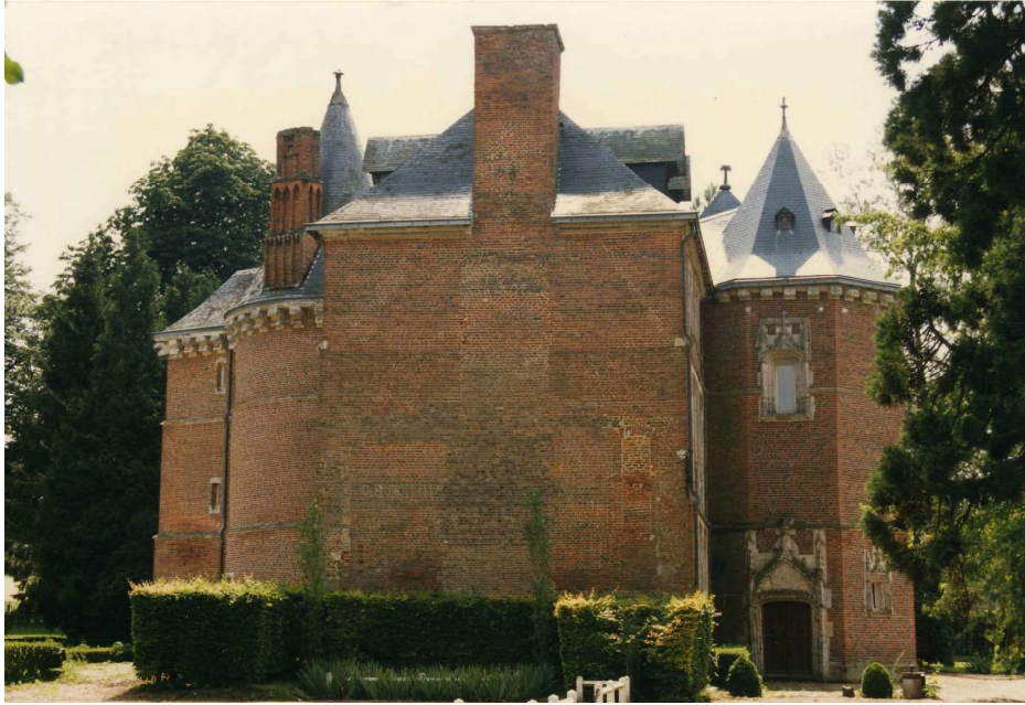
Fig. 534. Normanville. Bâtiment principal vu à l'est.
