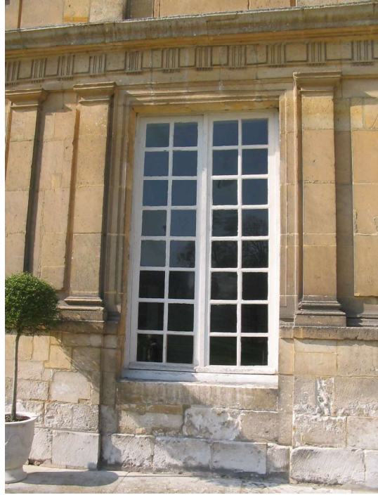
Fig. 602. Le Taillis. Façade sud. Fenêtre du rez-de-chaussée.
