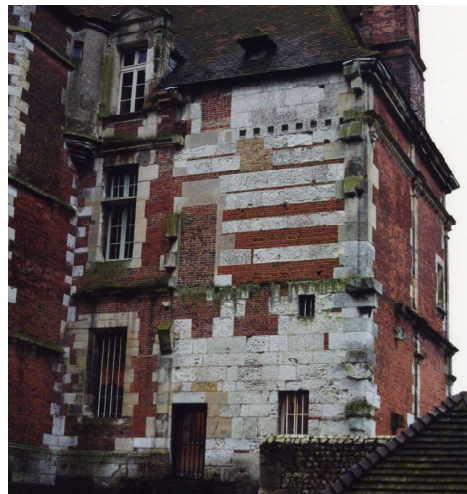
Fig. 592. Sénitot. Bâtiment principal. Partie droite (ouest) de la façade postérieure.
