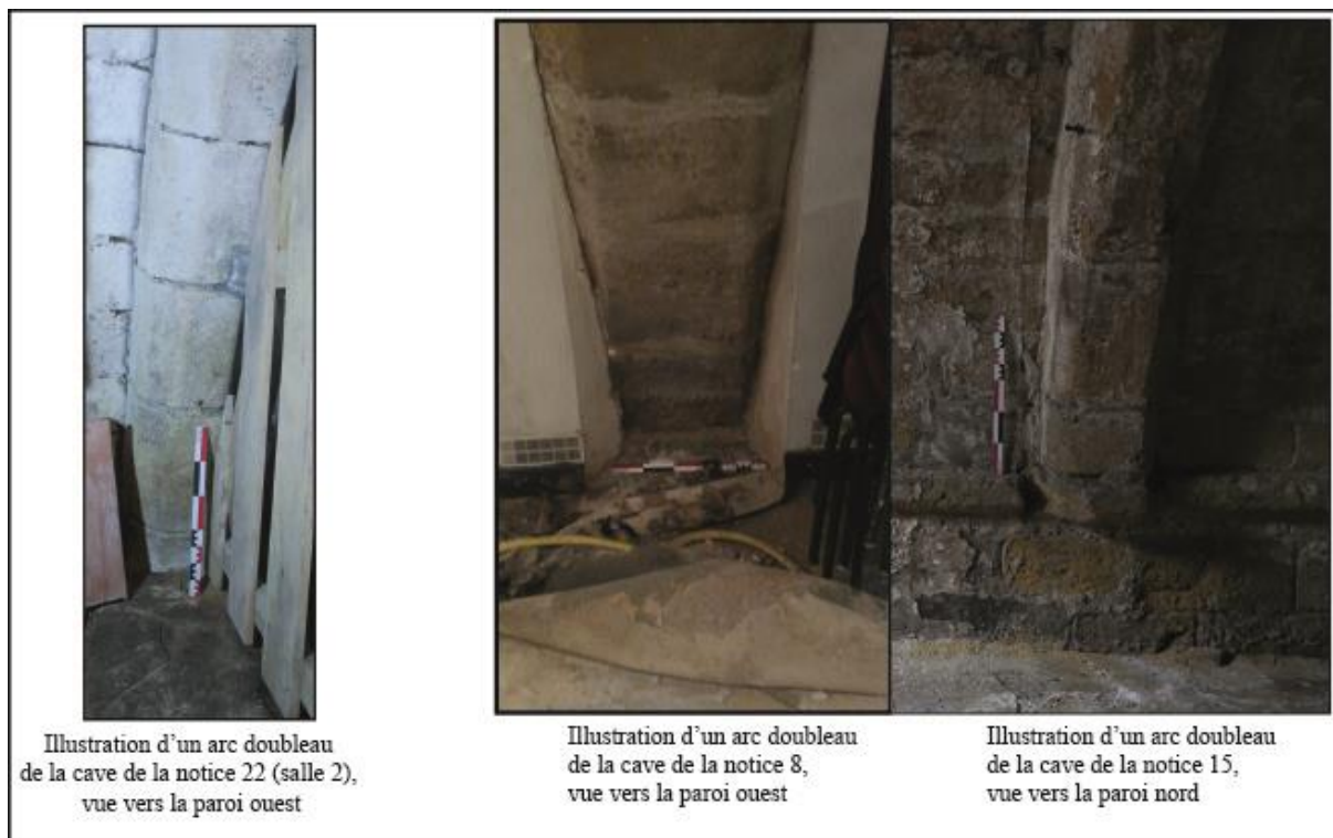
Figure 22 : Illustration des arcs doubleaux associés aux voûtes en berceau des caves des notices 8, 15 et 22 (salle 2) (clichés L. Maguier)
