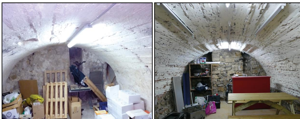
1 : empreintes des couchis sur l'intrados de la voûte de la cave de la notice 13, vue vers le sud-ouest
