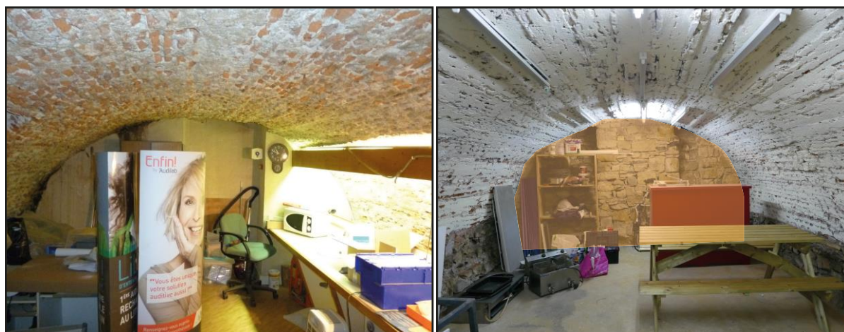
1 : voûte en brique de la cave de la notice 9, vue vers le sud-ouest
