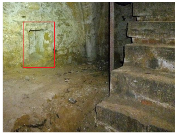
Localisation de la petite niche murale à proximité de l'escalier d'accès dans la cave du 19, rue Lagréou (notice 10)
