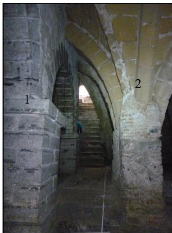
Notice 10 : 1= pilier et arcade en pierre de Bidache 2 = maçonnerie en pierre de Mousserolles
