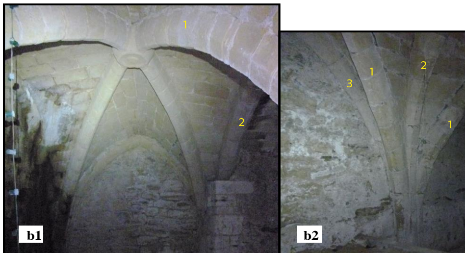
b1 et b2 illustration d'une voûte avec ogives (1) et arcs doubleaux (2) moulurés en tore associés à des arcs formerets (3) chanfreinés, notice 10 (19, rue Lagréou), vue vers le sud (b1) et l'est (b2)
