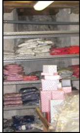
62, rue d'Espagne (notice 6), soupirail à glacis haut, vue vers l'ouest
