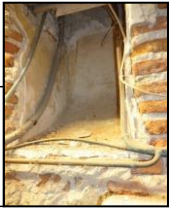
6, place Louis Pasteur (notice 9), ouverture du soupirail conique, vue vers l'ouest
