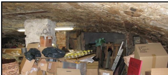
exemple n°1 : voûte maçonnée en pierre de Mousserolles de la cave de la notice 3 (3, place Louis Pasteur), vue vers l'est
