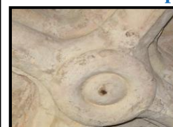
d1 notice 5 (7, rue du Pilori)
