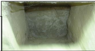
6, place Louis Pasteur (notice 13), ouverture du puits d'aération conique, vue vers l'ouest
