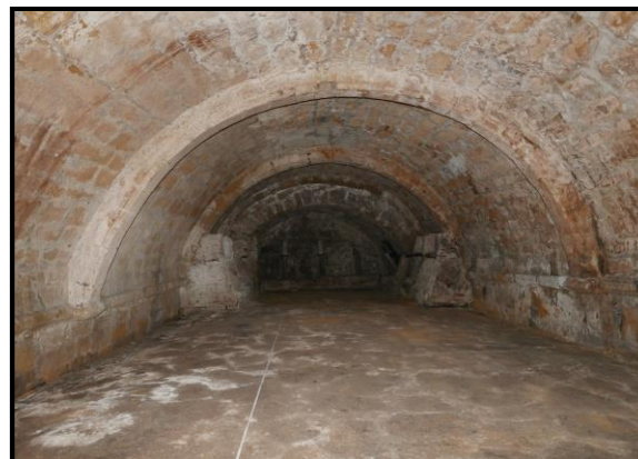
voûte maçonnée en pierre de Mousserolles de la cave de la notice 15 (5, rue de la Monnaie), vue vers l'est (il s'agit de l'exemple le plus complet que nous ayons rencontré)
