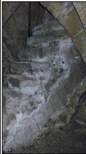
Illustration du mur de soutènement avec arc rampant compris dans sa maçonnerie, escalier sur rue dans la cave du 19, rue Lagréou (notice 10), vue vers le nord-ouest
