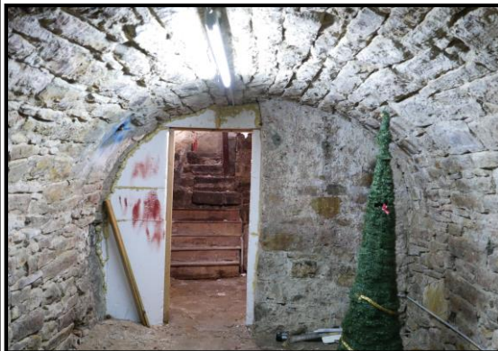
exemple n° 1 : voûte maçonnée en pierre de Mousserolles de la cave de la notice 16 (40, rue d'Espagne), vue vers l'est
