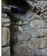
51, rue des Faures (notice 21), illustration d'un des soupiraux à glacis haut, vue vers l'est
