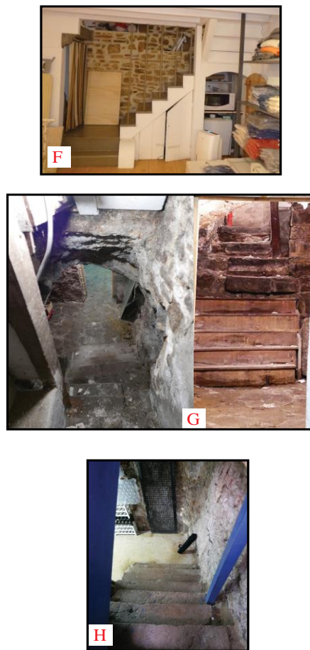
F : Escalier d'accès à la cave du 7, rue de Luc G : Escalier d'accès à la cave du 40, rue d'Espagne H : Escalier d'accès à la cave du 51, rue des Faures
