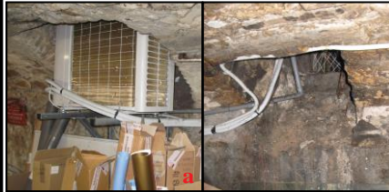
3, place Louis Pasteur (notice 3), ouvertures des soupiraux coniques, vue vers le sud, photo a : soupirail agrandi après la construction de la cave
