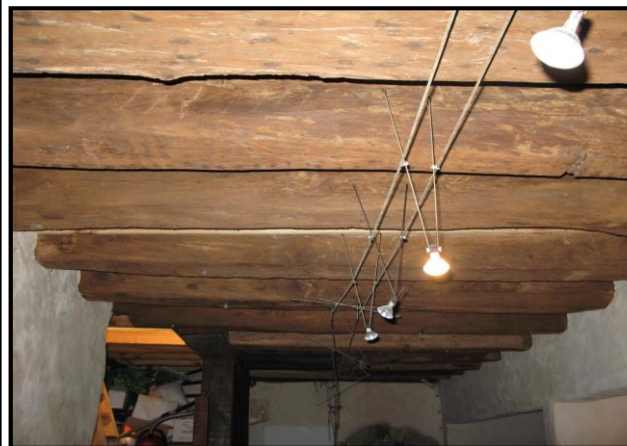
exemple n° 2 : plafond en bois de la salle 1 de la notice 7 (5, rue du Pilori), vue vers le sud
