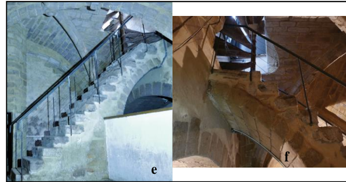
Illustrations de la voûte soutenant l'escalier sur rue dans la cave du 5-7, rue Lagréou (notice 19), photo e vue vers l'ouest, photo f vue vers l'est
