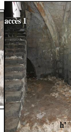
Illustrations des voûtes soutenant les escaliers sur rue dans la cave du 2, rue Montaut (notice 20), photo g vue vers le nord-est (accès 2), photo h et h' vues vers le sud-ouest (accès 1)
