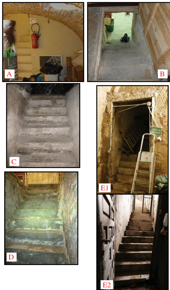
A : Escalier d'accès à la cave du 6, place Louis Pasteur (1) B : Escalier d'accès à la cave du 6, place Louis Pasteur (2) C : Escalier d'accès à la cave du 2, place Louis Pasteur D : Escalier d'accès à la cave du 21, rue Lagréou E1 : Escalier abandonné à la cave du 1, place du Château-Vieux E2 : Escalier d'accès actuel à la cave du 1, place du Château-Vieux
