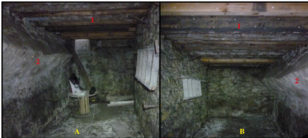
exemple n° 1 : plafond en bois (1) qui couvre la cave de la notice 11 (21, rue de Luc) et le départ de voûte (2) le long de la paroi ouest, vue vers le nord (A) et le sud (B)
