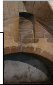
51, rue des Faures (notice 21), illustration d'un des soupiraux à glacis haut, vue vers l'est
