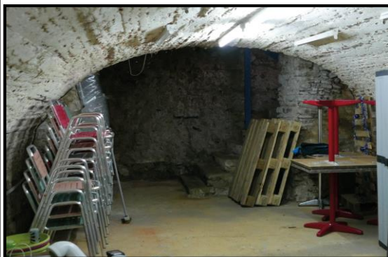
exemple n° 2 : voûte maçonnée en brique de la cave de la notice 21 (51, rue des Faures), vue vers l'ouest (avec aplatissement de la voûte au sud)
