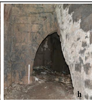
Illustrations des voûtes soutenant les escaliers sur rue dans la cave du 2, rue Montaut (notice 20), photo g vue vers le nord-est (accès 2), photo h et h' vues vers le sud-ouest (accès 1)
