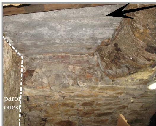
Trémie B percée dans la voûte et adjacente à la paroi ouest de la cave
