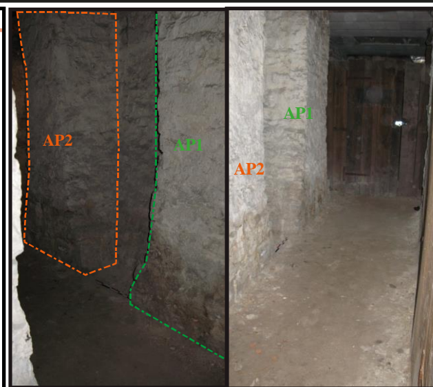
Illustration des avancées de parois au niveau de la paroi P4, couloir 1 (vue vers le sud et vue vers l'ouest)
