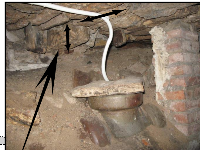
Illustration de la portion est de la voûte où certains moellons présentent une orientation différente du reste de la voûte.
