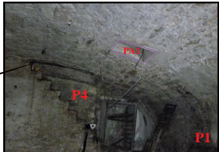
Maçonneries de la voûte, des parois P1, P2 et P4, puits d'aération et accès actuels
