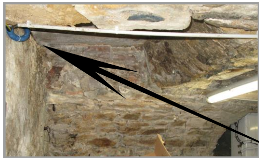
Trémie B percée dans la voûte et adjacente à la paroi ouest de la cave
