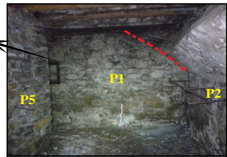
Illustration des maçonneries (parois P1, P5, P2) et du départ de voûte en berceau, vue vers le sud ----- Tracé laissé par la voûte dans la maçonnerie de la paroi P1
