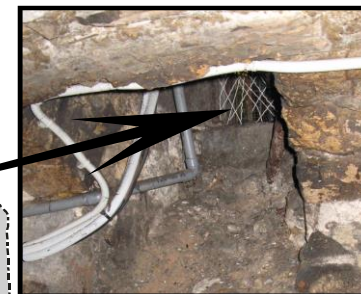
Sopirail 2 vue de l'intérieur de la cave
