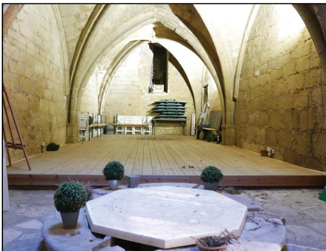
Illustration des maçonneries de la voûte et des parois, puits central et ouverture vers l'intérieur de la parcelle (vestige d'ouverture sur cour ?), vue vers l'ouest
