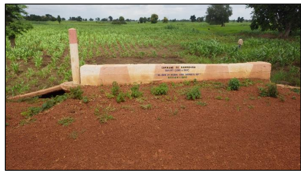
Photo 12 : Construction récente d'un min-pont sur une piste à proximité d'un champ de sorgho d'Arbonga (Banikoara) en 2017. (Koukpéré 2018).
