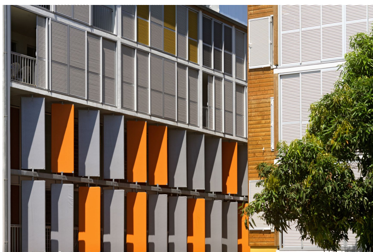
FIGURE 2.2 – Vue sur façade Sud Sud-Ouest de l'Ilet du Centre. Brises-soleil verticaux inclinés. Crédit image : Hervé Douris
