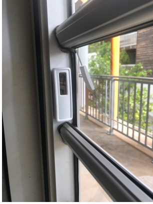
FIGURE 2.8 – Contact magnétique en position 0 "ouverte"
