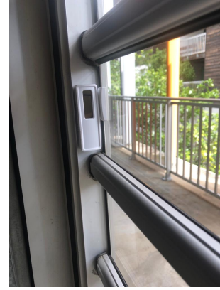
FIGURE 2.9 – Contact magnétique en position 1 "fermée"
