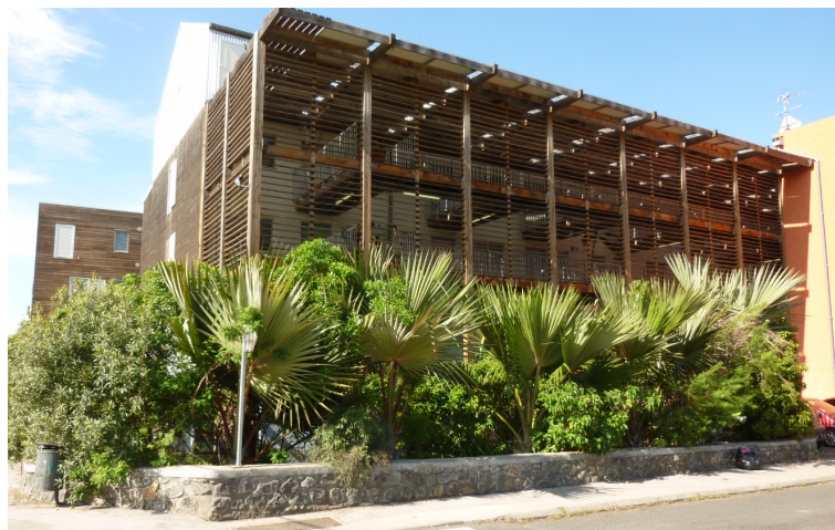
FIGURE 2.1 – Vue sur façade Nord Nord-Est de l'Ilet du Centre. Débord horizontal en bois couplé à des brises-soleil horizontaux. Crédit image : Hervé Douris
