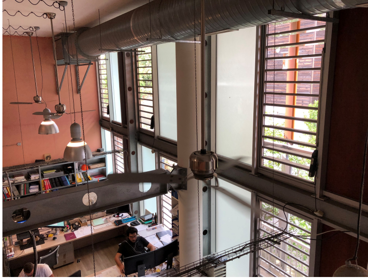
FIGURE 2.3 – Vue intérieure des bureaux de l’Ilet du Centre. Open-space équipé de jalousies toute hauteur et de brasseurs d’air
