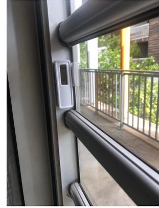
FIGURE 2.9 – Contact magnétique en position 1 "fermée"
