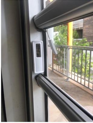
FIGURE 2.8 – Contact magnétique en position 0 "ouverte"
