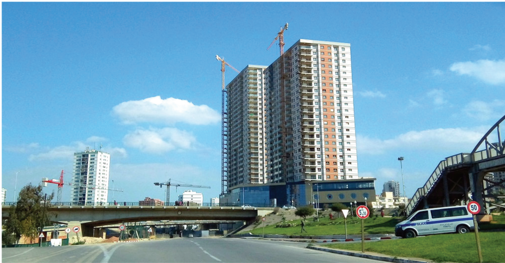
Figure 37 - Construction dépassant largement les COS et occupant une servitude routière
