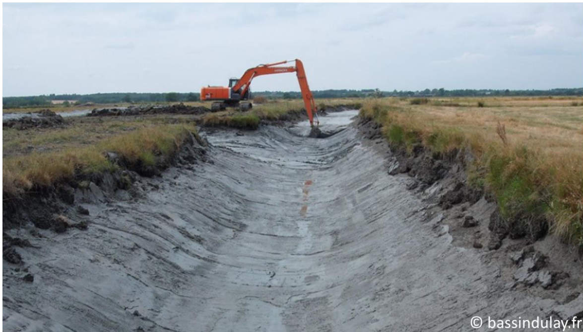
Figure 1. 10. Curage d'un canal (primaire ou secondaire). Cette pratique est réalisée afin de lutter contre l'envasement et le comblement des fossés.
