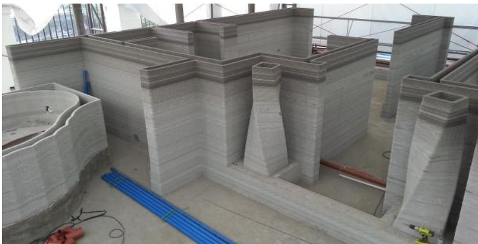
Fig. 1.6 : L'extension imprimée en 3D du Lewis Grand Hôtel [14]
