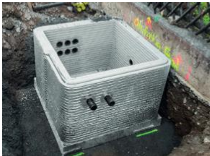
Fig. 1.8 : Puits imprimé en 3D [16]
