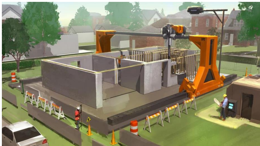
Fig. 1 : Procédé d'impression 3D « Contour Crafting » [3]
