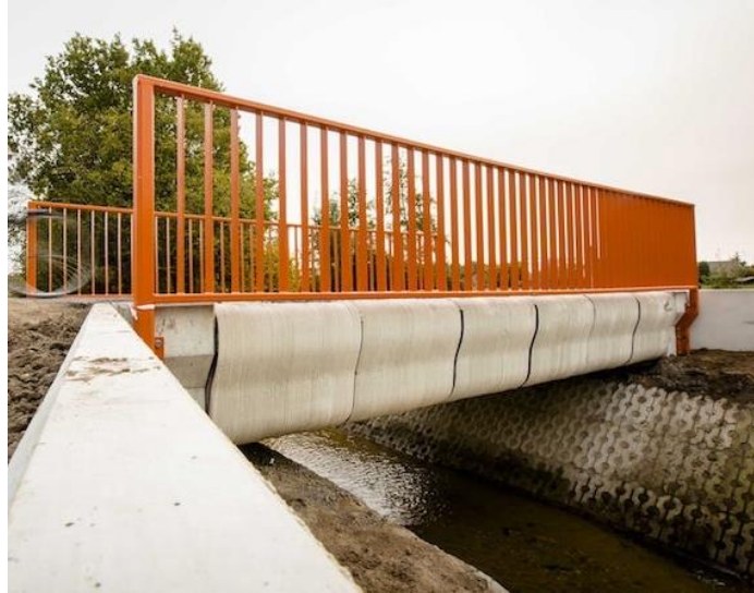
Fig. 1.7 : Pont imprimé en 3D [15]
