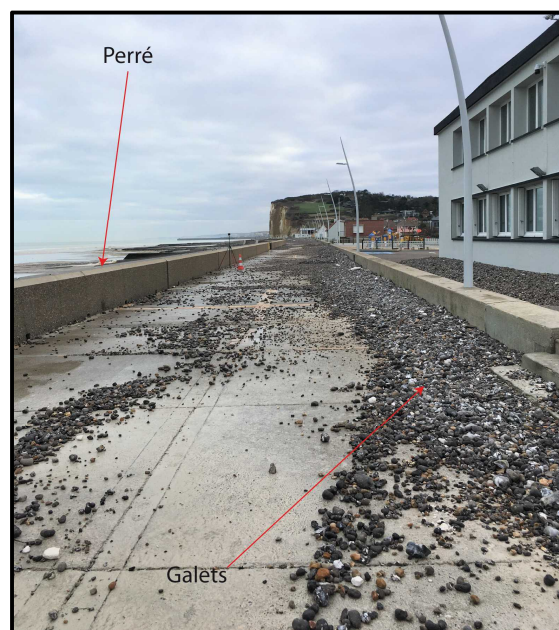
Figure 1.30 - Accumulation de galets projetés au-delà du perré à Pourville-sur-Mer (février 2020). (Cliché : B. Peuziat, 2020).
