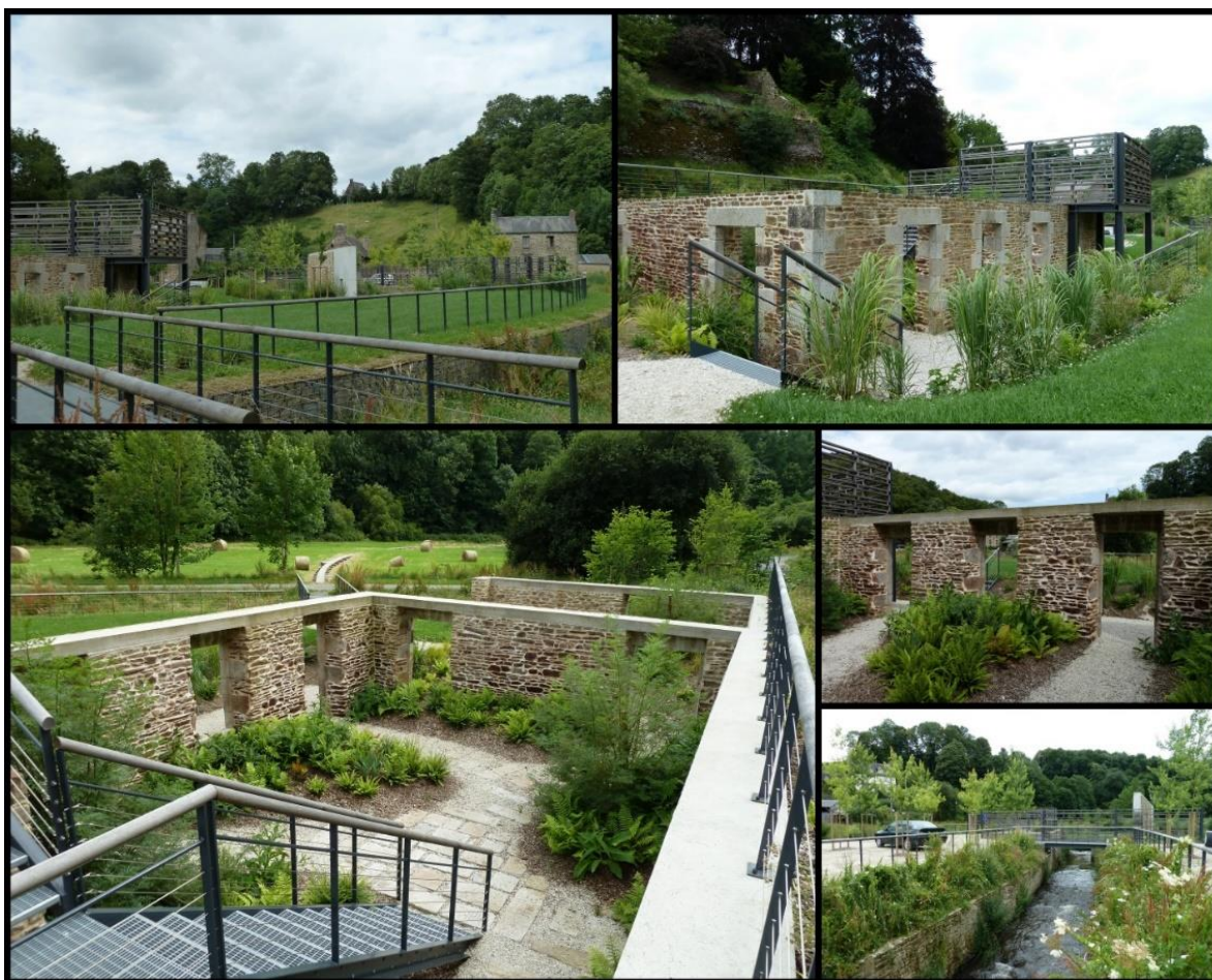
Figure 63 – Conservation d’une partie des friches industrielles au Bas des Rivières à Saint-James sur le Beuvron (Clichés : M.-A. Germaine, Juillet 2012)
