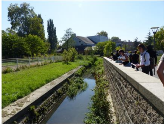
a) Le Petit Rosne à Sarcelles (remise à ciel ouvert minérale réalisée en 2013)
