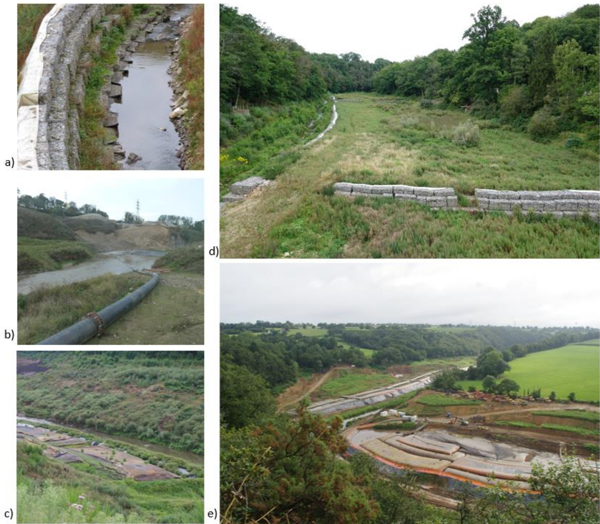
a) Lit de l'Yvrande, b) Tuyau d'aspiration des sédiments pour les stocker vers l'amont, c) Stockage temporaire des sédiments dans la retenue de Vezins, d) Casiers de stockage des sédiments contaminés dans le lit de l'Yvrande, e) Stockage des sédiments de la Roche-qui-Boit dans l'ancienne retenue de Vezins
