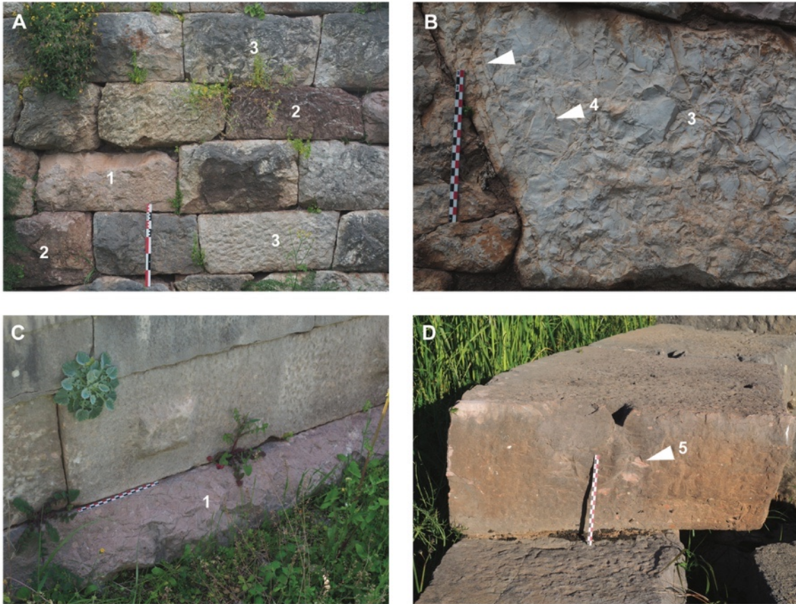
Figure 92. Les calcaires lités : mises en œuvre et altération.
