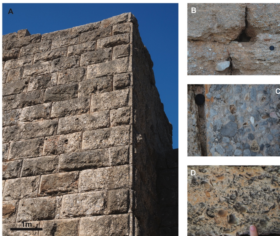
Figure 22. La forteresse d'Aigosthènes : les roches mises en œuvre.
