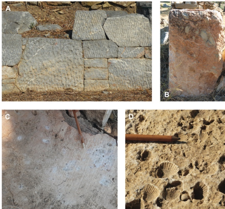
Figure 48. Le site de Kalaurie : les pierres mises en œuvre.
