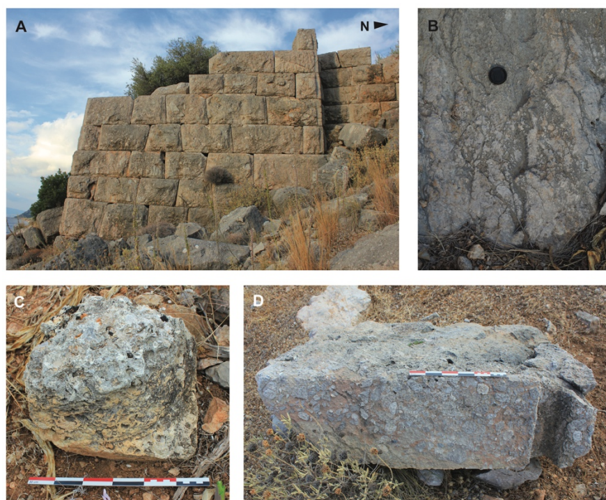
Figure 26. Le port de Kreusis : les pierres mises en œuvre.
