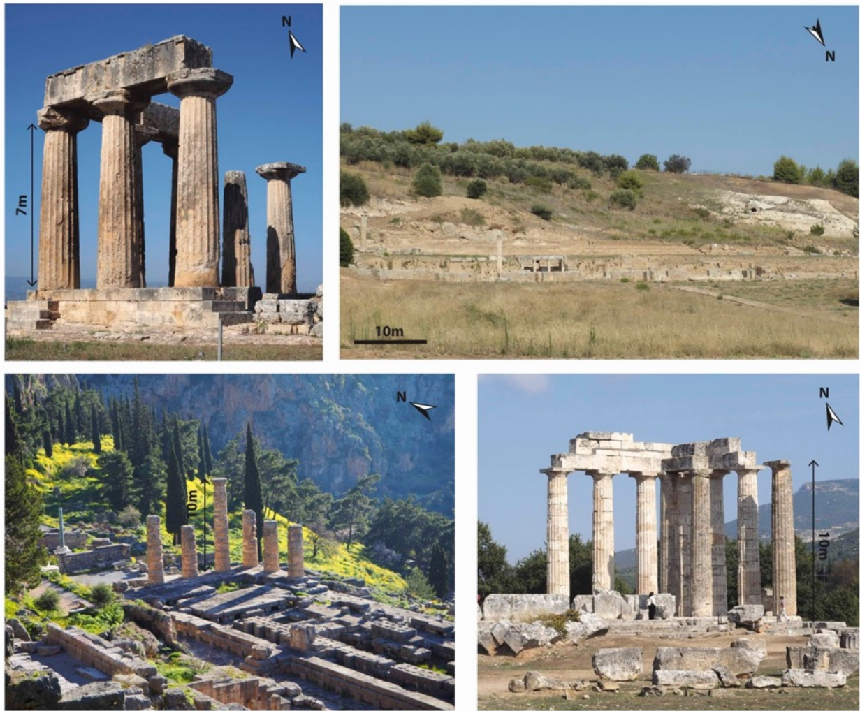
Figure 4. Les vestiges étudiés : quelques exemples dans le Golfe de Corinthe. De gauche à droite et de bas en haut : le Temple d'Apollon à Corinthe, construit en dune oolithique ; la Palestre (gymnase) à Sicyone, entièrement en conglomérat ; le Temple d'Apollon à Delphes, colonne en dune oolithique et plateforme en calcaire dur ; le Temple de Zeus à Némée, construit entièrement en travertin.
