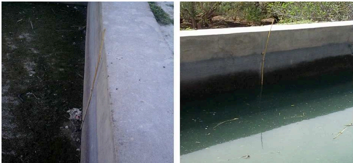
Figure 40 - Le recours à une canne « graduée » pour diviser la contenance du récipient (Source : auteur)
