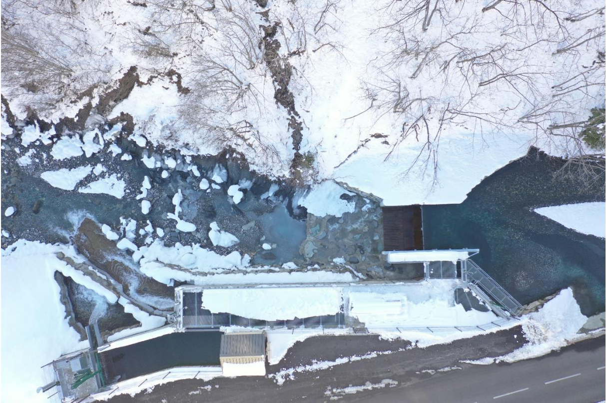
Figure 6 : Prise d'eau de la centrale hydroélectrique de Saint-Jean-d'Arves (par drone), Savoie, 07/12/2019 (F. Chevreux)
