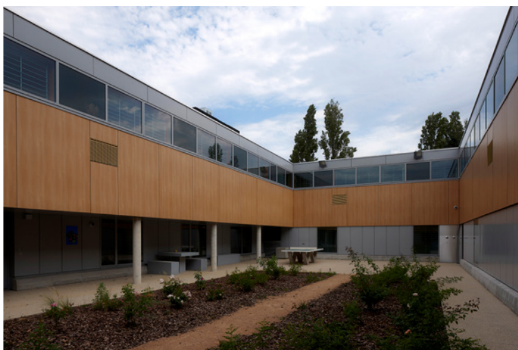
Illustration 60 : Patios avec les roseaies à l'intérieur de l'UHSA
