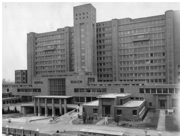
Illustration 7 : L'hôpital Beaujon à Clichy, dessiné par les architectes Walter et Cassan
