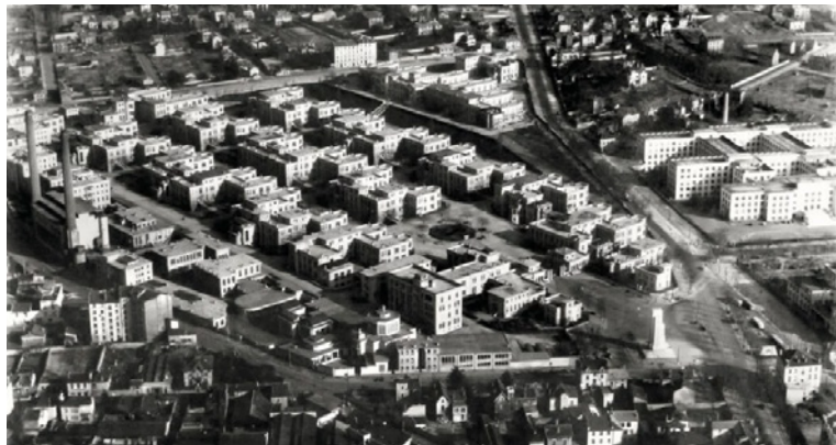
Illustration 5 : Vue aérienne de l'hôpital de Grange-Blanche (Lyon).
