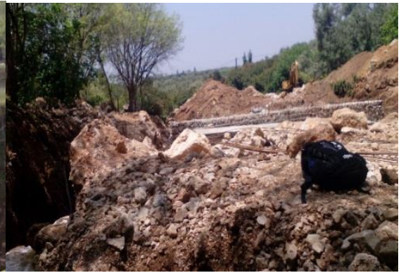
Photo 6 : travaux de protection de la source (Gaffer)
