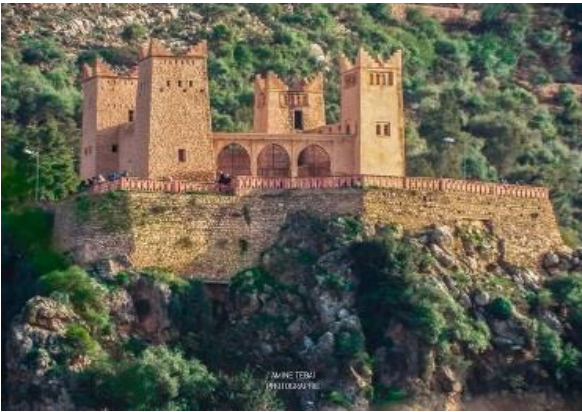
Photo 8 : Ksar d'Ain Asserdoune
