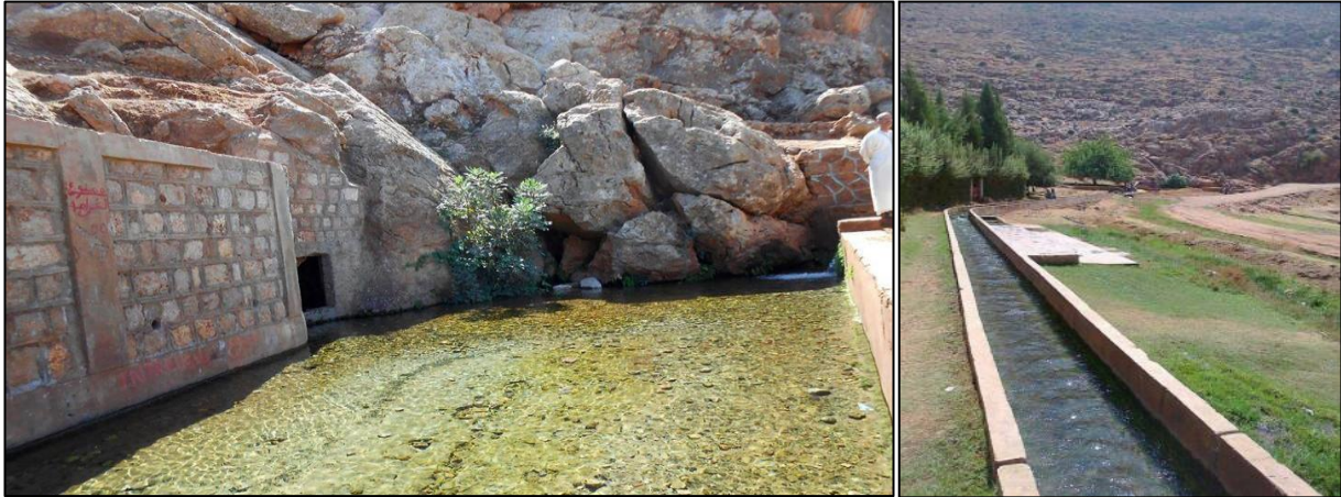
Photo 2 : les murs protégeant la source Photo 2 : Saguia acheminant l'eau aux champs agricoles
