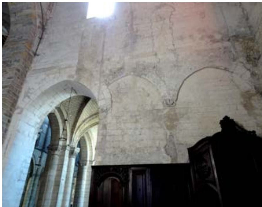
a – Bras nord, mur ouest (intérieur)
