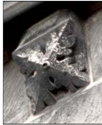
c – modillon CNN-44 nef. corniche du gouttereau nord Cliché Br. Danel-Marcé
