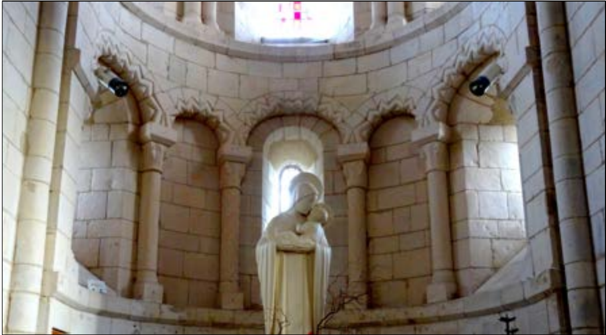
a – Cheux (Calvados). Église Saint-Vigor (1 re moitié du XII e s.) Chœur. Arcature continue alternativement aveugle et ouverte par une étroite baie en plein-cintre. L'archivolte de l'arc de décharge à bâtons-rompus rappelle les baies du chœur de Lillers. Cliché : Br. Danel-Marcé
