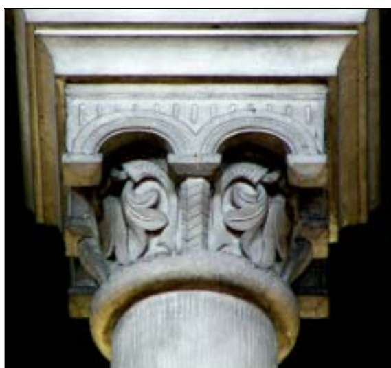
c - Lillers, chapiteau 73 ouverture sur comble de la nef 3 e travée septentrionale Cliché Br. Danel-Marcé
