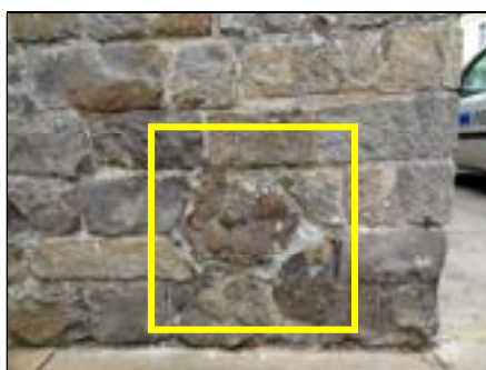
c – Retour nord de la façade ouest → Soubassement en grès (XII e s.) Insertion de deux blocs de poudingues Cliché Br. Danel-Marcé
