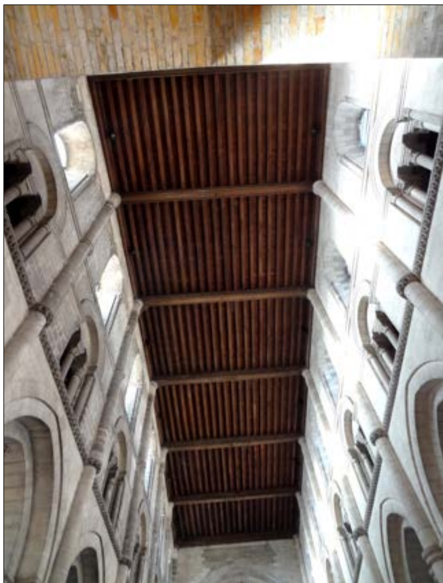
Fig. 189 – Plafond à solives apparentes des hauts-voisieux (1)
