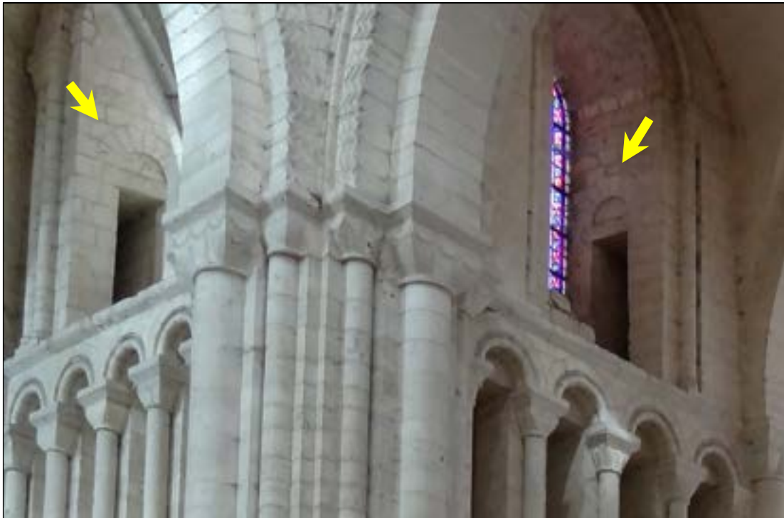
a – Saint-Martin-de-Boscherville (Seine-Maritime). Abbaye Saint-Georges Angle du bras nord et du chœur. Baies de la coursière du clair-étage Cliché : Br. Danel-Marcé
