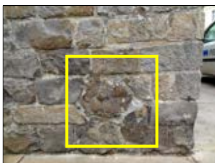
c – Retour nord de la façade ouest → Soubassement en grès (XII e s.) Insertion de deux blocs de poudingues Cliché Br. Danel-Marcé
