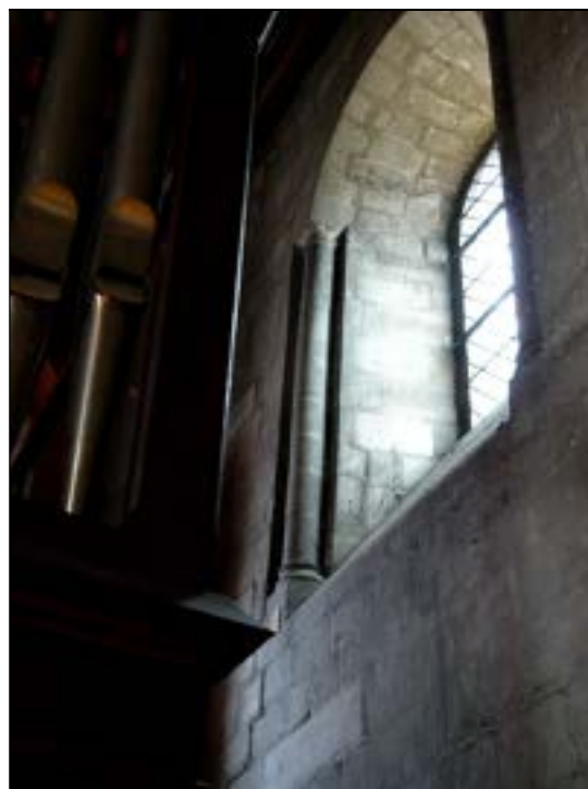
b – Tribune occidentale Fenêtre du mur nord Cliché : Br. Danel-Marcé
