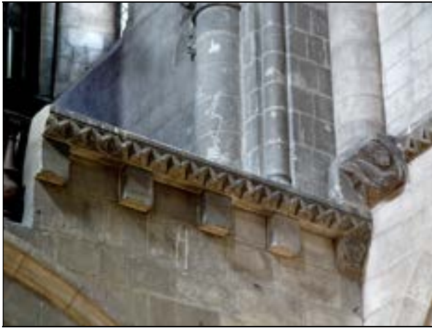
a – Lillers bandeau du garde-corps de la tribune occidentale Cliché Br. Danel-Marcé
