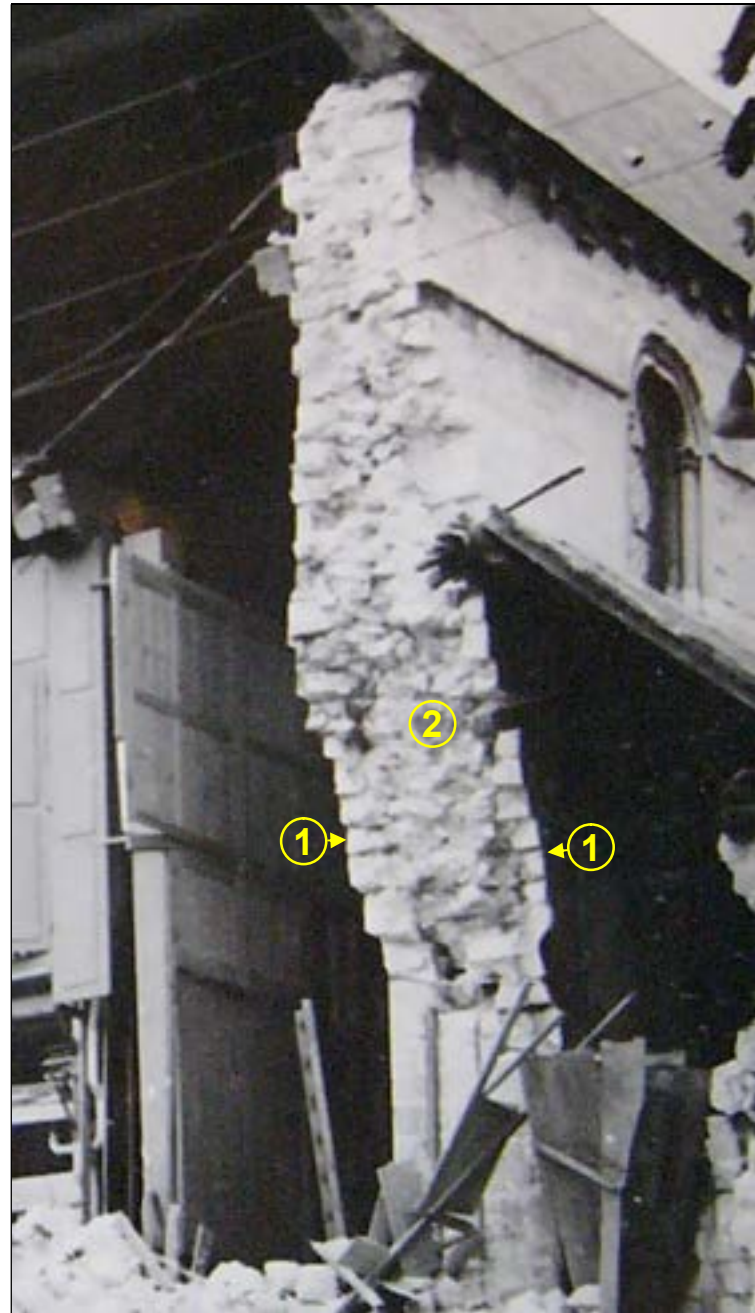
b – (détail) Mur gouttereau méridional de la tribune
