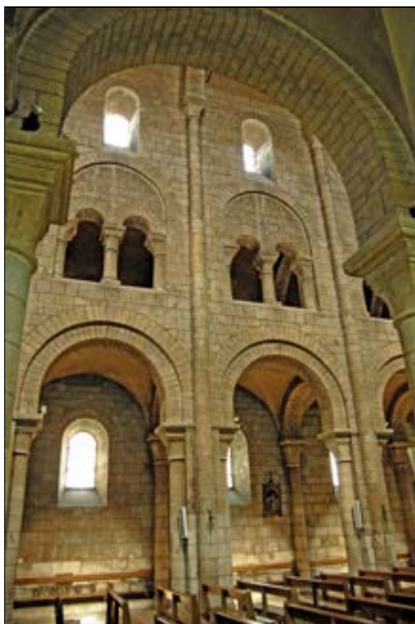
b – Nevers (Nièvre) Église (paroissial) Saint-Étienne Nef, élévation à trois niveaux du mur nord © Jochen Jahnke @ wikimedia.org
