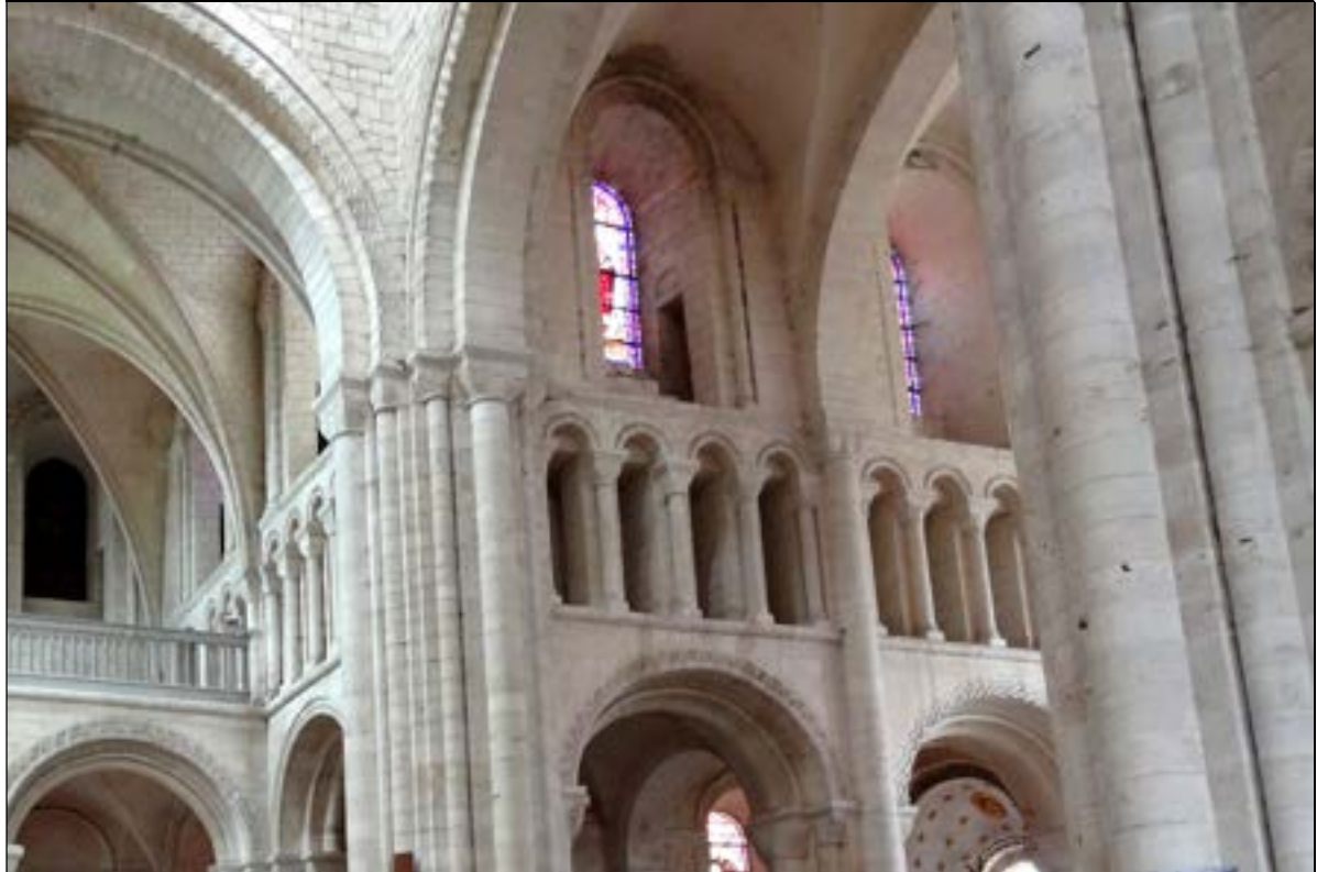
b – Saint-Martin-de-Boscherville (Seine-Maritime). Abbatié Saint-Georges (fin XI e - début XII e s.) Angle du bras nord du transept et du chœur. Triforium : arcature à quatre baies en plein-cintre percées d'ouvertures rectangulaires. Cliché : Br. Danel-Marcé
