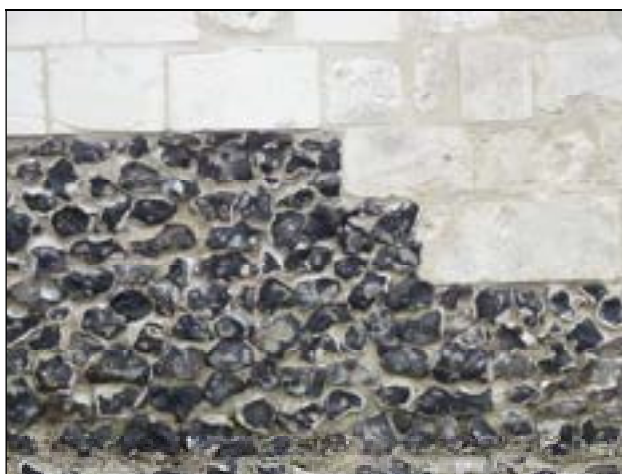
c – Esquerdes (P.-de-C.) Église Saint-Martin Maçonnerie en silex Soubassement du mur méridional de la nef Cliché Br. Danel-Marcé
