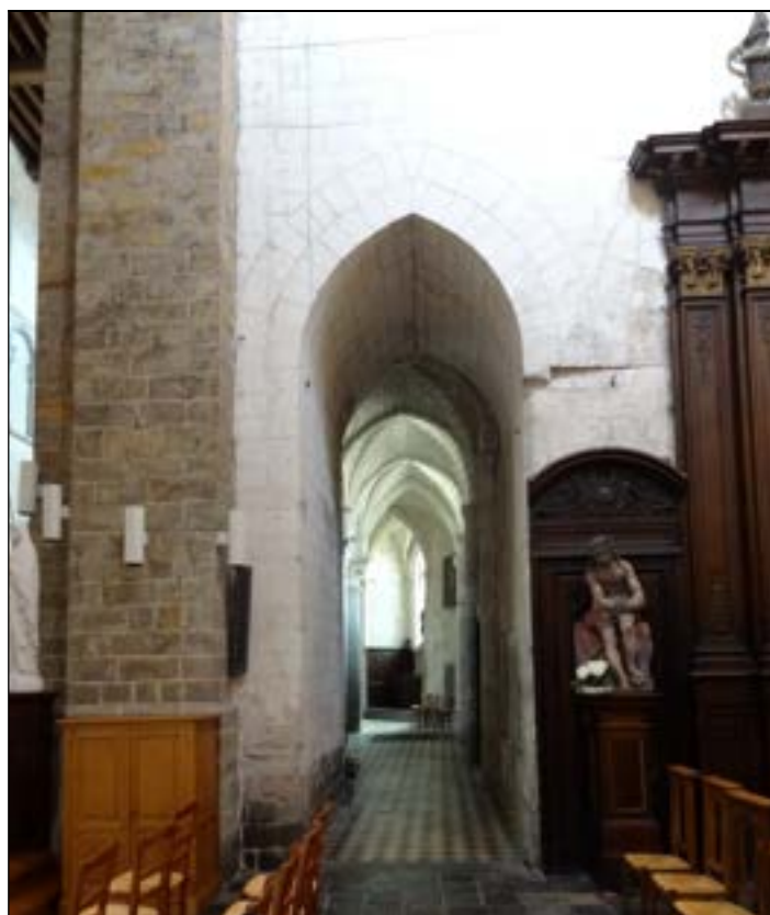
b – Bras sud, mur est (à gauche) grande-arcade proximale ouvrant sur le déambulatoire reprise en sous-œuvre c. fin XII e - XIII e s. Cliché : Br. Danel-Marcé
