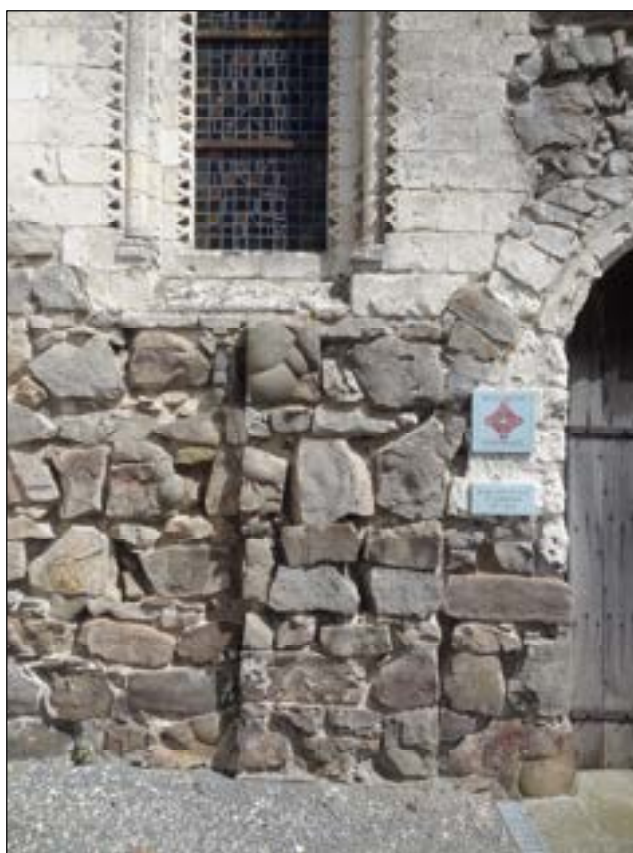
b – Guarbecque (P.-de-C.) Église Saint-Nicolas (XII e s.) Grès « tout venant » et poudingues appareillés en soubassement surhaussé. Façade occidentale. Cliché Br. Danel-Marcé
