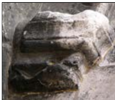
Chap. 153 Bras nord, mur oriental (angle sud)
