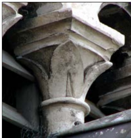
b – Nortbécourt (P.-de-C.) église Saint-Wandrille baie du clocher (2 e moitié du XII e s.) Cliché Br. Danel-Marcé
