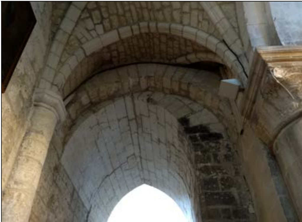
c – arcs de renforcement plaqués contre l'intrados de la voûte primitive de la travée XI Cliché Br. Danel-Marcé
