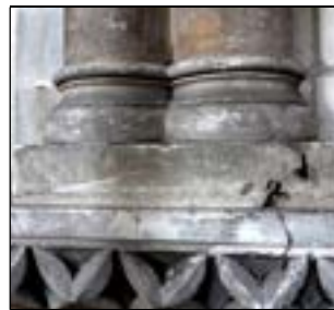
d – base de colonnettes engagées chœur, ouvertures sur comble Cliché et dessin Br. Danel-Marcé
