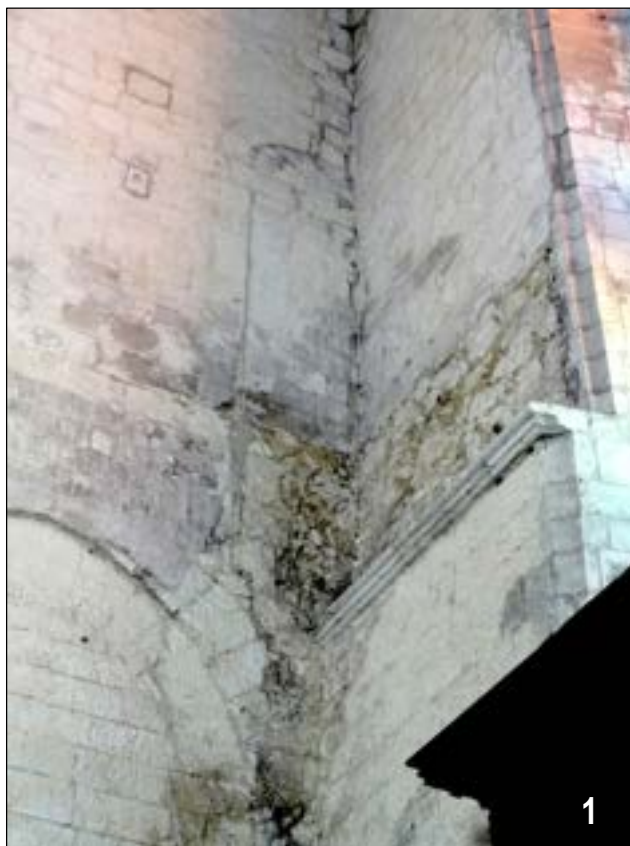
Fig. 145 – Vestiges de coursières des murs-pignons du transept (2) Emprise de la coursière dans l'angle nord-ouest du bras nord
