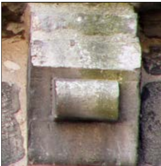
a – modillon CC-42 corniche du gouttereau nord du chœur Cliché Br. Danel-Marcé
