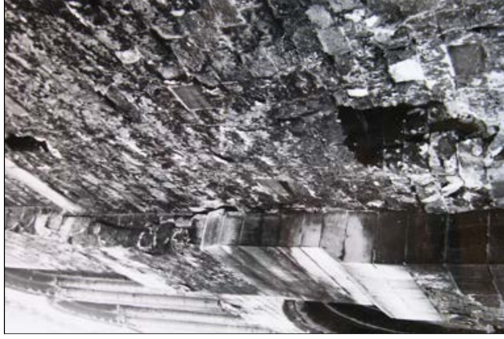
a – bouffement du contrefort sud (côté gauche) et lézardes (cl. n° 5) b – contrefort lézardé et bouclement du mur de la cage d'escalier (cl. n° 7) MAP. Photothèque. « Église de Lillers. Façade ouest. Devis n° 59372 », planche de dix photographies réunies et classées par l'ACMH Ch. Waldschmidt (1971). Clichés Ch. Abadie
