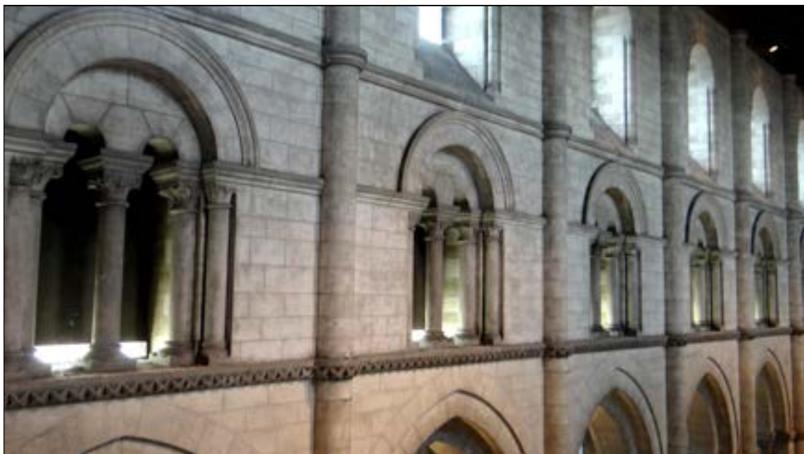
a – Vue vers l'est (depuis la tribune) des travées 1 à 5 du mur nord de la nef Cliché : Br. Danel-Marcé
