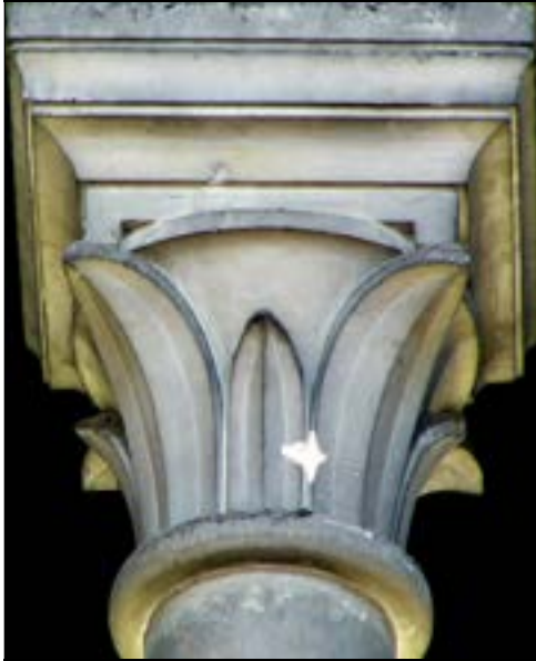
a – Lillers chapiteau d'ouverture sur comble chap. 84. Nef, mur sud, 4 e travée Cliché Br. Danel-Marcé
