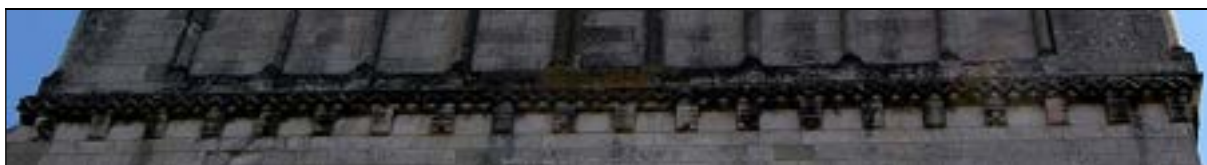
2018. État actuel, depuis la reconstruction de la façade (1974) Dans son projet de reconstruction, l'architecte Waldschmidt a opté pour la restitution du nombre initial de vingt modillons tel que le montre le cliché de Mieusement auquel il s'est référé. Bien que s'inspirant des modèles autochtones, cet ensemble date néanmoins des années 1972-1974. Cliché : Bruno Danel-Marcé
