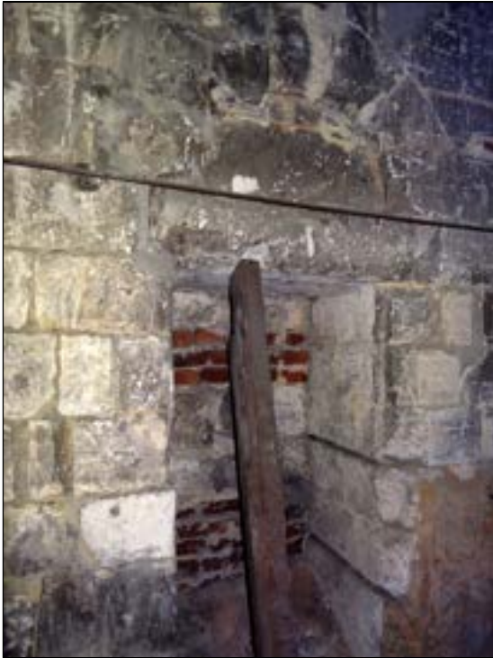
a – Baie n° 22 (bras sud, mur oriental) Revers de la baie vu depuis le comble de la sacristie. Le linteau monolithique est intact. Cliché Br. Danel-Marcé
