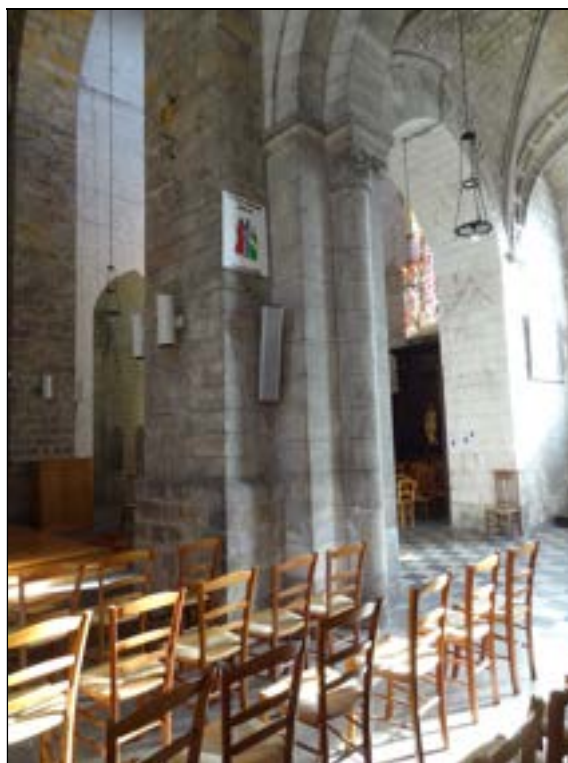
b – Pile B 8 (faces ouest et nord depuis la nef). Arrière plan : pile B 9 et entrée sud du déambulatoire. Cliché : Br. Danel-Marcé
