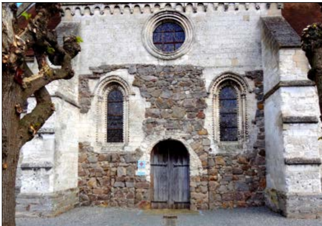
a – Guarbecque (Pas-de-Calais). Église Saint-Nicolas Baies jumelles percées durant la deuxième moitié du XII e siècle dans la façade du XI e s. Cliché : Br. Danel-Marcé
