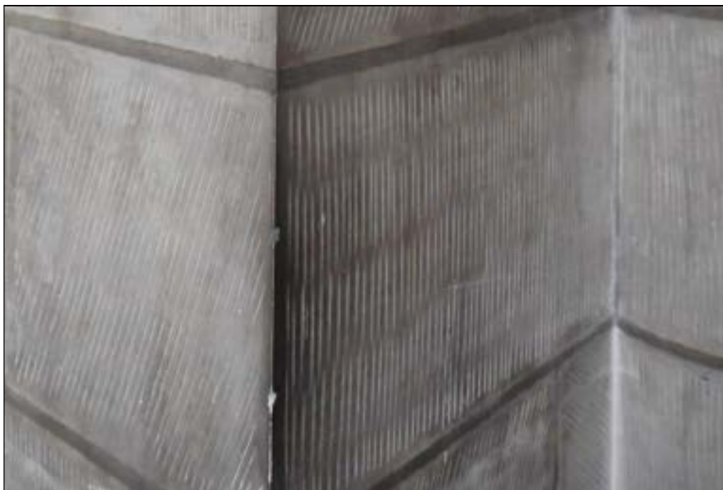
a – Traces d'outils sur parement de calcaire. Lillers. Nef, grandes-arcades Pilier sud B 6. Taille charruée de la surface, avec alternance des stries sur les blocs pour rompre la monotonie de l'aspect scié des blocs neufs (restauration en 1924). Cliché A. Timbert
