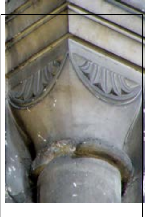
a – Lillers chapiteau d'ouverture sur comble chap. 60. Nef, mur sud, 2 e travée Cliché Br. Danel-Marcé
