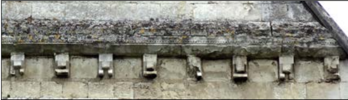
a – Airaines (Somme). Prieurale Notre-Dame Corniche du pignon de la façade (c. 1130) ; tablette rectiligne moulurée ; métopes nues Cliché Br. Danel-Marcé
