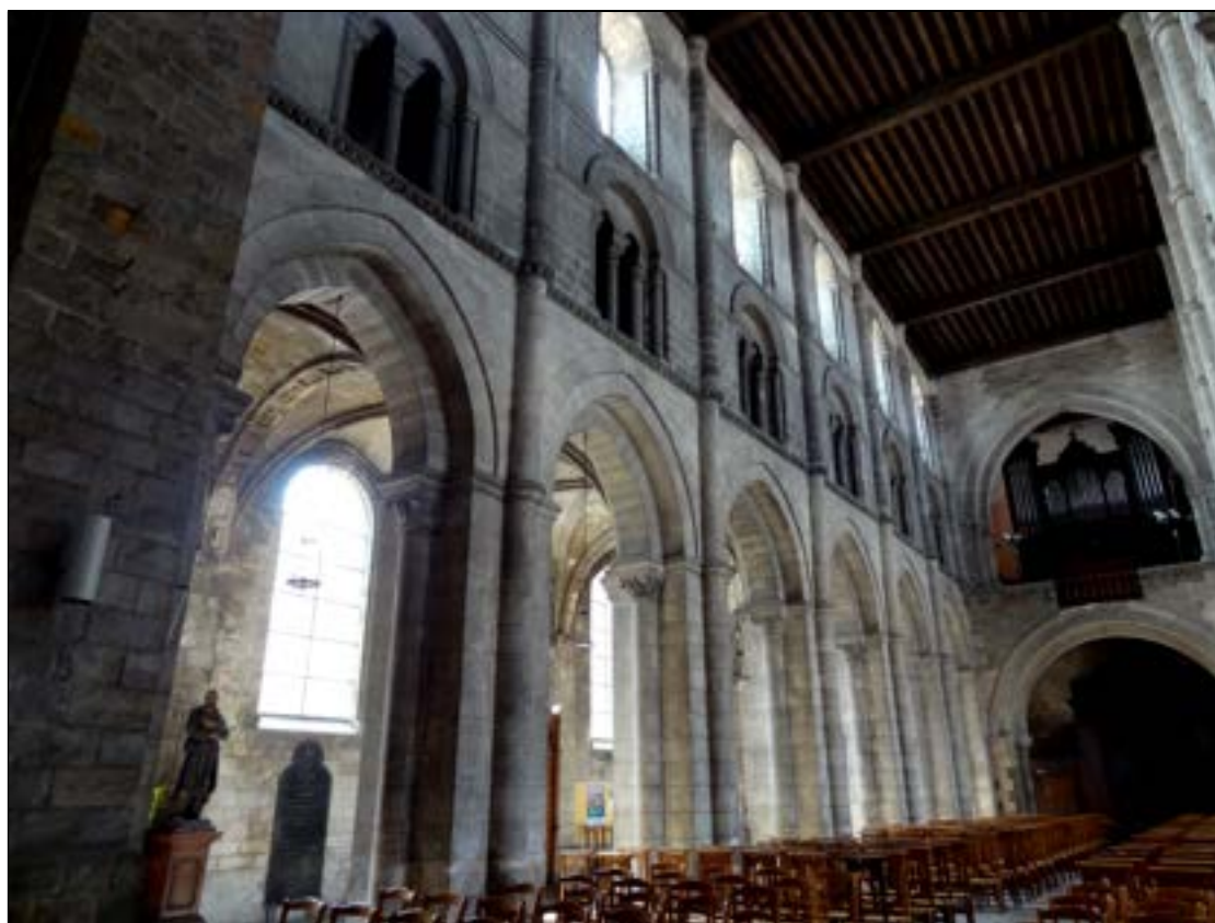
b – Mur sud en direction de l'ouest. Cliché : Br. Danel-Marcé
