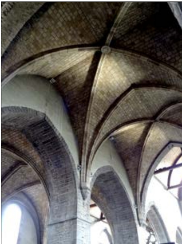
a – Beauvais (Oise). Collégiale Saint-Étienne arcs d'ogives à arête entre deux tores posés sur bandeau bas-côté sud de la nef. travée II. Cliché Br. Danel-Marcé
