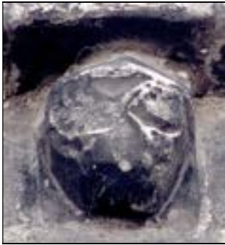
a – modillon CC-23 corniche du gouttereau du chœur (abside) Cliché Br. Danel-Marcé
