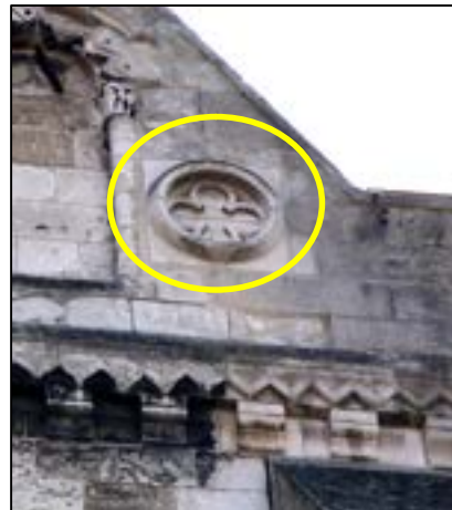
-57 b : Pignon du bras nord - rampant ouest rose aveugle quadrilobée
