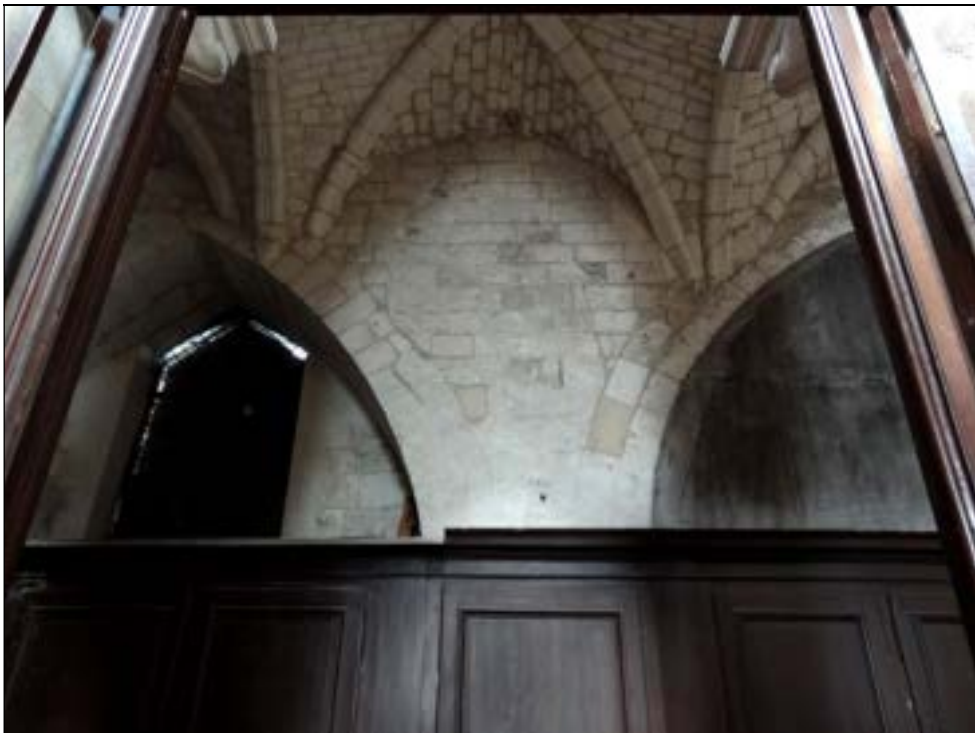
b – Vue intérieure (travées II à IV du bas-côté nord du chœur). Revers des deux arcades murées : on distingue la reprise « audacieuse » des travées de voûtes romanes dont les arcs, privés de leur support primitif, s'appuient sur les vousoirs des arcs gothiques Cliché Br. Danel-Marcé
