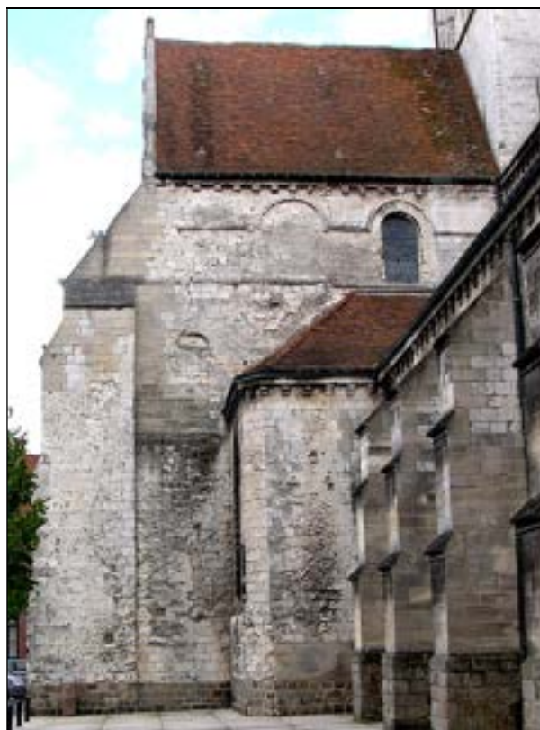
b – Bras nord, mur occidental vue d'ensemble extérieure avec la chapelle et le mur gouttereau du bas-côté nord de la nef. (À gauche) contrefort cornier du pignon nord. Gouttereau du transept, (en bas) : vestiges murés des grandes-arcades ; (au-dessus) : vestiges murés de la baie distale (n°13 - ouverture sur comble) Cliché Br. Danel-Marcé
