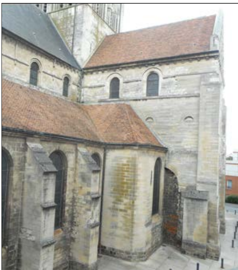
Fig. 98 – Lillers. Élévation des grandes-arcades du transept (1)
