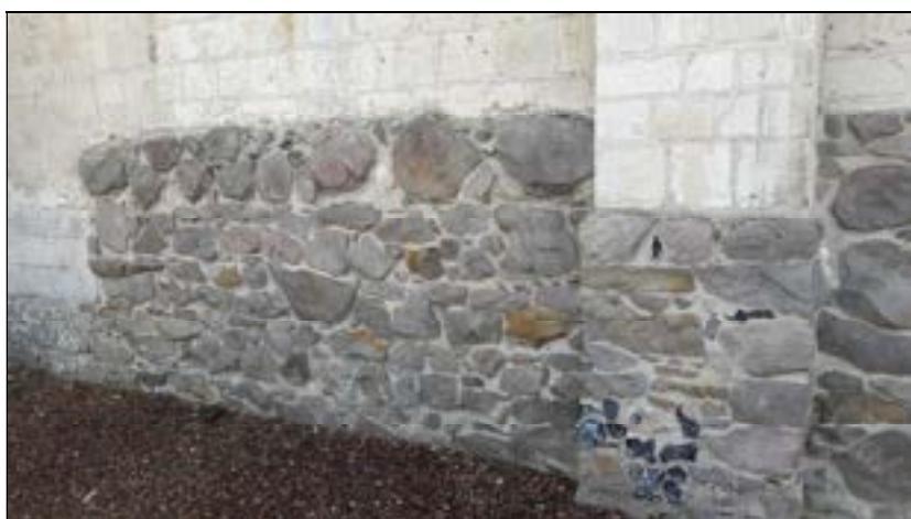
d – Mazinghem (P.-de-C.) Égl. N.-D.-de-l'Assomption Blocs de grès et silex Soubassement du mur méridional de la nef Cliché Br. Danel-Marcé
