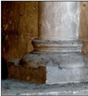
a – base à tore inférieur en bec-de-corbin tribune occidentale. support engagé Cliché et dessin Br. Danel-Marcé
