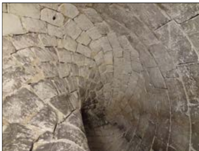
b – Insertion de la voûte dans le noyau les voussoirs s'insèrent dans une mortaise verticale ménagée latéralement dans le corps du noyau Cliché Br. Danel-Marcé
