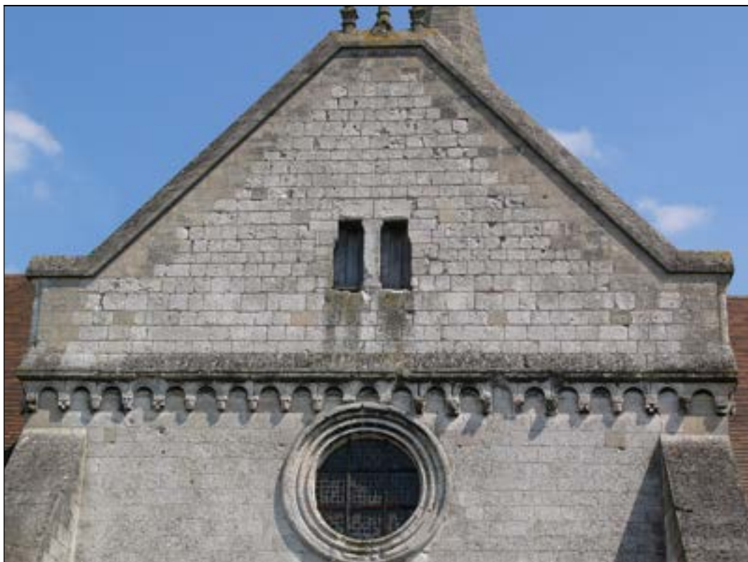
a – Pignon de la façade occidentale Cliché : Br. Danel-Marcé
