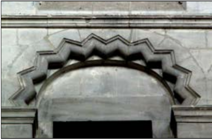
a – Lillers. Chœur Ouvertures sur comble Archivolte de l'arc de décharge à bâtons-rompus Cliché Br. Danel-Marcé
