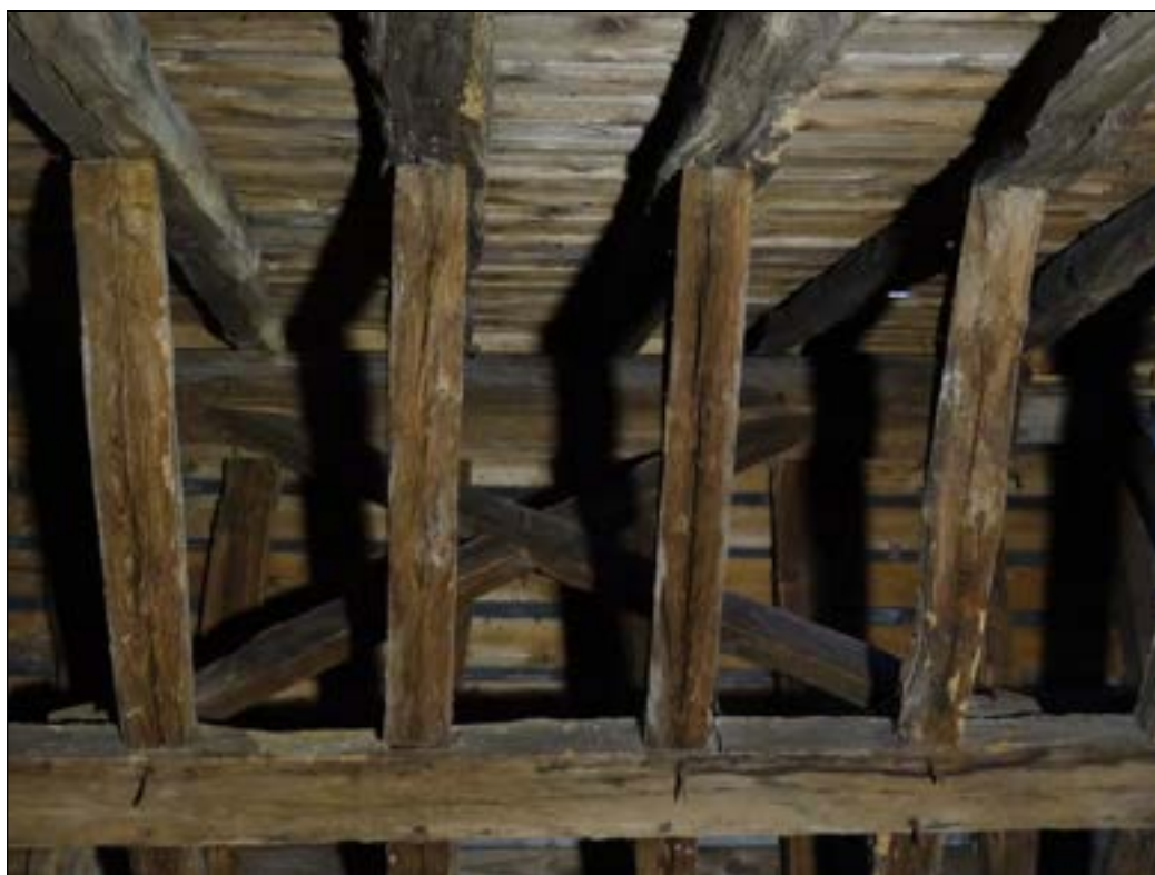
b – Nef. Travée de tribune. Croix de Saint-André. Cliché Br. Danel-Marcé (Au premier plan) Faux-entraits des chevrons traversant la pièce du sous-faîtage
