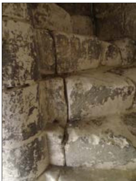
a – Noyau et marches faisant corps avec le noyau, l'amorce de la marche est prolongée par un second bloc de pierre. Cliché Br. Danel-Marcé
