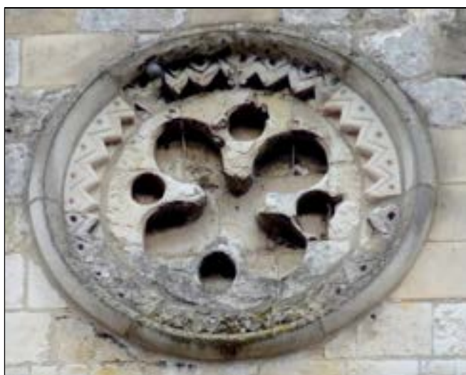
b – Lillers. Rose aveugle quadrilobée du pignon du bras nord Cliché Br. Danel-Marcé
