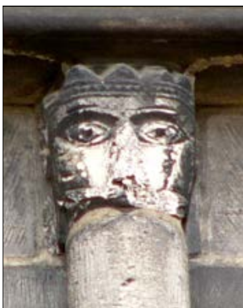
c – modillon CNN-Ch-6 nef. corniche du gouttereau nord Cliché Br. Danel-Marcé
