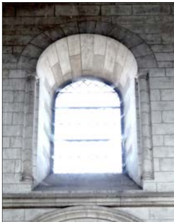
a – Nef 1 re travée, mur nord Cliché : Br. Danel-Marcé
