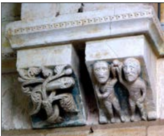
b – Guarbecque (P.-de-C.) église Saint-Nicolas culots historiés de la croisée « le péché originel » Cliché Br. Danel-Marcé
