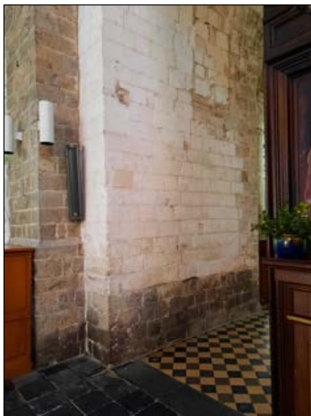
b – Croisée. Pile A 8 (angle nord-ouest, arc triomphal) Soubassement saillant en grès biseauté et piédroit du grand-arc occidental de la croisée. Cliché Br. Danel-Marcé
