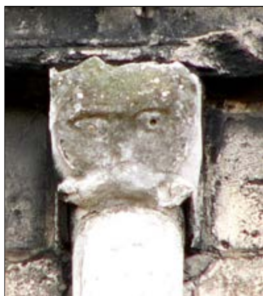
d – modillon CNN-Ch-8 nef. corniche du gouttereau nord Cliché Br. Danel-Marcé
