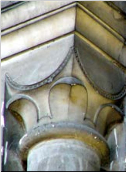
a – Lillers chapiteau d'ouverture sur comble chap. 88 . Nef, mur sud, 4 e travée Cliché Br. Danel-Marcé
