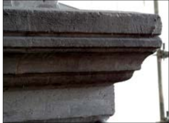
b – Lillers. Grandes-arcades du chœur tailloir du chap. 172 (colonne B 12) Cliché Br. Danel-Marcé
