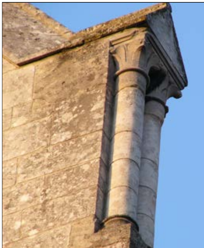
Fig. 90 – Lillers. Détail de profil des rampants des murs-pignons
