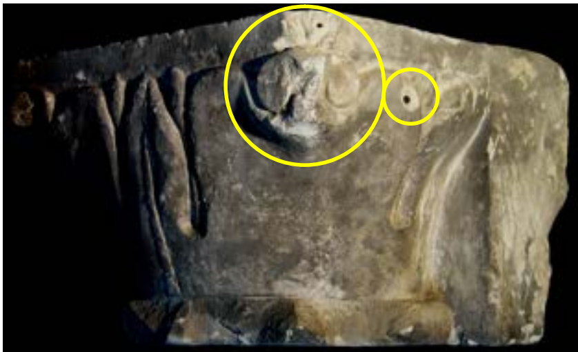
c – SOL-2008-23 chapiteau du dépôt lapidaire (grand médaillon) Dégradation du plâtre reconstituant les volutes d'angle. Tête de clou apparente sur l'abaque. (petit médaillon) La rouille du clou en fer a fait sauter le plâtre, laissant apparaître sa tête plate au fond de l'évidement conique. Cliché Br. Danel-Marcé
