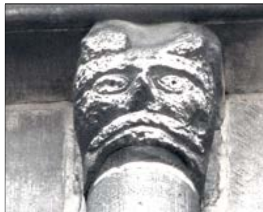
f – modillon CNN-Ch-3 nef. corniche du gouttereau nord Cliché Br. Danel-Marcé
