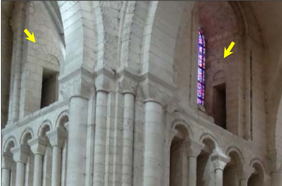
a – Saint-Martin-de-Boscherville (Seine-Maritime). Abbatiale Saint-Georges Angle du bras nord et du chœur. Baies de la coursière du clair-étage Cliché : Br. Danel-Marcé
