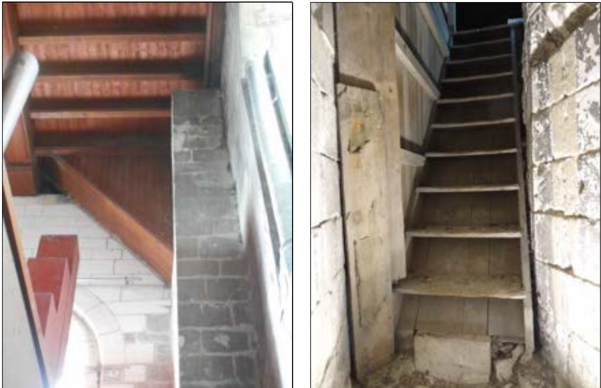
a- À gauche : empiètement dans l'angle nord-ouest de la tribune du massif de maçonnerie de la cage d'escalier en vis (en haut, à gauche : cage en charpente contenant la volée droite qui complète le dispositif). À droite : vue intérieure de cette volée droite. Clichés : (gauche) A. Timbert ; (droite) Br. Danel-Marcé
