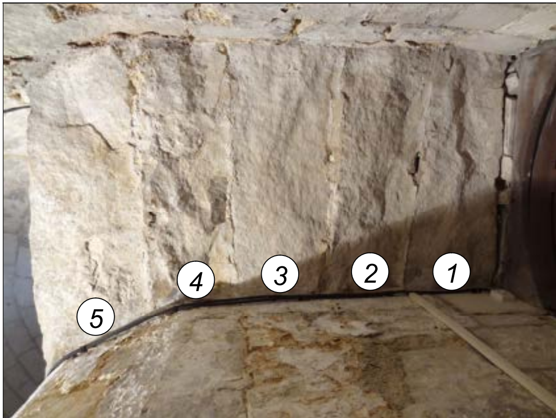
c – Les cinq dalles monolithiques formant le plafond du couloir d'accès (à gauche) accès bas de la cage ; (à droite) porte d'entrée donnant sur le bas-côté sud de la nef. Cliché Br. Danel-Marcé
