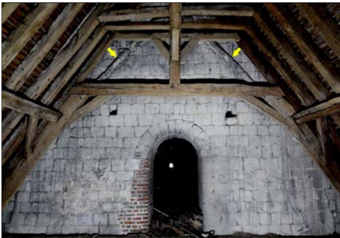
a – Bras nord. Vestiges du solin de la charpente primitive La pente était originellement moins accentuée ( 45^\circ , contre 56^\circ ). Cliché Br. Danel-Marcé
