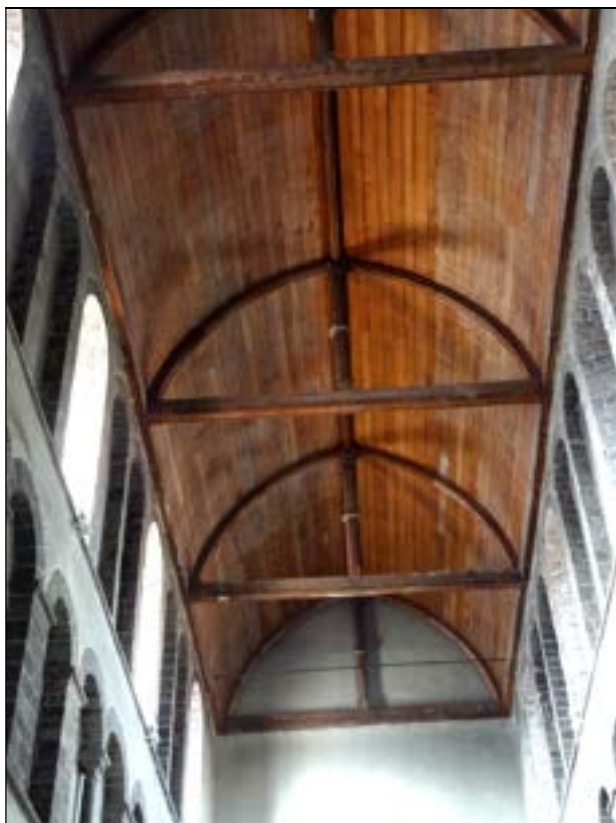
a – Tournai (province du Hainaut, Belgique) Église Saint-Brice. Nef Berceau lambrissé à fermes apparentes (vers l'ouest) (première moitié du XII e s.). Cliché Br. Danel-Marcé
