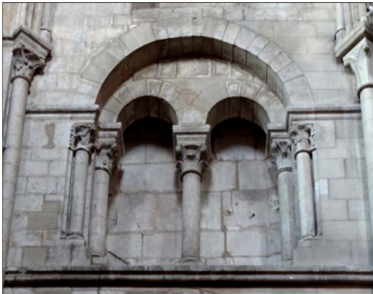
a – Beauvais (Oise). Collégiale Saint-Étienne. Mur nord de la nef Baie autrefois ouverte sur la tribune, à cinq colonnettes (même configuration qu'à Lillers) Cliché : Br. Danel-Marcé
