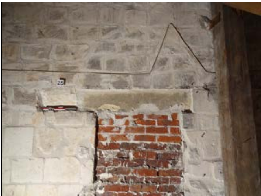
c – Baie n° 25 (chœur, mur nord) Revers de la baie depuis le comble du déambulatoire. Au-dessus du linteau monolithique, le tympan visible sous l'arc de décharge en plein-cintre semble avoir été obturé ultérieurement : le blocage n'est pas aligné sur les assises des trumeaux primitifs. Cliché Br. Danel-Marcé
