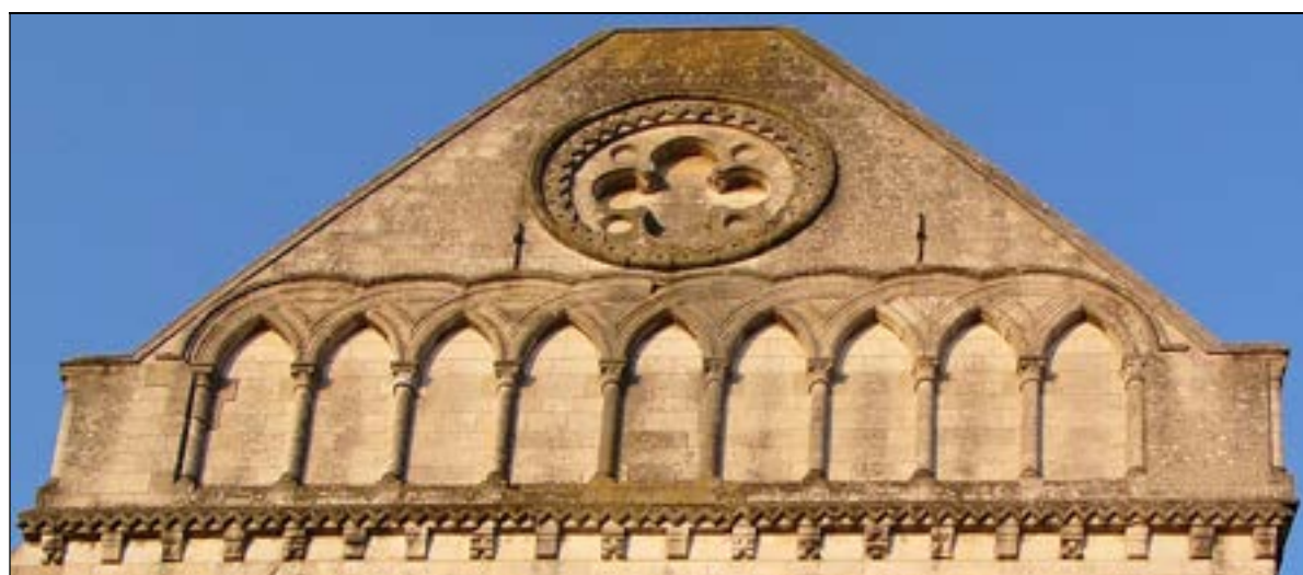
c – Pignon de la façade occidentale Cliché : Br. Danel-Marcé
