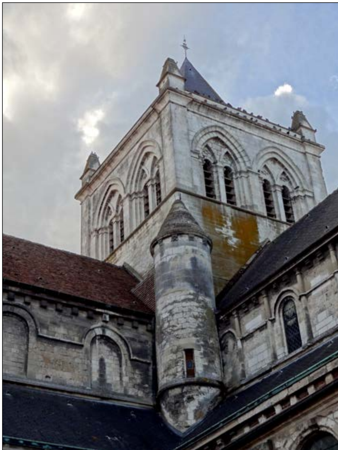
Angle sud-est du bras méridional et du chœur tourelle d'escalier en vis donnant accès au clocher, via le comble du transept Cliché Br. Danel-Marcé
