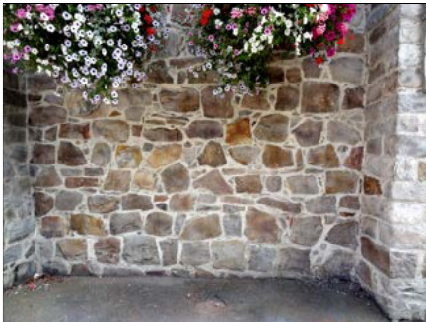
a – Chocques (P.-de-C.) Église Notre-Dame (fin XI e -début XII e s.) Grès « tout venant » appareillé en soubassement surhaussé. Façade occidentale Cliché Br. Danel-Marcé
