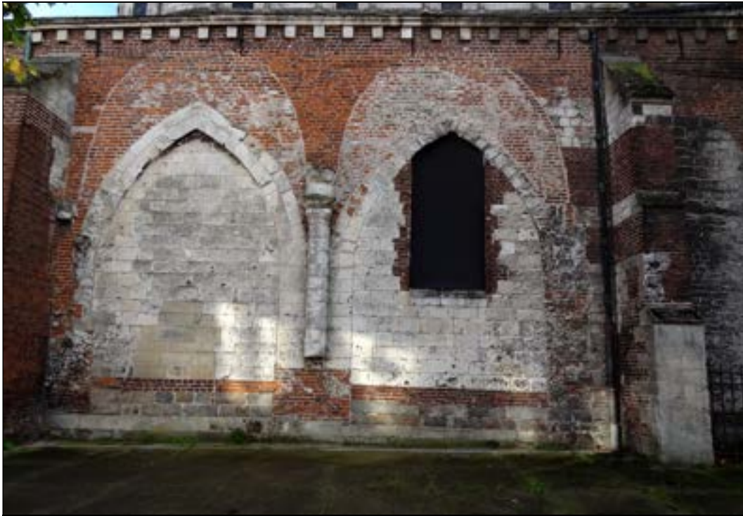
a – Vue extérieure (mur gouttereau nord du déambulatoire). Les deux arcades murées en tiers-point et la colonne engagée coiffée du chapiteau 181 qui recevait le doubleau de la voûte Cliché Br. Danel-Marcé
