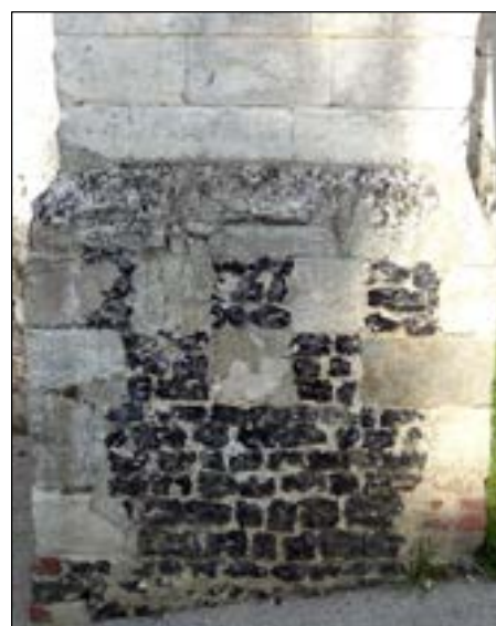
b – Acquin (P.-de-C.) Église Sainte-Pétronille. Soubassement en silex et craie, contrefort de la tour-porche Cliché Br. Danel-Marcé
