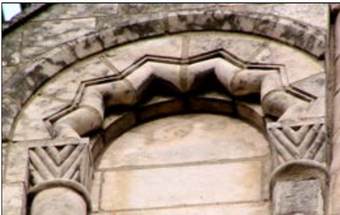
b – Lillers. Transept Pignon du bras sud archivolte de l'arcature aveugle à bâtons-rompus Cliché Br. Danel-Marcé
