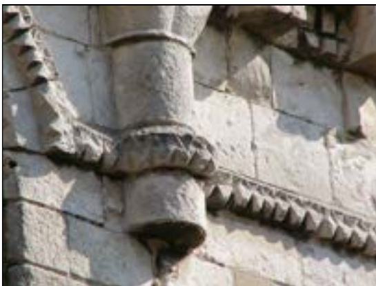
c – Ham-en-Artois (P.-de-C.) abbaye Saint-Sauveur mur gouttereau sud de la nef, clair-étage cordon en « pointes-de-diamant » Cliché Br. Danel-Marcé
