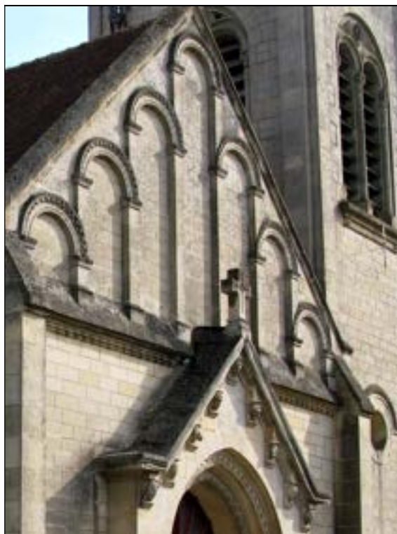
a – Nouvion-Vingré (Aisne). Église Sainte-Marie (XII e s.) Façade occidentale : la hauteur des baies s'adapte à la pente des rampants © Markus 3 @ wikimedia.org
