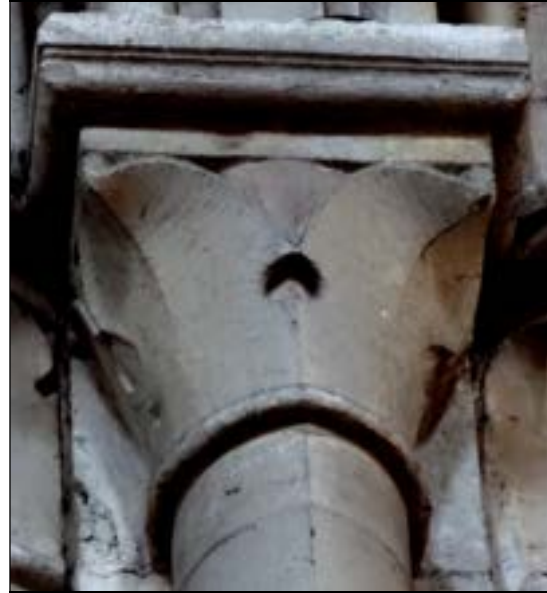
b – Beauvais (Oise) collégiale Saint-Étienne gouttereau nord de la nef (début du XII e s.) Cliché Br. Danel-Marcé
