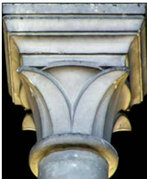
a – Lillers chapiteau d'ouverture sur comble chap. 74. Nef, mur sud, 3 e travée Cliché Br. Danel-Marcé
