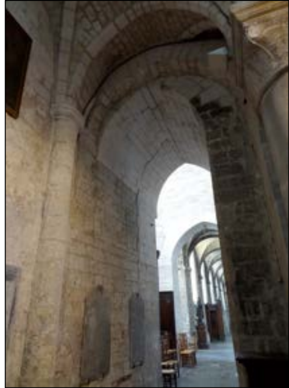
b – travée XI, côté sud (à gauche) arcade murée jadis ouverte sur le bas-côté oriental du bras sud (abattu) Cliché Br. Danel-Marcé
