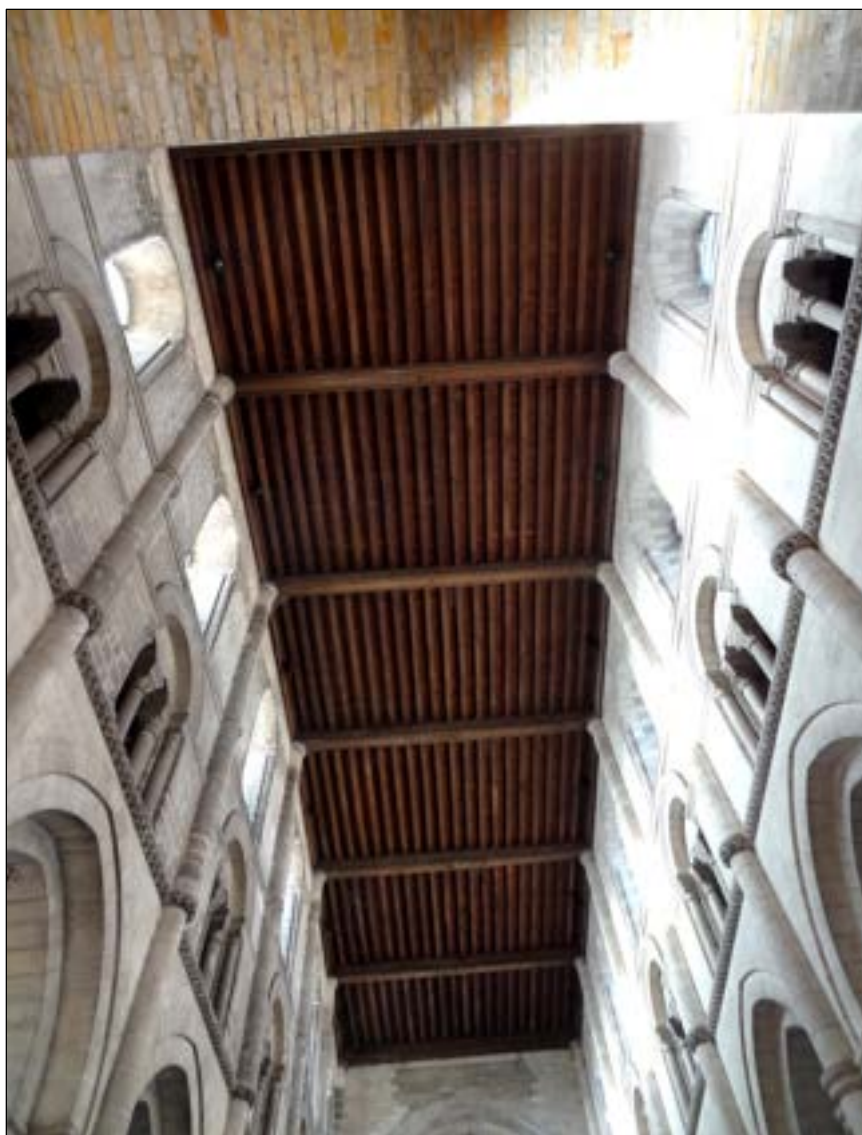
Fig. 189 – Plafond à solives apparentes des hauts-voisieux (1)
