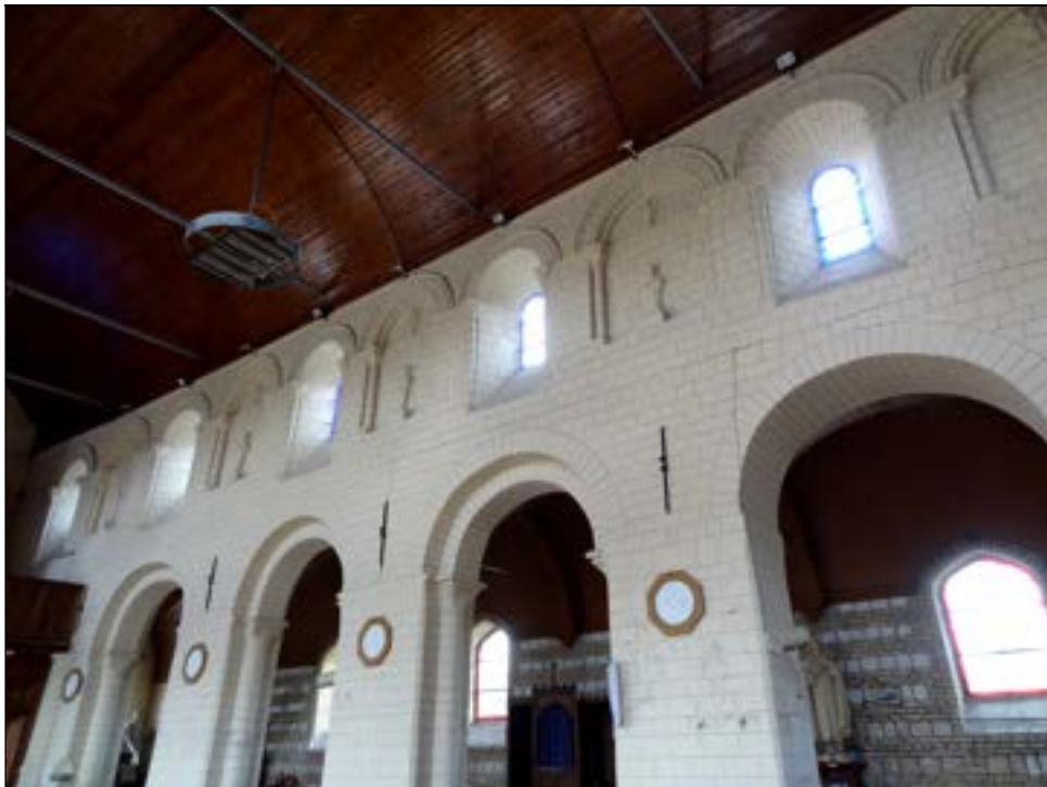
b – Cappelle-Brouck (Nord). Église Saint-Jacques-le-Majeur (c. 1169) Mur nord de la nef. Clair-étage avec arcature alternant baies ouvertes et aveugles Cliché : Br. Danel-Marcé
