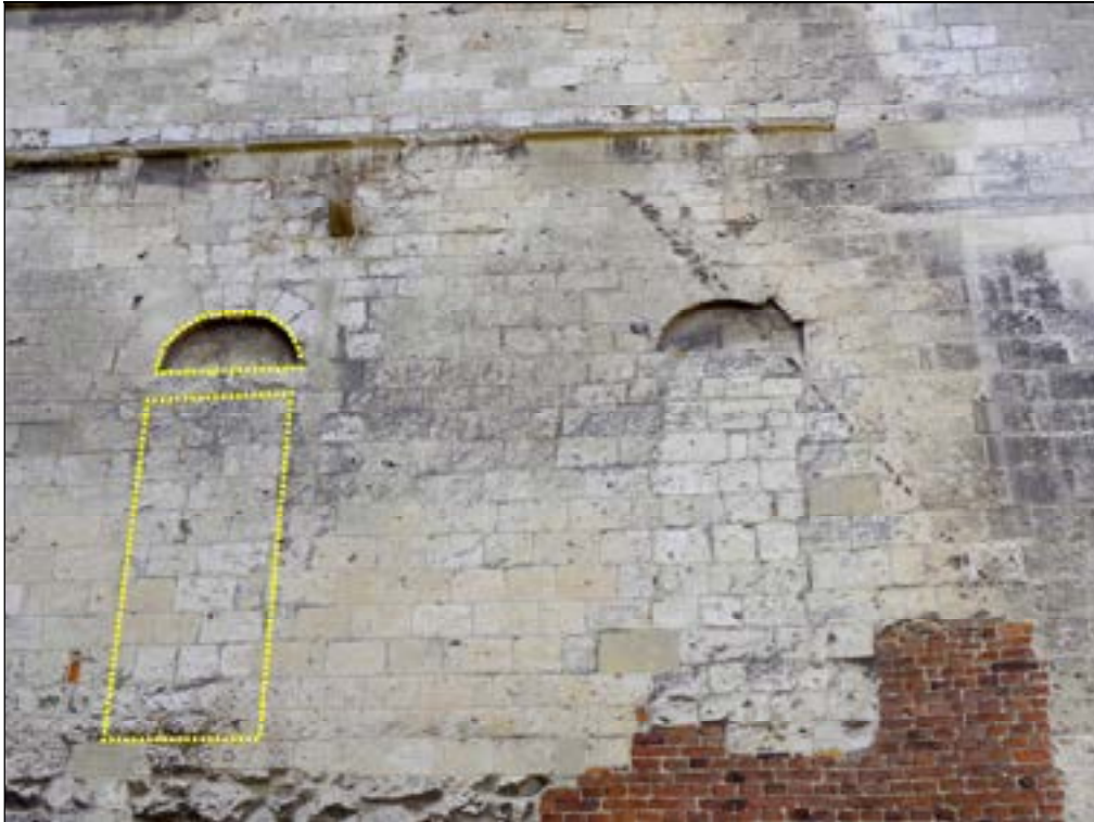
a – Mur oriental du bras nord (extérieur). Vestiges des ouvertures sur comble (À gauche) baie médiane 21, en pointillé : contour de l'ouverture rectangulaire (murée) et du tympan (aveugle) que sépare un linteau monolithique ; (à droite) baie distale 19.
