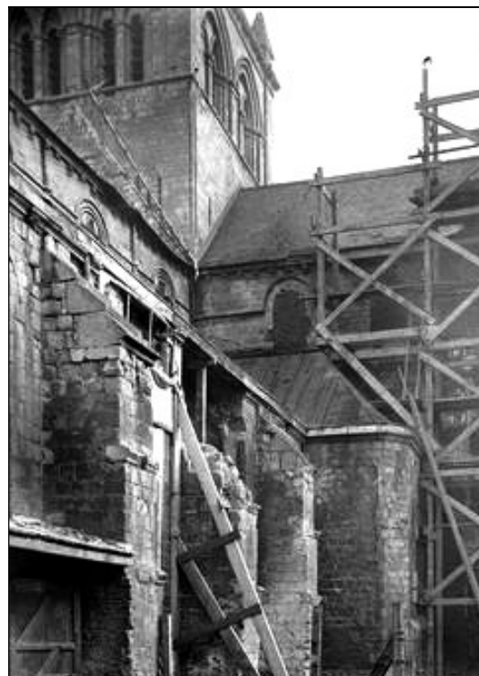
b - 1923. Même partie en cours de restauration MAP. Photothèque (cl. n° 26.304)
