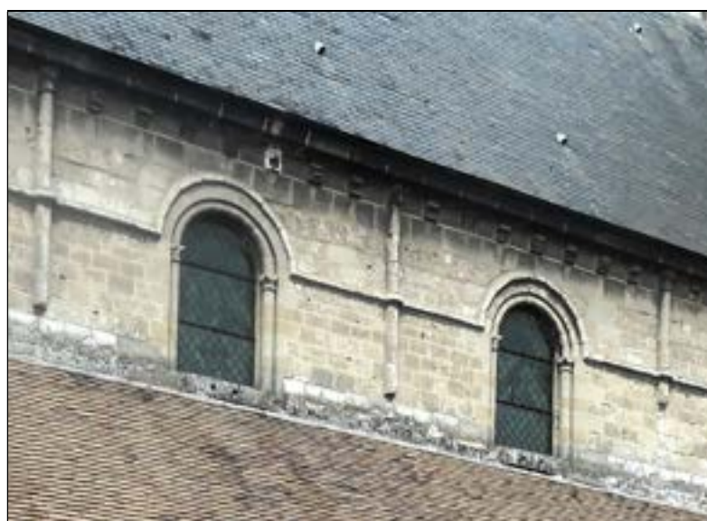
c – Mur sud de la nef
