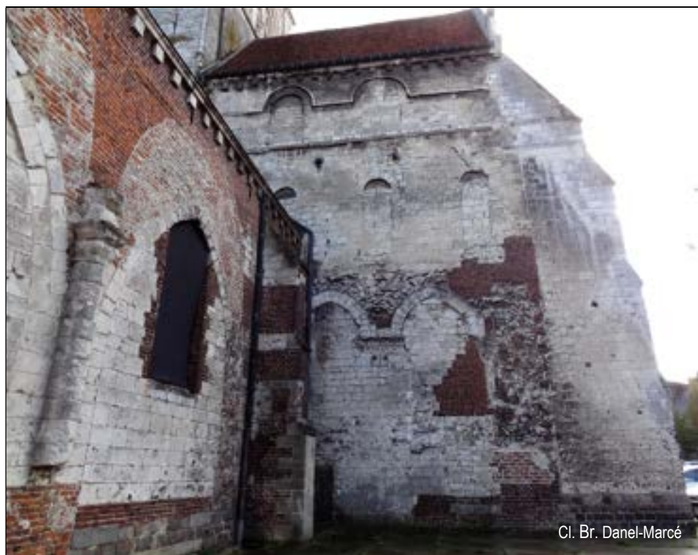
a – Mur oriental du bras nord et gouttereau du déambulatoire. Vestiges du bas-côté abattu : grandes-arcades, baies sur comble et fenêtre-hautes murées
