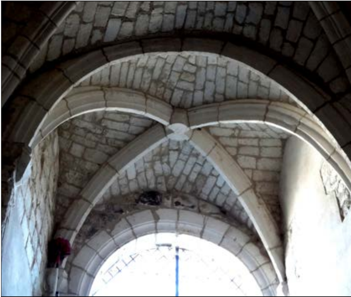
a – voûte d'ogives de la chapelle sud-est : nervures à profil prismatique (en haut : doubleau gothique à la jonction du voûtain roman aux arcs à listel entre deux tores)
