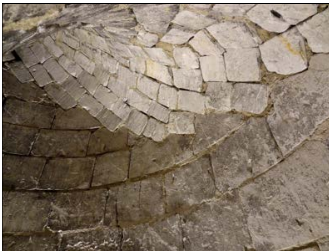
c – Insertion de la voûte dans le parement interne de la cage d'escalier le sommet du parement n'est plus linéaire, comme dans la vis méridionale menant vers la tribune, mais découpé en dents-de-scie, au gré de la retombée des rangs obliques de voussoirs Cliché Br. Danel-Marcé
