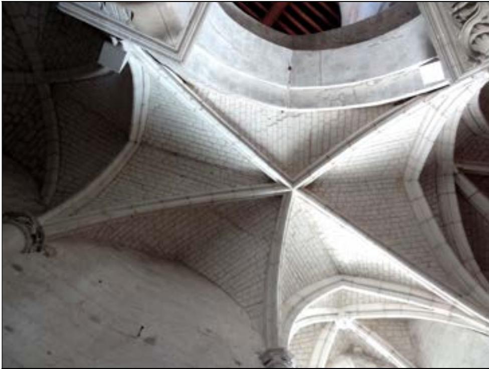
a – Lillers. Voûte de la travée V (nord) Cliché Br. Danel-Marcé
