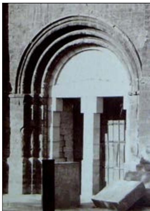
b – Photo de Mieusement (1887) (détail) Tympan modifié, linteau en bâtière et pilier central divisant en deux la baie AD-62 : 6FiC 949
