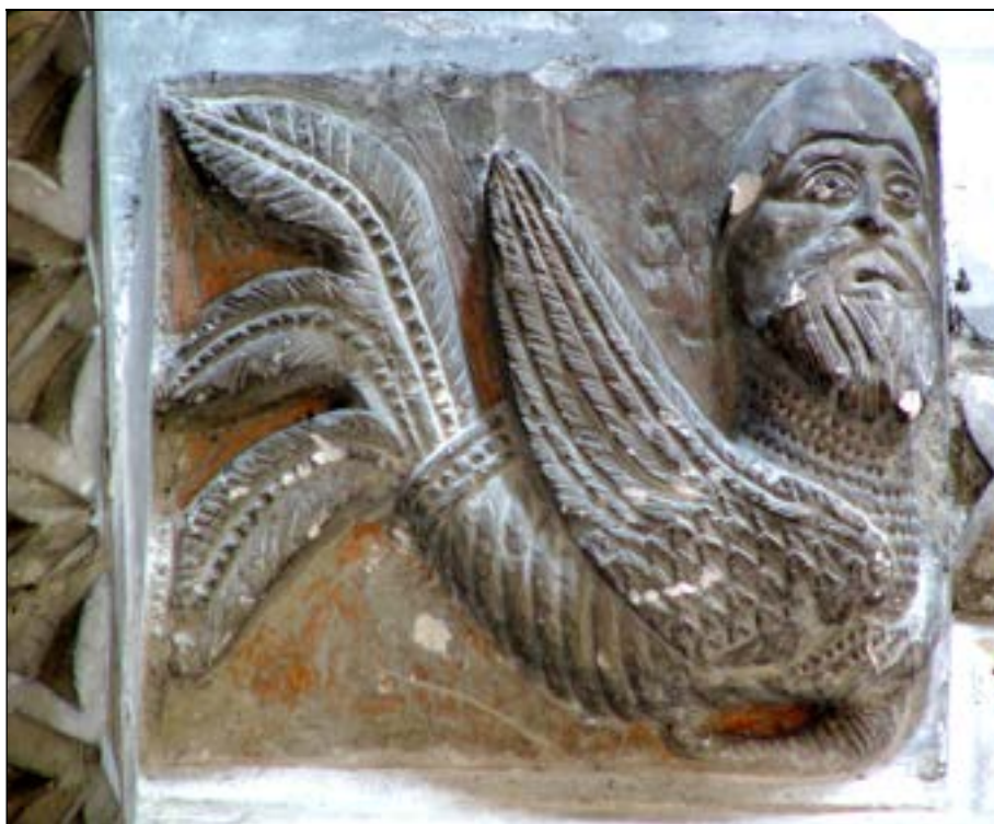
a - Console à la Sirène-oiseau mâle angle de la tribune occidentale et du gouttereau nord de la nef Cliché Br. Danel-Marcé
