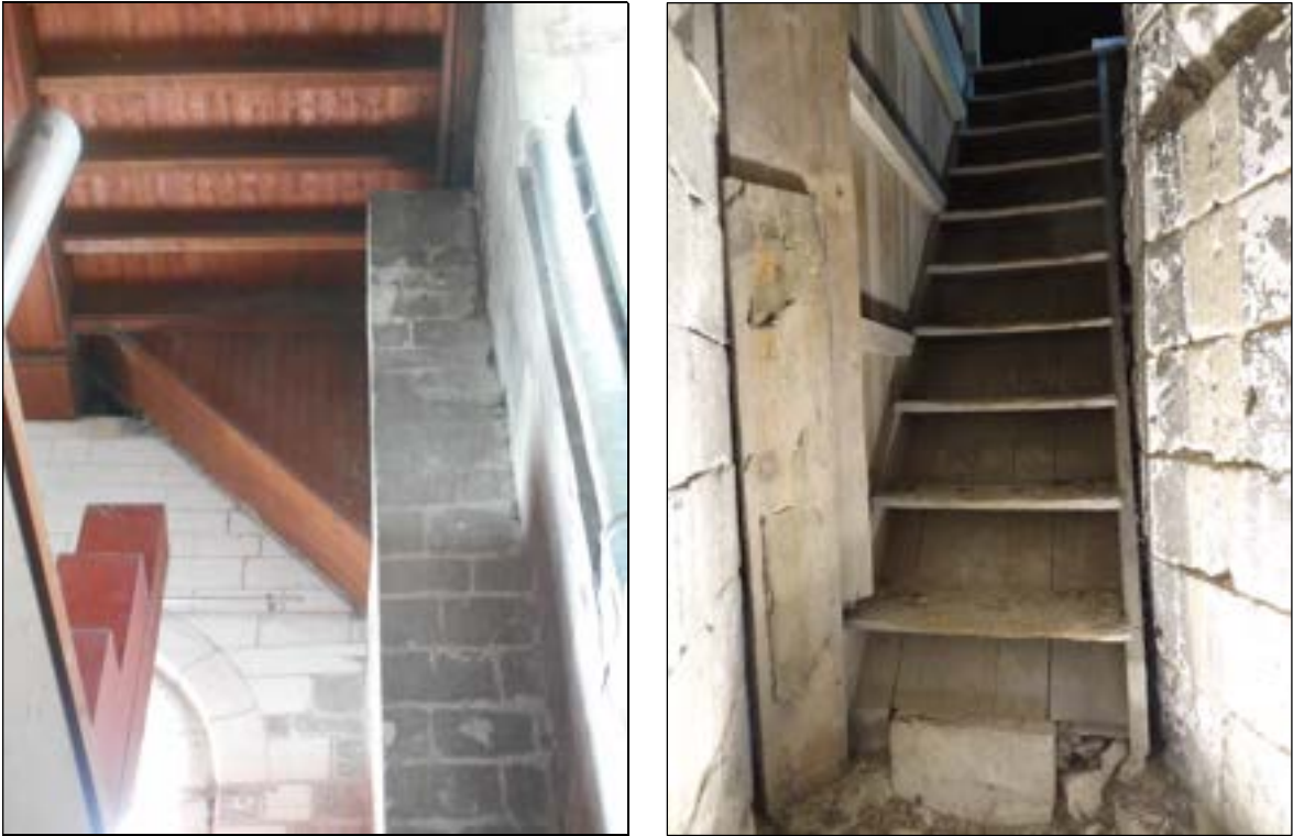
a- À gauche : empiètement dans l'angle nord-ouest de la tribune du massif de maçonnerie de la cage d'escalier en vis (en haut, à gauche : cage en charpente contenant la volée droite qui complète le dispositif). À droite : vue intérieure de cette volée droite. Clichés : (gauche) A. Timbert ; (droite) Br. Danel-Marcé
