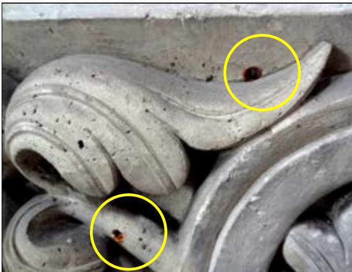
b – Chapiteau 172 grandes-arcades du chœur (en médaillons) Traces de rouille de la tête de clou apparaissant sous le plâtre de restauration. Cliché Br. Danel-Marcé
