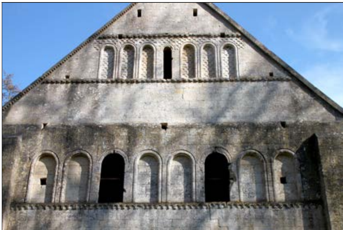
a – Thaon (Calvados). Église Saint-Pierre (premier tiers du XII e s.) Façade occidentale : baies superposées en deux registres Cliche : Br. Danel-Marcé
