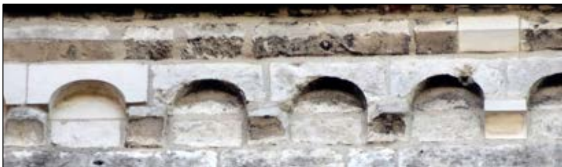
b – Labeuvrière (P.-de-C.). Église Sainte-Christine-de-Suède Corniche du clocher, face ouest (2 e moitié du XII e s.) ; tablette sur arcature cintrée vide Cliché Br. Danel-Marcé
