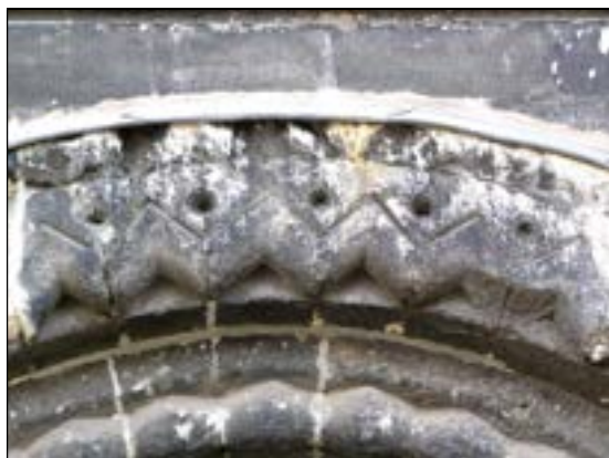
a – Lillers. Portail du bras nord voûture à bâtons-rompus Cliché Br. Danel-Marcé
