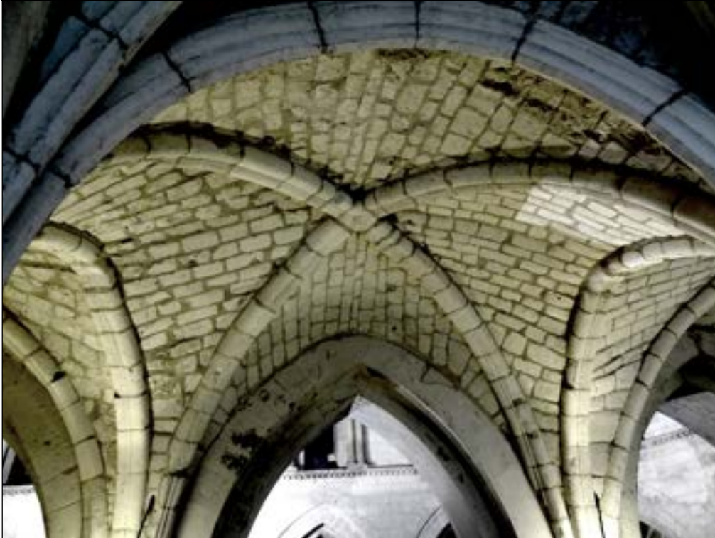
a – Lillers. arcs d'ogives et doubleaux à listel entre deux tores travée IX - côté sud du déambulatoire Cliché Br. Danel-Marcé
