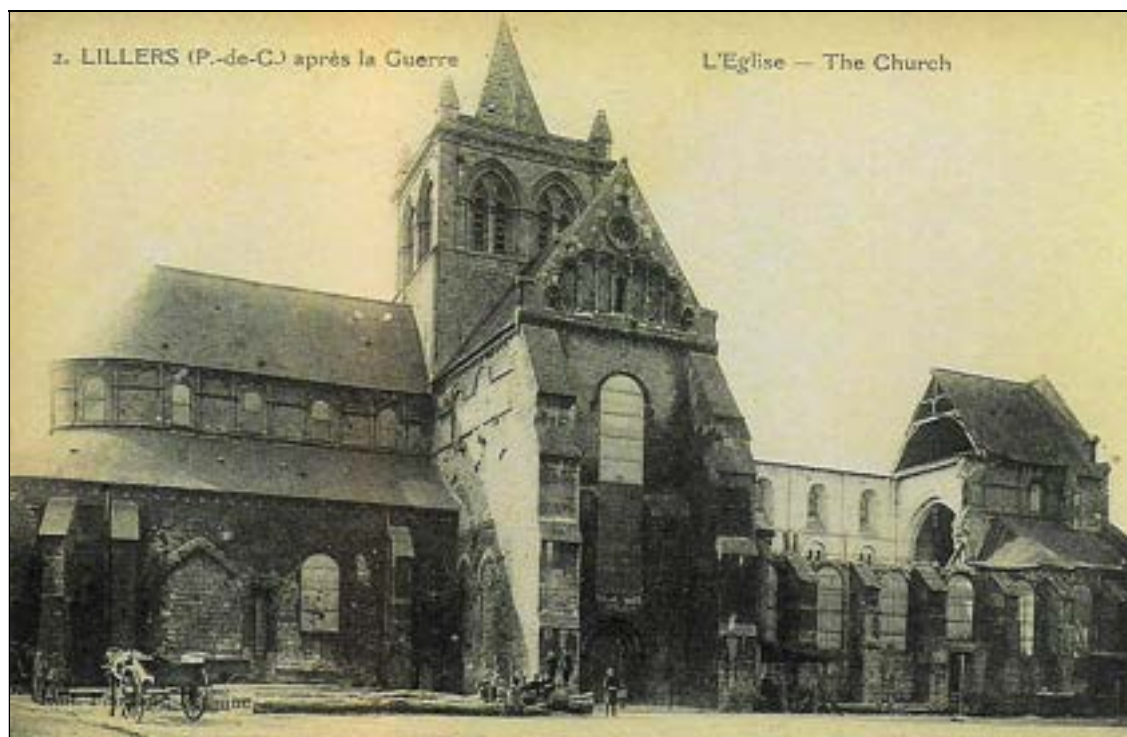
a – (c. juin 1919). Vue d'ensemble vers le sud-ouest. Travée de tribune intacte Carte postale (coll. particulière : M. R*, Lillers). Éd. Fauchois, Béthune
