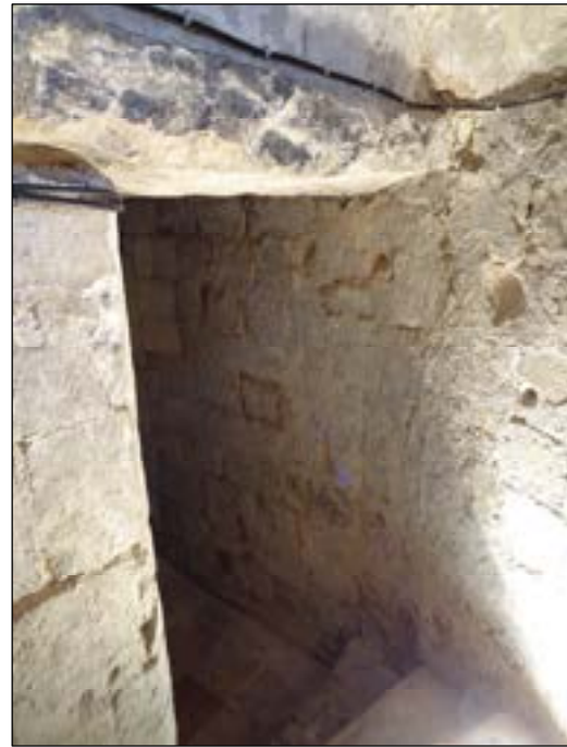
b – Tranche de la dalle 5 (côté cage) Cliché Br. Danel-Marcé
