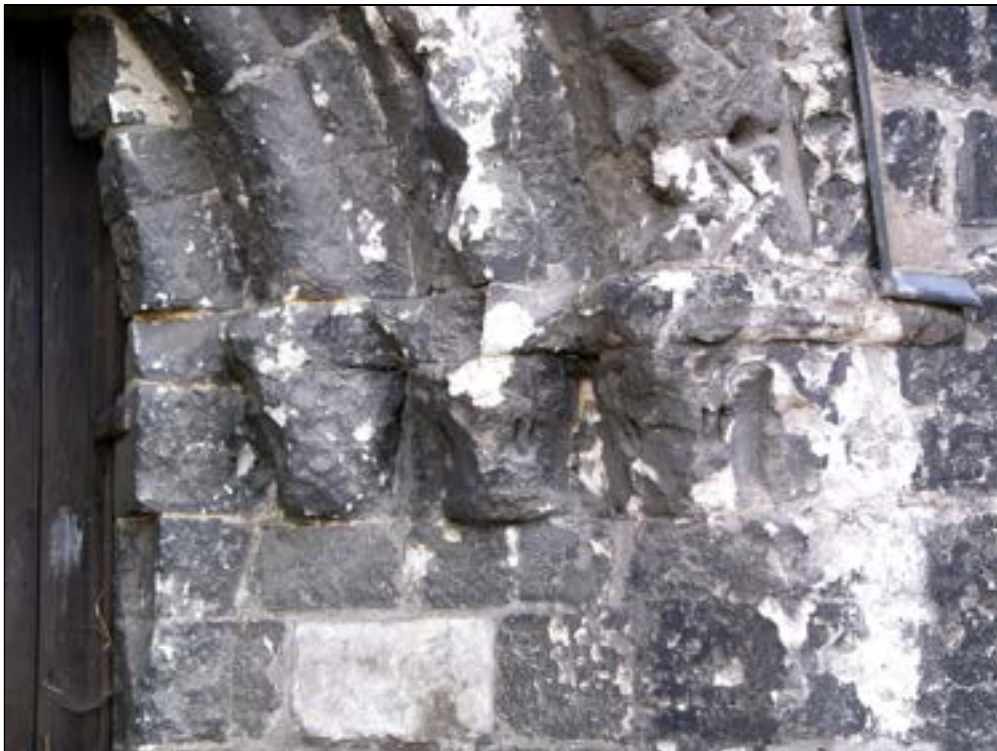
b – Ébrasement de droite : chapiteaux érodés recevant les voussures Cliché : Br. Danel-Marcé
