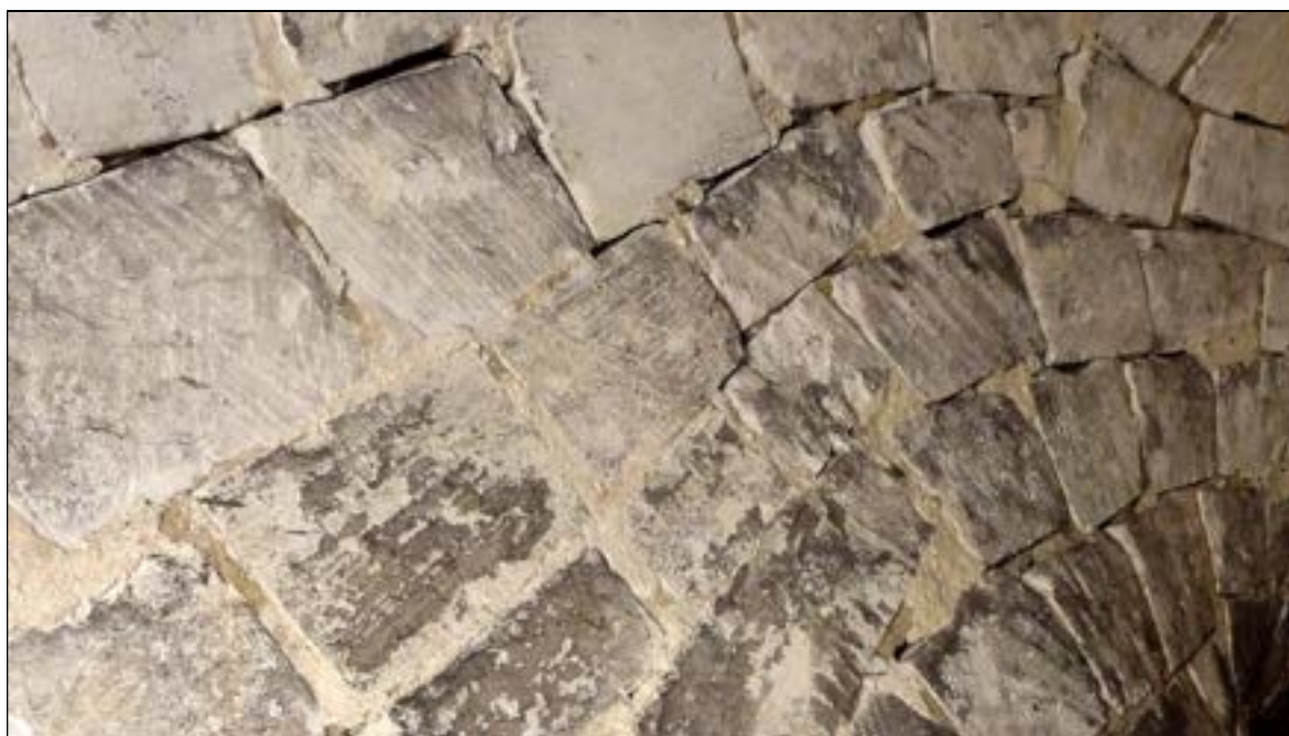
b – Berceau hélicoïdal de l'escalier vers le comble de la nef (massif occidental) Diverses tailles layées sur l'intrados des voussoirs : droites, obliques et croisée. Cliché Br. Danel-Marcé
