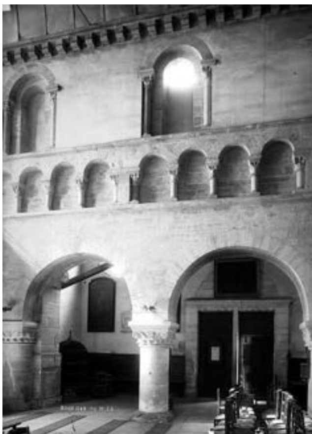
a – Maule (Yvelines) Église Saint-Nicolas c. 1090-1120 « Travée de la nef » Mur nord. Colonnes des grandes-arcades
