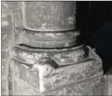
a – base à scotie surcreusée et griffes tribune occidentale. support fort A' 2 Cliché et dessin Br. Danel-Marcé
