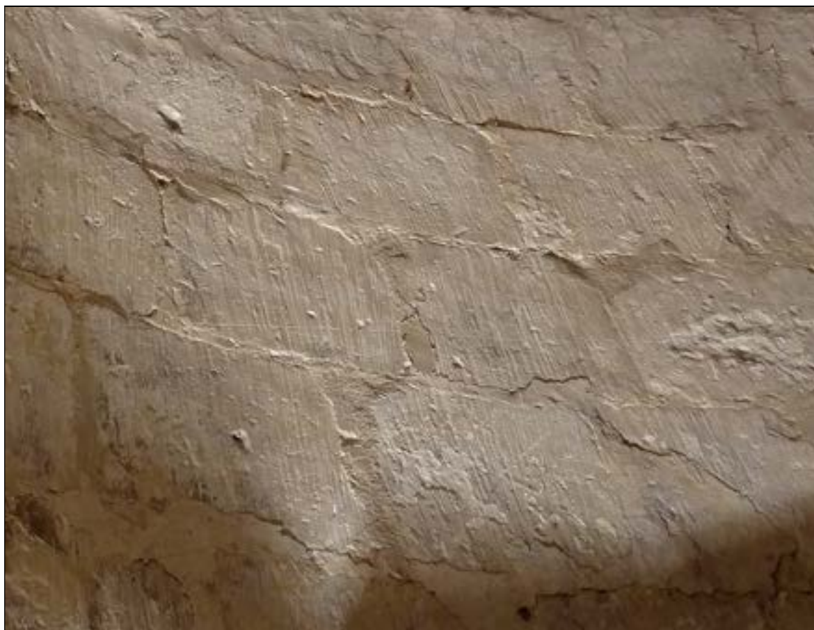
b – Parement du mur de la cage d'escalier en vis de la tribune occidentale Taille layée droite dressée verticalement au marteau taillant (impacts clairsemés). Cliché Br. Danel-Marcé
