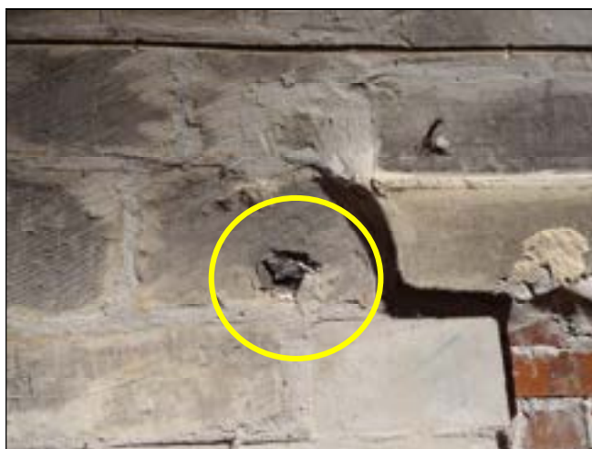
a – Silex émergeant d'un bloc de craie Revers de la baie n° 29, comble du déambulatoire Cliché Br. Danel-Marcé
