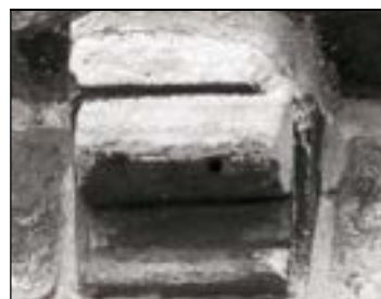
c – modillon CC-27 chœur. corniche nord Cliché Br. Danel-Marcé
