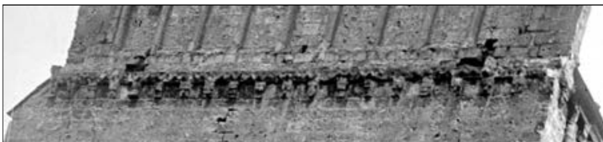
c. 1909-1911. État avant la restauration effectuée par Paquet (courant 1911) Vingt modillons. Aucun changement par rapport à l'état précédent. « Lillers. Façade ouest » (détail). Cliché : H. Deneux (MAP, DNX08009, base Mémoire sap01_dnx08009_p)
