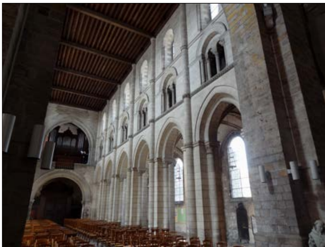
a – Mur nord en direction de l'ouest. Cliché : Br. Danel-Marcé
