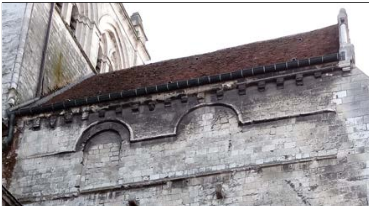
a – Mur gouttereau oriental Les deux baies sont murées Cliché : Br. Danel-Marcé
