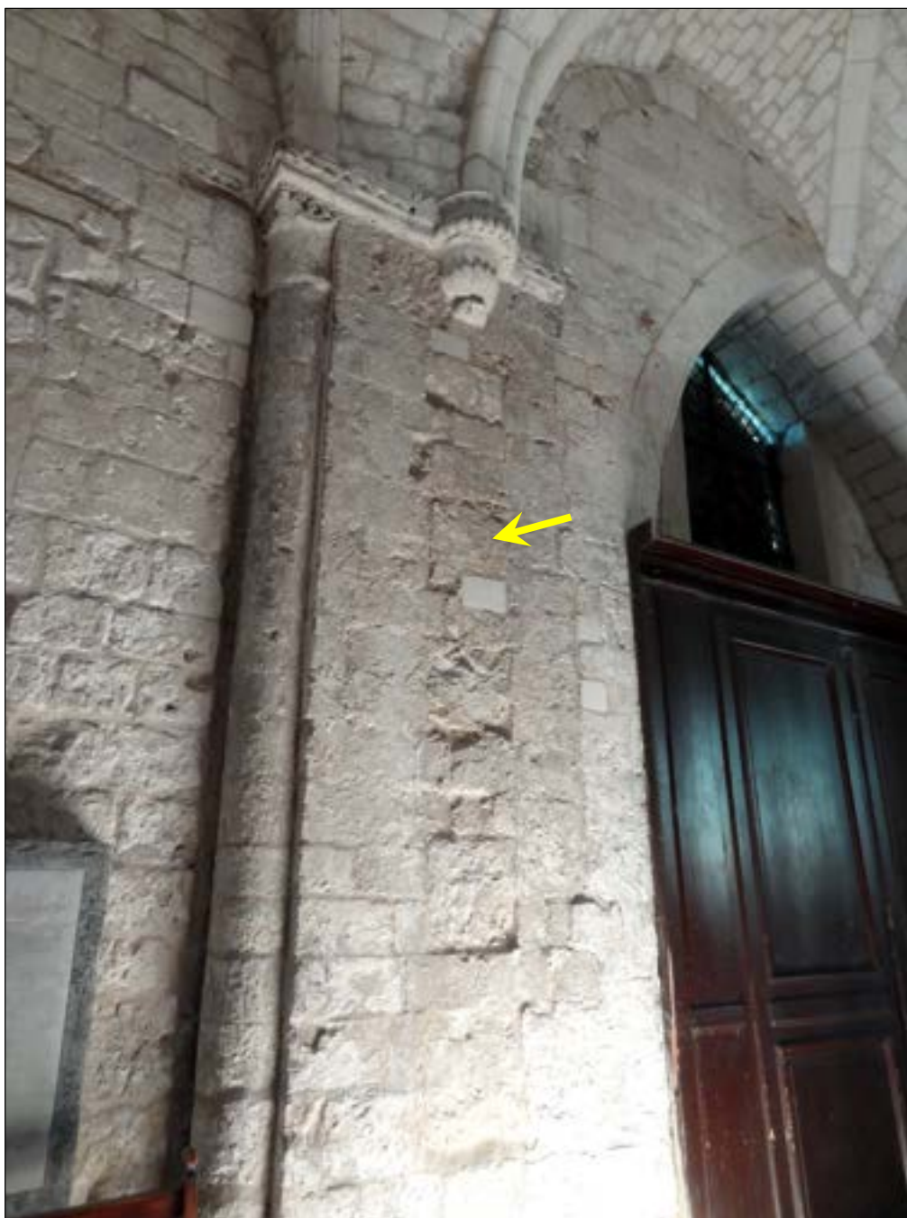
Fig. 159 – Déambulatoire (mur d'enveloppe nord). Support E 10
