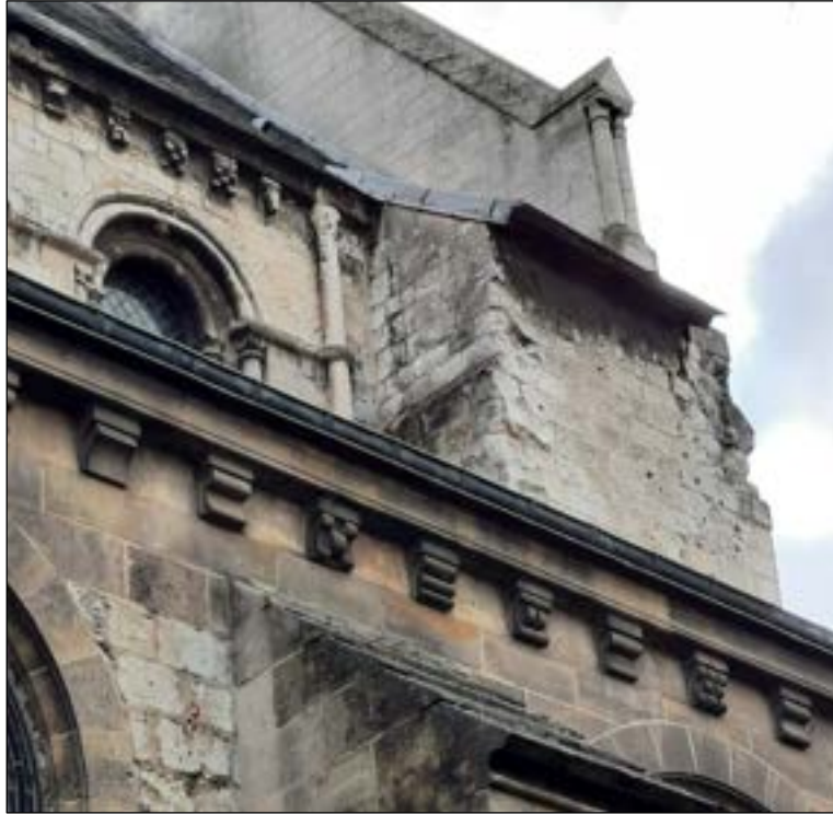
a – Vue de trois-quarts vers l'ouest (niveau des fenêtres-hautes) La face nord (à droite) ; la face orientale (à gauche) présente une retraite talutée Cliché : Br. Danel-Marcé
