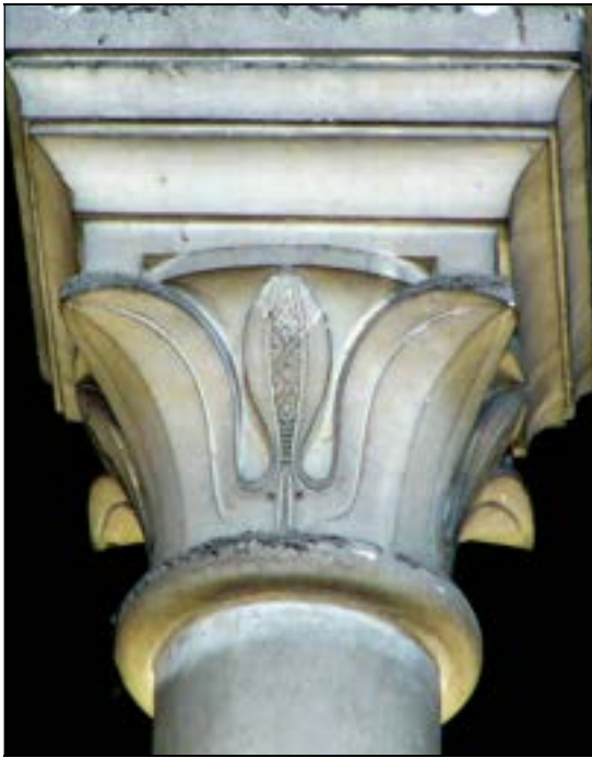
a – Lillers chapiteau d'ouverture sur comble chap. 94 . Nef, mur sud, 5 e travée Cliché Br. Danel-Marcé
