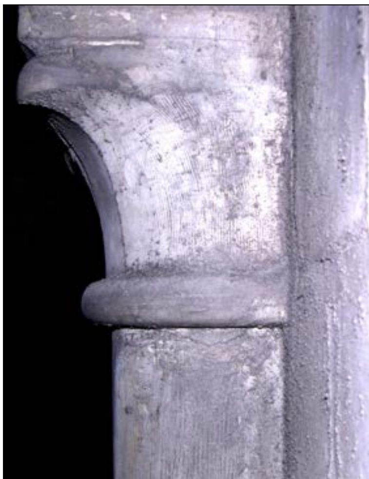
a – Gouttereau du chœur depuis le comble du déambulatoire Face aplanie au taillant droit (8 à 10 cm) du linteau de la baie n° 29. layage longitudinal serré. Cliché Br. Danel-Marcé
