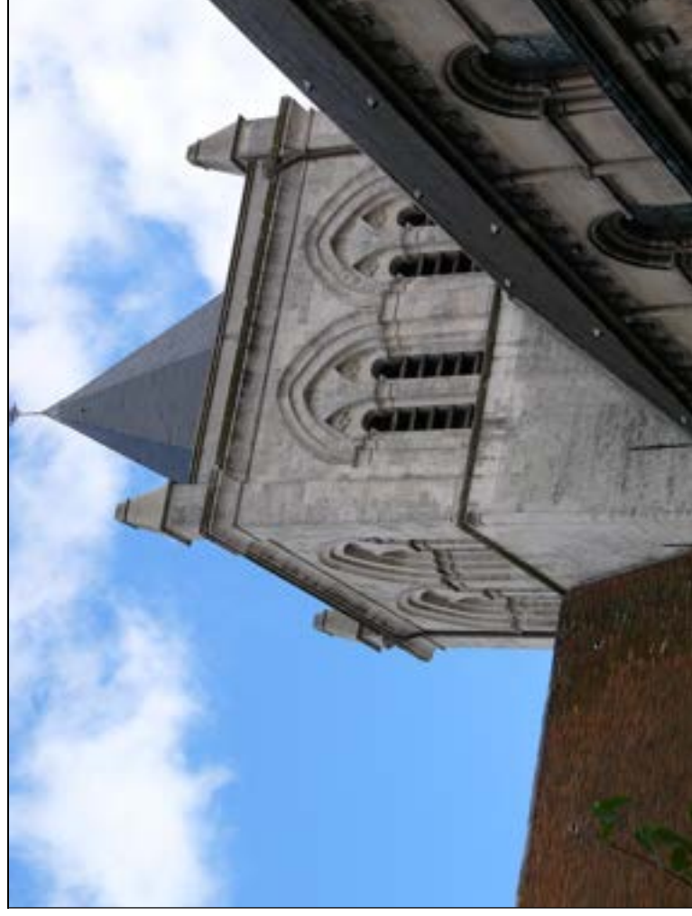
La tour de croisée, vue depuis le nord-ouest Cliché Br. Danel-Marcé
