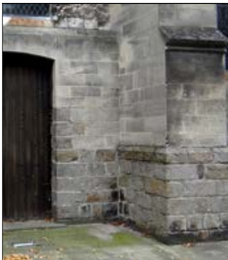
a – Bas-côté nord de la nef Soubassement en grès (XVII e s.) Cliché Br. Danel-Marcé
