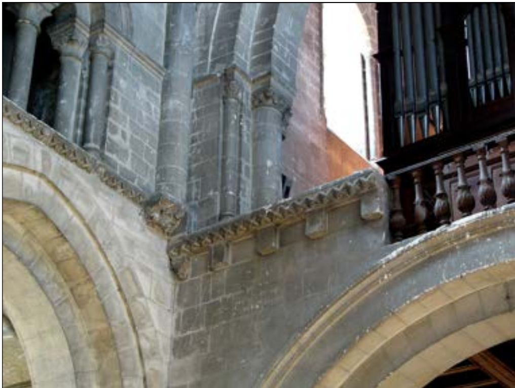
b- Vue de l'angle sud-ouest de la nef (à l'arrière-plan du garde-corps : fenêtre-haute méridionale de la tribune)
