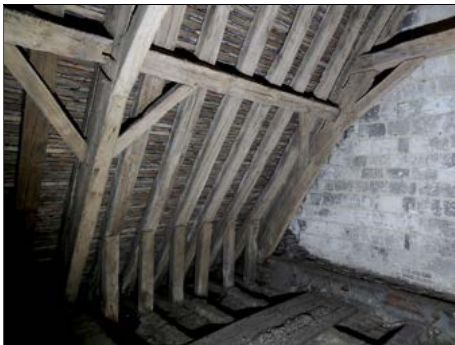
b – Élévation de la travée distale du versant ouest du bras nord. Cliché Br. Danel-Marcé Deux fermes principales encadrent les fermes secondaires. (De bas en haut) jambettes épaulant les chevrons ; contreventement : la panne médiane est maintenue par les aisseliers fixés de part et d'autre de la ferme principale ; (en haut à droite) premier faux-entrait de la ferme principale externe.
