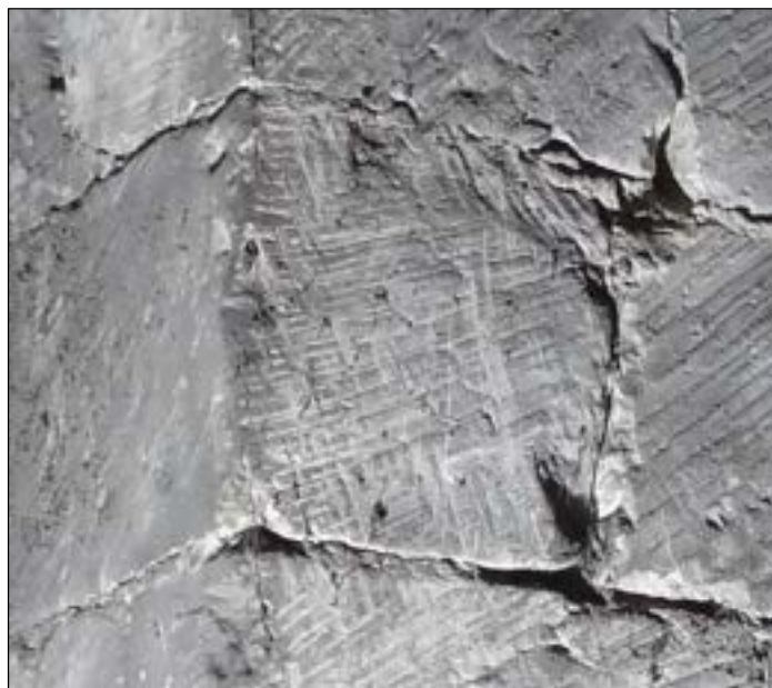
a – Parement du mur oriental du clocher vu depuis le comble du chœur Taille layée traversée (ou croisée) sur un élément du piedroit de la porte d'accès au comble. Cliché Br. Danel-Marcé
