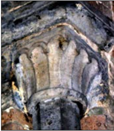
a – Bruges (Belgique. Flandre-Occ.) chapelle Saint-Basile chapiteau de la nef (1 re travée ouest) Cliché Br. Danel-Marcé
