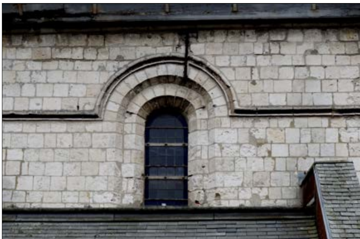
a – Cappelle-Brouck (Nord). Église Saint-Jacques (c. 1169) Fenêtre-haute du mur gouttereau nord de la nef. Cordon mouluré prolongeant l'archivolte. Cliché : Br. Danel-Marcé
