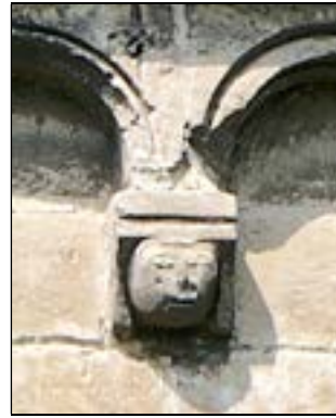
c – Guarbecque (P.-de-C.) église Saint-Nicolas modillon du clocher Cliché Br. Danel-Marcé
