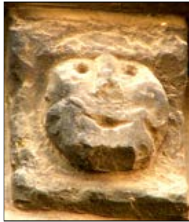
a – modillon CN-64 corniche du bas-côté nord de la nef Cliché Br. Danel-Marcé
