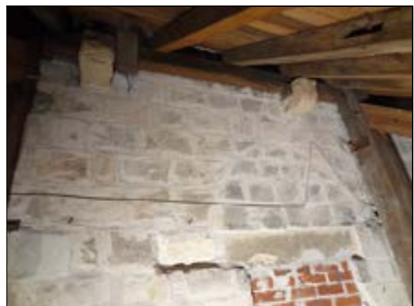
c – Panne faitière fixée par deux gonds en grès au-dessus de la baie 25 Versant nord (à l'aplomb de la travée I) Cliché Br. Danel-Marcé
