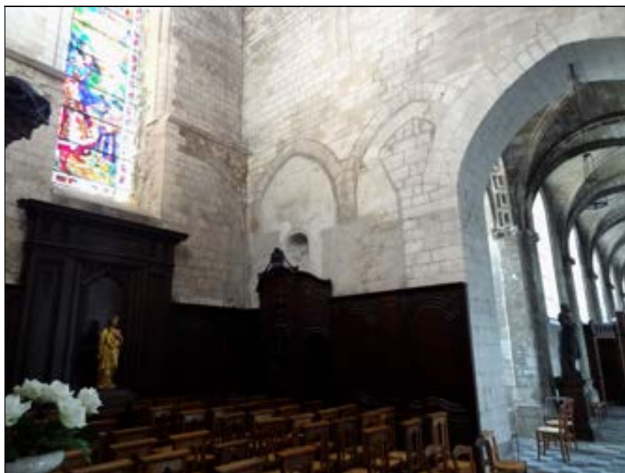
b – Bras sud, mur ouest (intérieur)
