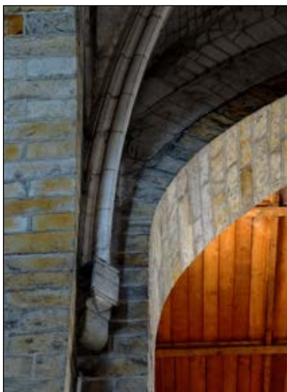
b – culot de la pile nord-ouest (A 8) Cliché Br. Danel-Marcé
