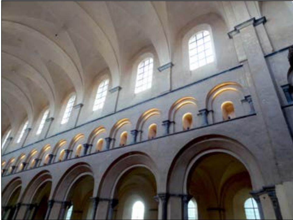
a – Tournai (Hainaut, Belgique). Cathédrale Notre-Dame (début du XII e s.) Mur nord de la nef. Arcature plein-cintre ininterrompue du triforium Cliché : Br. Danel-Marcé
