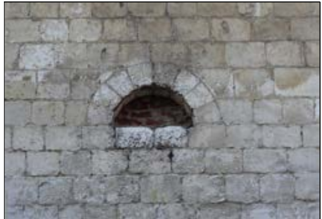
c – Acquin-Westbécourt (P.-de-C.) Ferme du château (XV e s.) Demi-oculus (muré) du gouttereau d'une étable Cliché : Br. Danel-Marcé
