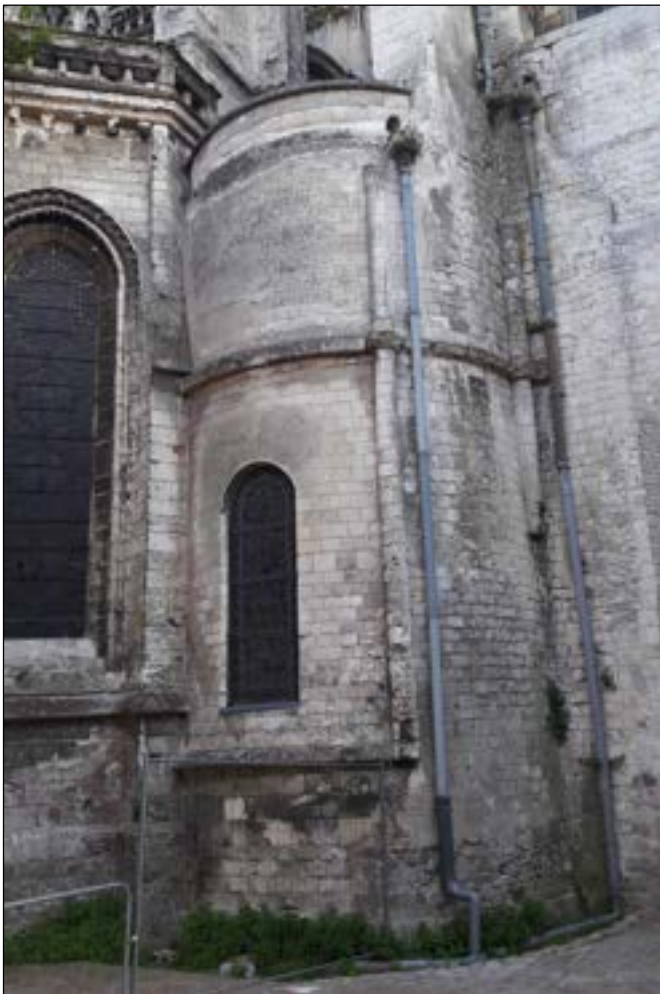
b – Saint-Omer (P.-de-C.) Cathédrale Notre-Dame (extérieur) : Chapelle orientée du bras nord du transept, depuis le nord-est (vestiges de la collégiale romane du XII e siècle). Les colonnes engagées servant de contreforts ont été conservées. Il est envisageable que les chapelles rayonnantes de la collégiale de Lillers aient été érigées sur un modèle analogue, sinon identique.
