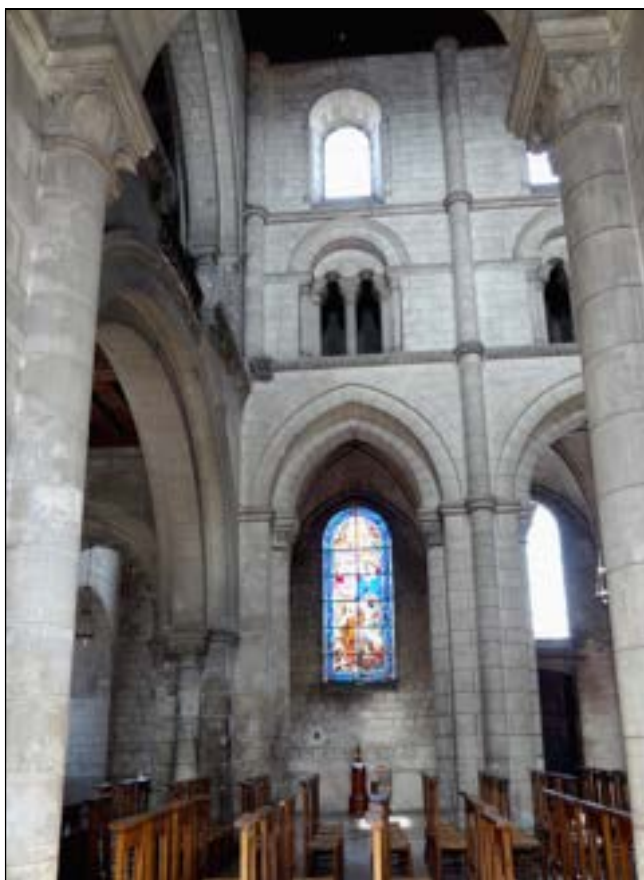
Fig. 141 – Lillers. Les trois niveaux d'élévation de la nef
