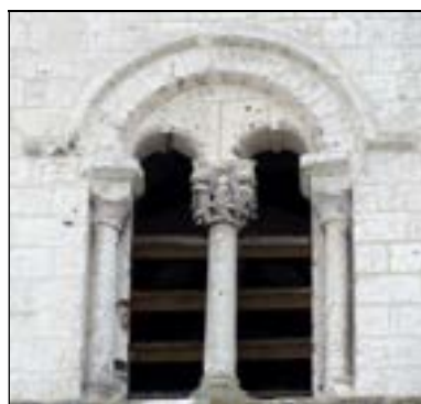
c – Esquerdes (P.-de-C.) Église Saint-Martin Clocher, baie à 3 colonnettes Cliché : Br. Danel-Marcé
