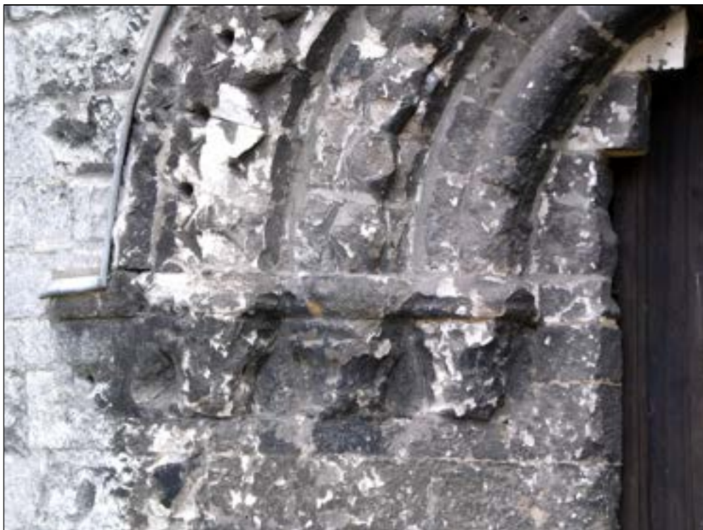
a – Ébrasement de gauche : chapiteaux érodés recevant les voussoires On parvient à distinguer çà et là des restes de volute d'angle, d'échancrure arrondie dotée d'un motif en étamine, tous détails conformes au style des chapiteaux romans de la collégiale.
