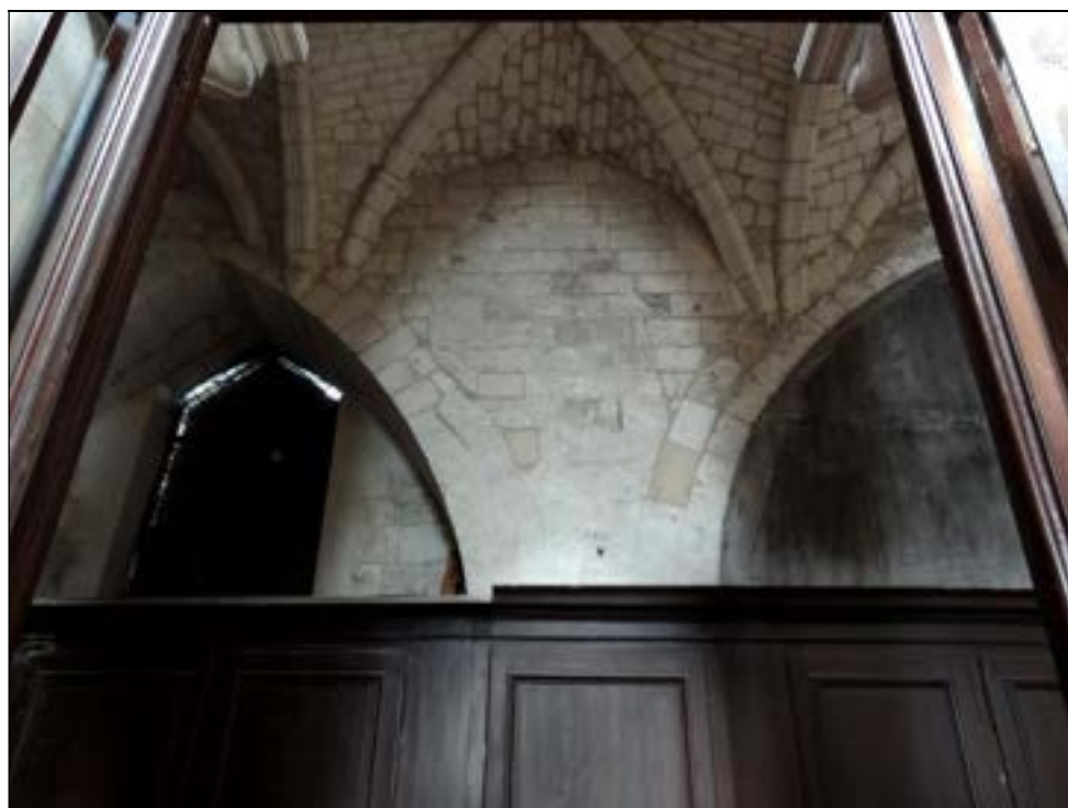
b – Vue intérieure (travées II à IV du bas-côté nord du chœur). Revers des deux arcades murées : on distingue la reprise « audacieuse » des travées de voûtes romanes dont les arcs, privés de leur support primitif, s'appuient sur les vousoirs des arcs gothiques Cliché Br. Danel-Marcé
