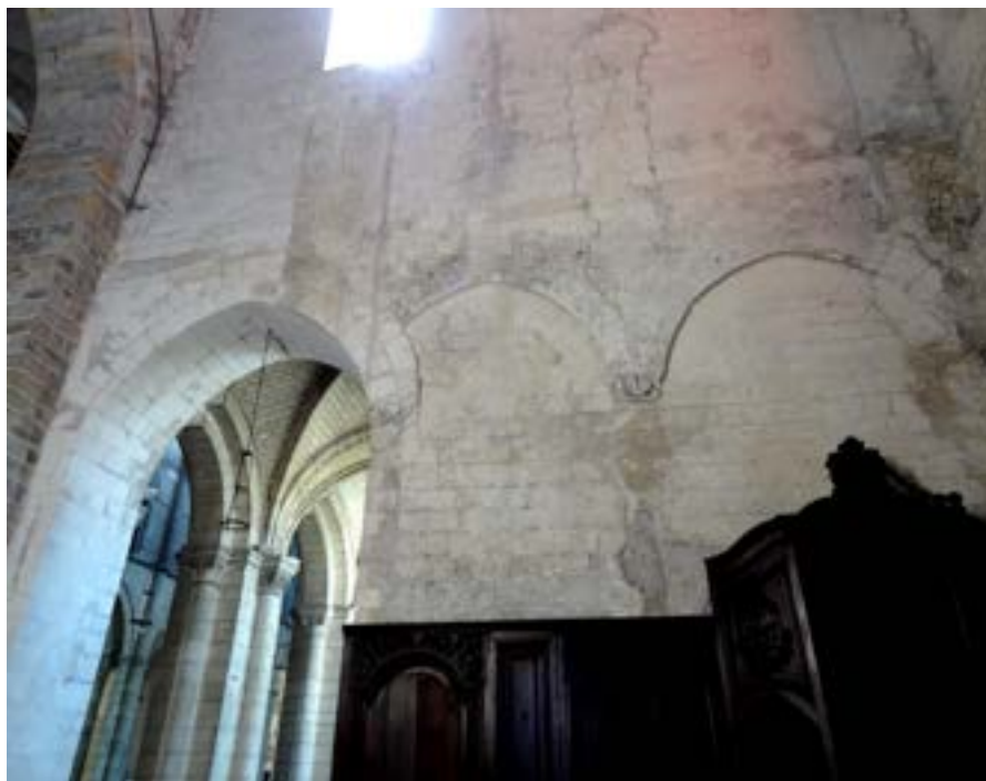
a – Bras nord, mur ouest (intérieur)
