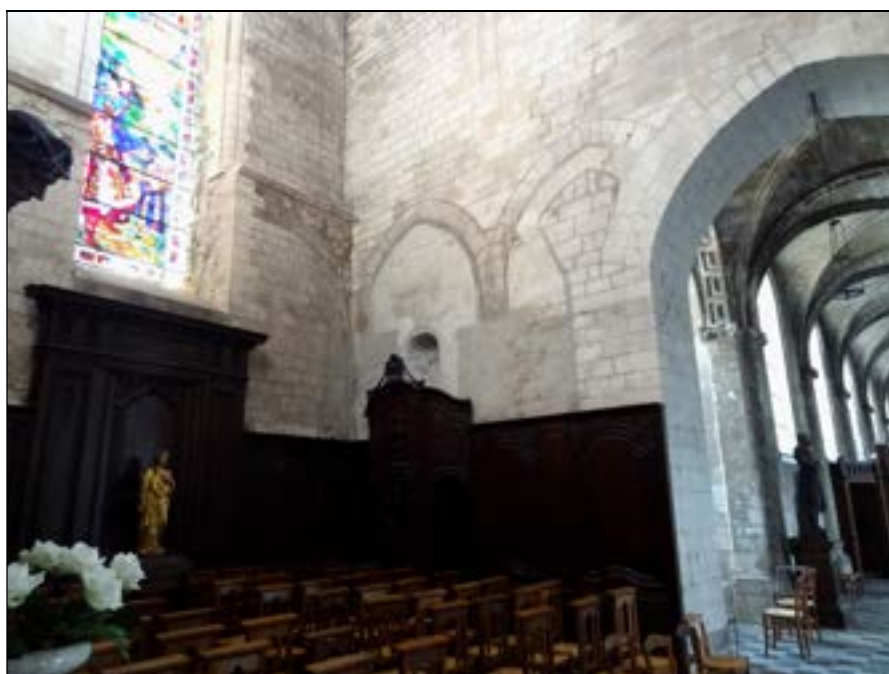
b – Bras sud, mur ouest (intérieur)
