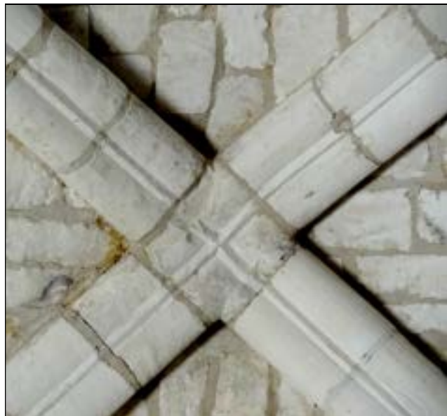
c – Lillers. clef de voûte profil « A » - travée III - côté nord du déambulatoire Cliché Br. Danel-Marcé
