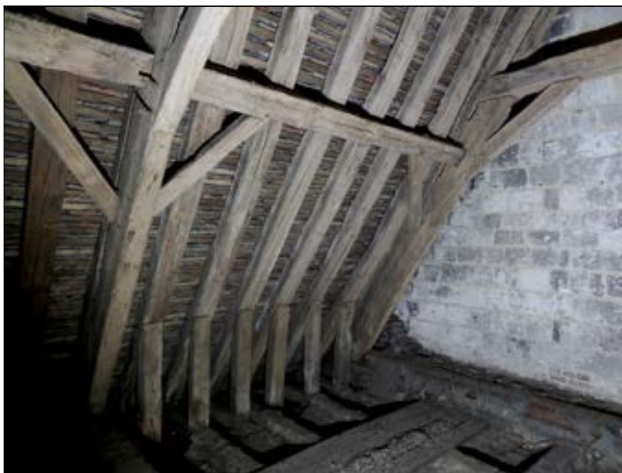
b – Élévation de la travée distale du versant ouest du bras nord. Cliché Br. Danel-Marcé Deux fermes principales encadrent les fermes secondaires. (De bas en haut) jambettes épaulant les chevrons ; contreventement : la panne médiane est maintenue par les aisseliers fixés de part et d'autre de la ferme principale ; (en haut à droite) premier faux-entrait de la ferme principale externe.
