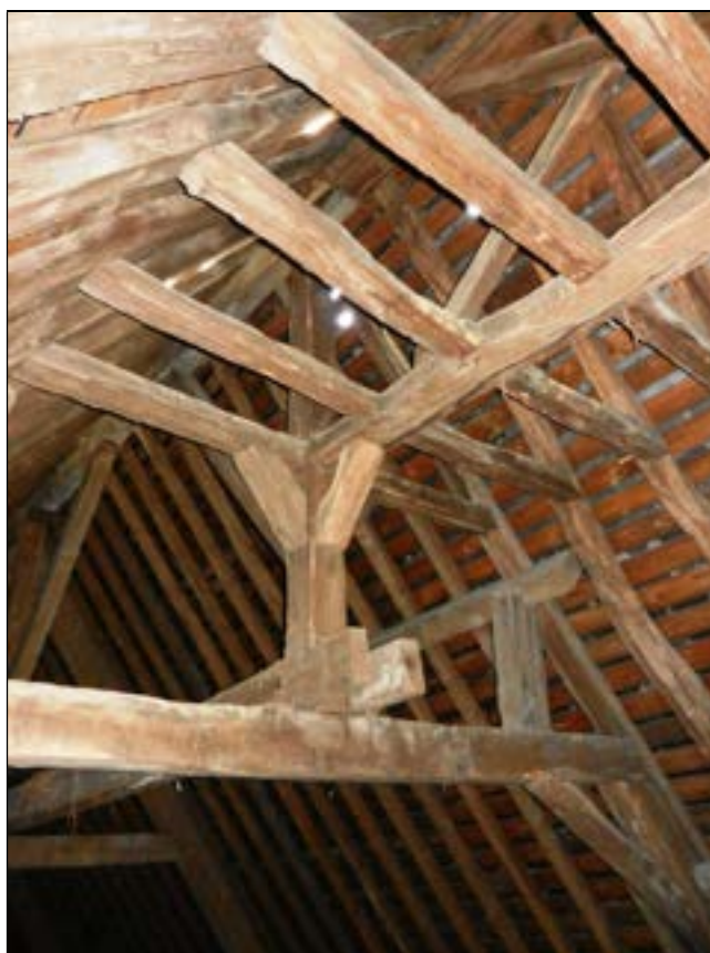
a – Bras nord. Vestiges du solin de la charpente primitive La pente était originellement moins accentuée ( 45^\circ , contre 56^\circ ). Cliché Br. Danel-Marcé
