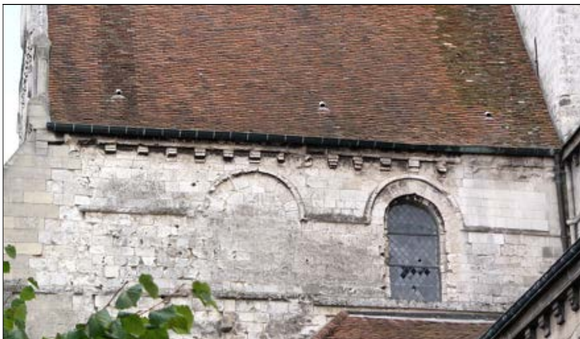
b – Mur gouttereau occidental Baie distale murée, baie proximale ouverte Cliché : Br. Danel-Marcé
