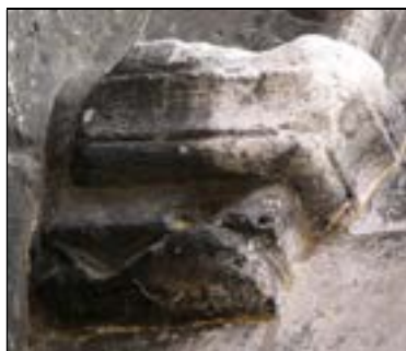
Chap. 153 Bras nord, mur oriental (angle sud)
