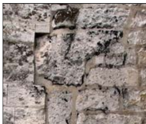
Chap. 151 Bras nord, mur occidental (angle nord)
