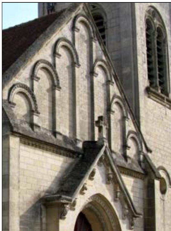
a – Nouvion-Vingré (Aisne). Église Sainte-Marie (XII e s.) Façade occidentale : la hauteur des baies s'adapte à la pente des rampants © Markus 3 @ wikimedia.org
