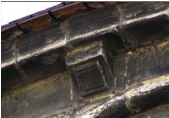
b – Lillers. Comble du chœur corniche à modillons Cliché Br. Danel-Marcé
