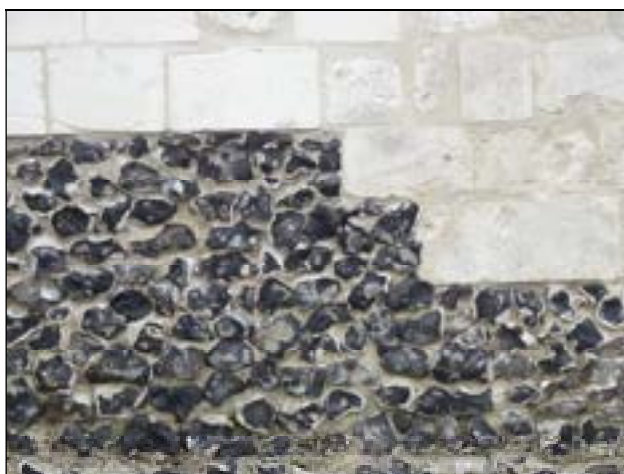
c – Esquerdes (P.-de-C.) Église Saint-Martin Maçonnerie en silex Soubassement du mur méridional de la nef Cliché Br. Danel-Marcé
