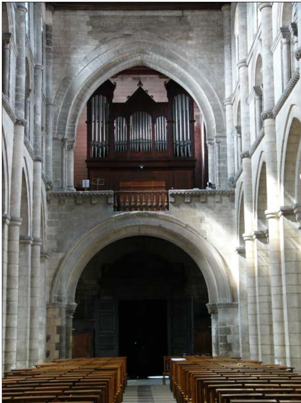
Ensemble du vestibule et de la tribune occidentale depuis la nef Cliché : Br. Danel-Marcé
