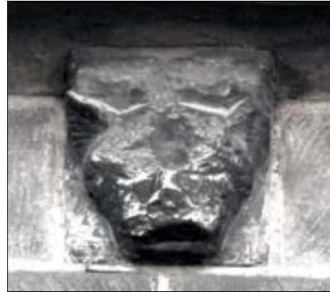
d – modillon CNN-32 nef. corniche du gouttereau nord Cliché Br. Danel-Marcé
