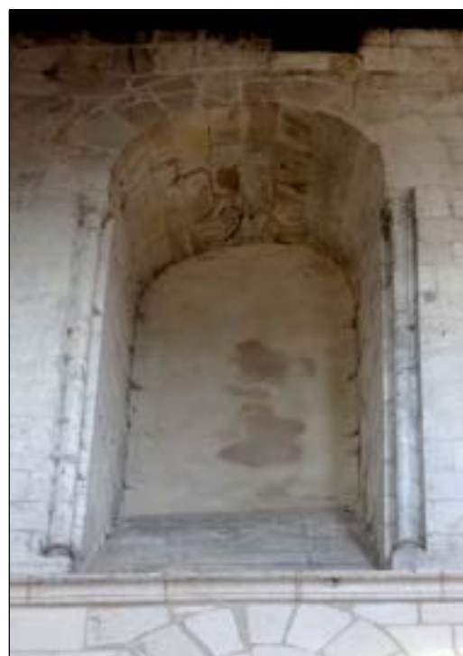
d – Transept, bras sud Baie murée du gouttereau oriental Cliché : Br. Danel-Marcé
