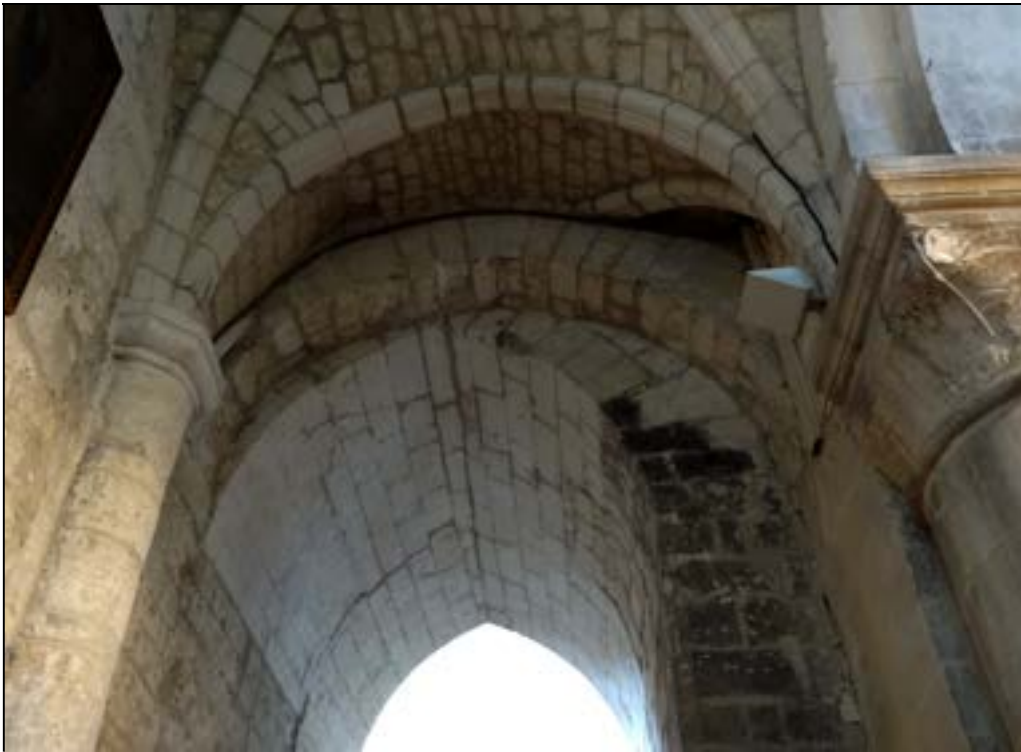
c – arcs de renforcement plaqués contre l'intrados de la voûte primitive de la travée XI Cliché Br. Danel-Marcé
