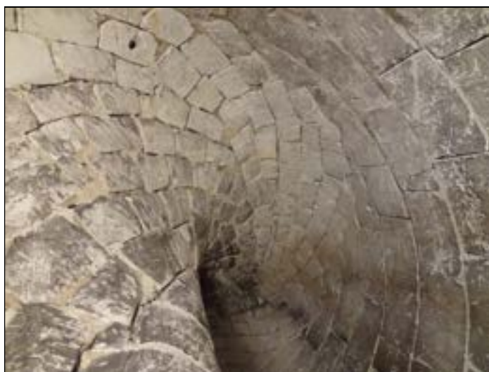
b – Insertion de la voûte dans le noyau les voussoirs s'insèrent dans une mortaise verticale ménagée latéralement dans le corps du noyau Cliché Br. Danel-Marcé
