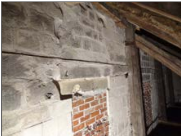
b – Vue en enfilade des premières travées du versant nord (vers l'ouest) Niveau des baies (de gauche à droite) 29, 27 et 25 Cliché Br. Danel-Marcé
