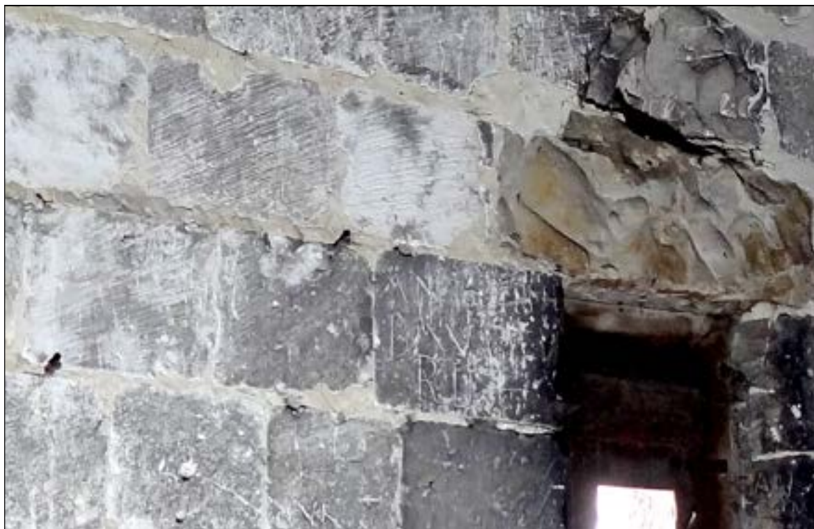
a – Parement du revers du pignon du bras nord Traces de layage oblique sur les blocs de calcaire. Linteau de la lucarne taillé dans un poudingue. Cliché Br. Danel-Marcé
