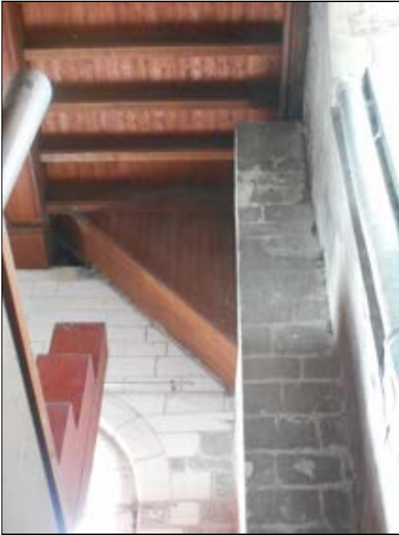
a- À gauche : empiètement dans l'angle nord-ouest de la tribune du massif de maçonnerie de la cage d'escalier en vis (en haut, à gauche : cage en charpente contenant la volée droite qui complète le dispositif). À droite : vue intérieure de cette volée droite. Clichés : (gauche) A. Timbert ; (droite) Br. Danel-Marcé
