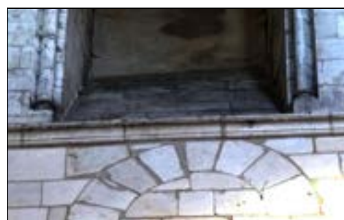
e – Lillers : bras sud du transept bandeau du mur oriental Cliché Br. Danel-Marcé
