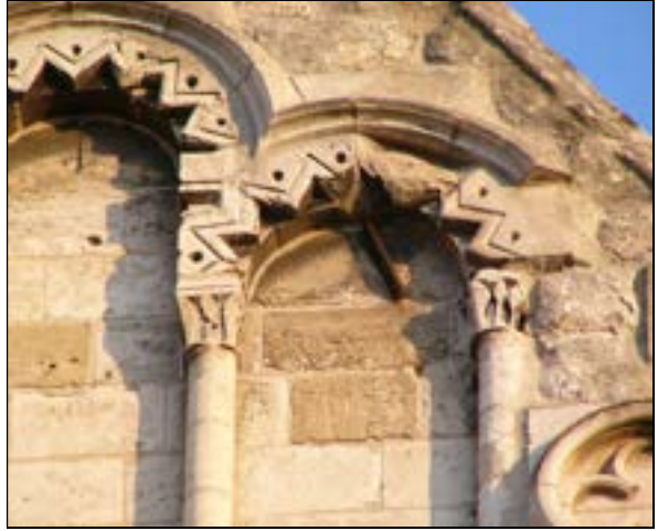
b – Lillers. Pignon du bras nord voissures de l'arcature aveugle Cliché Br. Danel-Marcé
