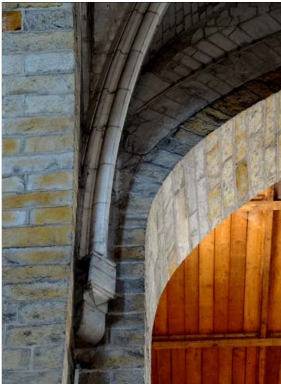
Finition du parement de grès des arcs de la croisée : aspect broché fin Pile nord-ouest de la croisée (A 8), vers le bras nord du transept Cliché Br. Danel-Marcé
