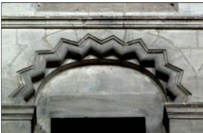
a – Lillers. Chœur Ouvertures sur comble Archivolte de l'arc de décharge à bâtons-rompus Cliché Br. Danel-Marcé
