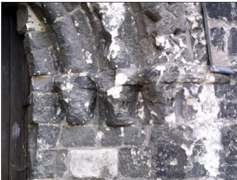
b – Ébrasement de droite : chapiteaux érodés recevant les voussoires
