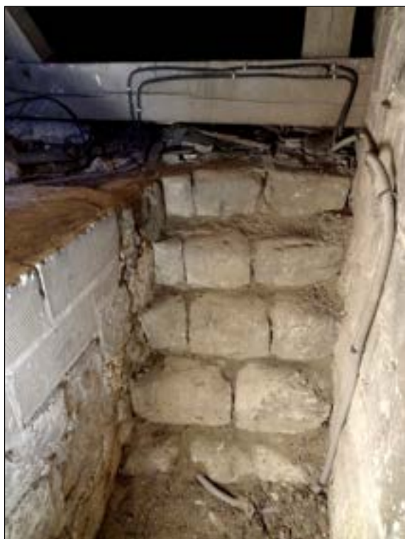
a – Escalier du comble du bas-côté nord Cliché Br. Danel-Marcé
