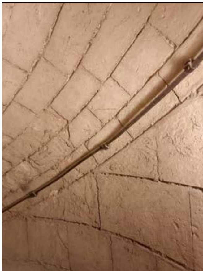
Fig. 188 – Vis voûtées en berceau hélicoïdal. Comparaisons Saint-Omer (P.-de-C.). Cath. Notre-Dame. Vis romane du bras nord (c. 1052-1100)
