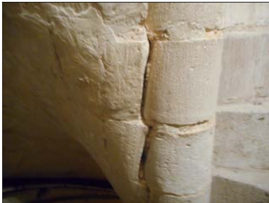
b – Mantes-la-Jolie (Yvelines). Collégiale Notre-Dame. Escalier nord Insertion des voussoirs dans le noyau (c. 1175-1180) Cliché A. Timbert
