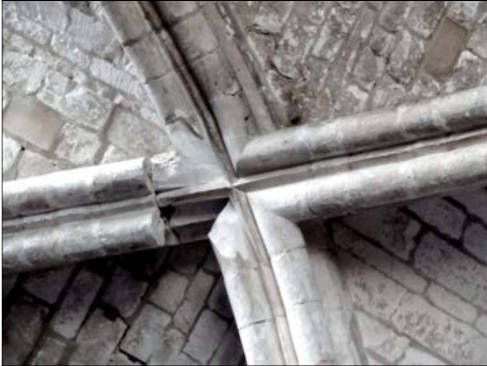
a – Beauvais (Oise). Collégiale Saint-Étienne arcs d'ogives à arête entre deux tores posés sur bandeau bas-côté sud de la nef. travée II. Cliché Br. Danel-Marcé
