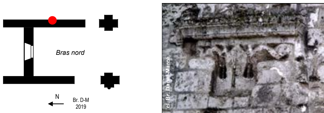
b – Chapiteau 154 vestiges des chapiteaux des bas-côtés du transept bras nord, mur oriental, colonne médiane
