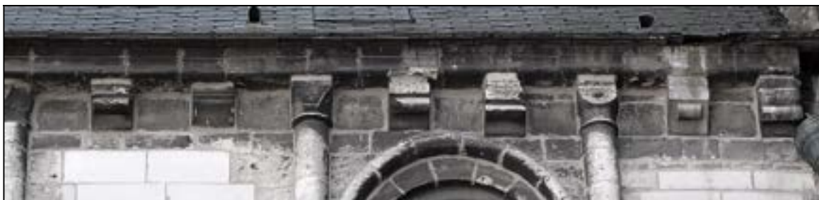
a – Lillers. Corniche du chœur, 1 re travée nord-ouest Tablette rectiligne moulurée ; mésopes nues Cliché Br. Danel-Marcé
