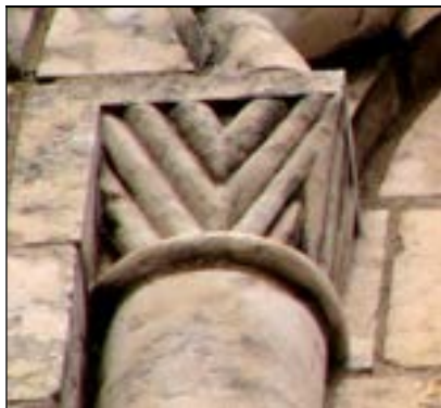
d – Lillers. pignon bras sud chapiteau d'arcature aveugle cl. Br. Danel-Marcé
