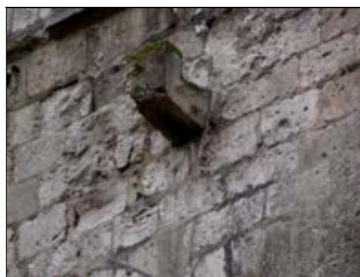
d – Gonds de grès en équerre pour fixation des pannes faîtières de la charpente (à gauche) Comble du déambulatoire Fixation des faîtières en place Cliché Br. Danel-Marcé
