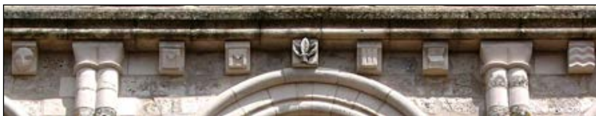
d – Heuchin (P.-de-C.). Église Saint-Martin Corniche du pignon de la façade (1 re moitié du XII e s.) Tablette rectiligne moulurée ; mésopes nues Cliché Br. Danel-Marcé
