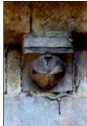
c – Lavacquerie (Oise). église Saint-Firmin modillon en « grelot » du gouttereau de la nef © D. Vermand-eglisesdeloise.com
