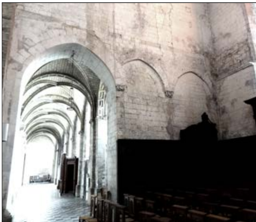
a – Vestiges des grandes-arcades autrefois ouvertes sur le bas-côté occidental À droite, arcades médiane et distale murées ; à gauche, l'arcade qui a été élargie empiète sur la largeur de l'arcade médiane pour pouvoir s'ajuster aux dimensions du nouveau bas-côté nord de la nef Cliché Br. Danel-Marcé
