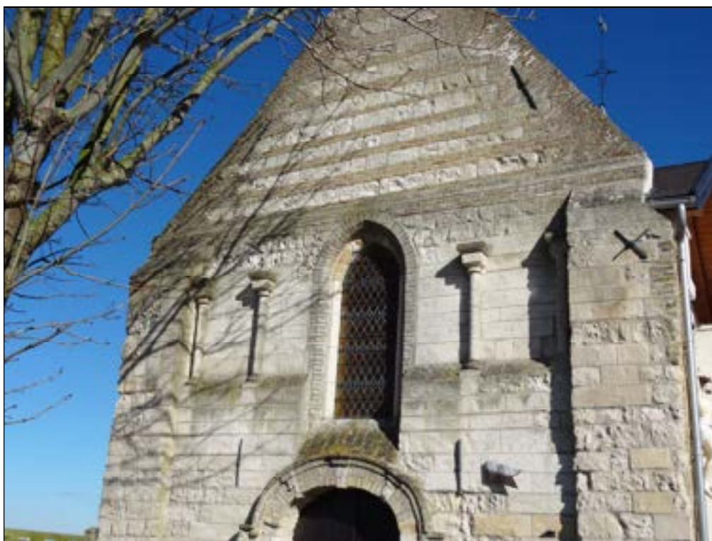
b – Wulverdinghe (Nord). Église Saint-Martin (XII e s.) Pignon de façade occidentale : vestiges du décor d'arcature aveugle Cliché : Br. Danel-Marcé
