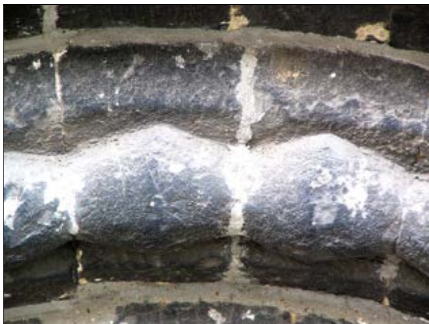
a – Lillers. Portail du bras nord voussure médiane ornée de troncs de cône Cliché Br. Danel-Marcé
