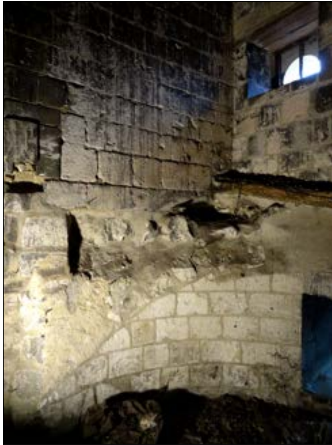
a – Vestiges de la vis nord de la tribune (comble de la chapelle des fonts). Mur d'enveloppe de la cage détruite et arrachements de la voûte (angle sud-ouest de la cage). Cliché Br. Danel-Marcé
