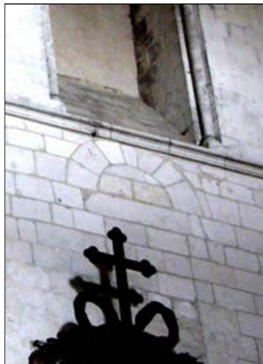
b – Baie n° 22 (bras sud, mur oriental) Avers de la baie murée vu depuis l'intérieur de l'église. Le linteau est apparent ici aussi. Cliché Br. Danel-Marcé
