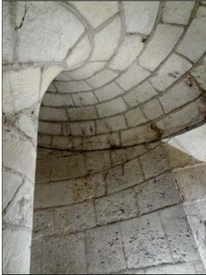
a – Noyon (Oise). Cath. Notre-Dame. Vis vers la tribune du chœur Jonction des voussoirs rectilignes et du mur d'enveloppe taillé en biais (c. 1160-1170) Cliché Br. Danel-Marcé
