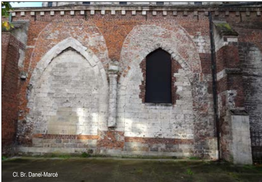
b – Mur gouttereau nord du déambulatoire. Vestiges des arcades de la chapelle
