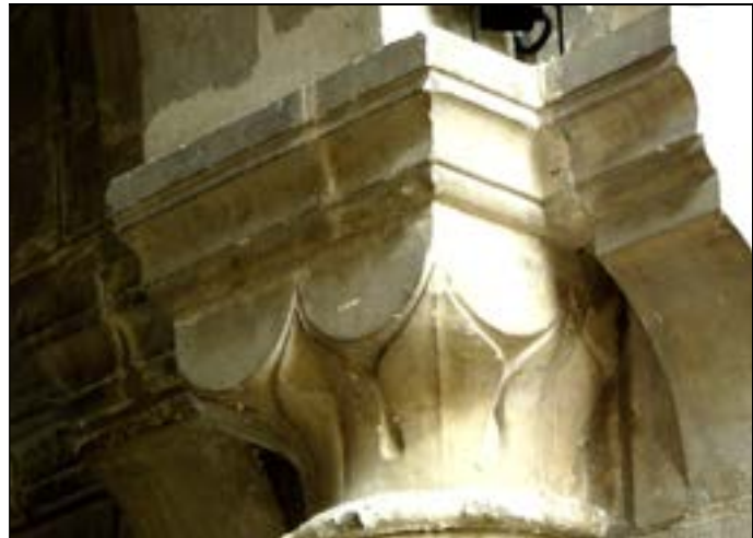
d – Lillers. Arcade nord du vestibule tailloir du chap. 4 (pilier B 2, côté ouest) et prolongement en cordon Cliché Br. Danel-Marcé
