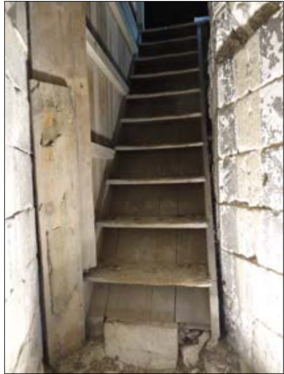
a- À gauche : empiètement dans l'angle nord-ouest de la tribune du massif de maçonnerie de la cage d'escalier en vis (en haut, à gauche : cage en charpente contenant la volée droite qui complète le dispositif). À droite : vue intérieure de cette volée droite. Clichés : (gauche) A. Timbert ; (droite) Br. Danel-Marcé
