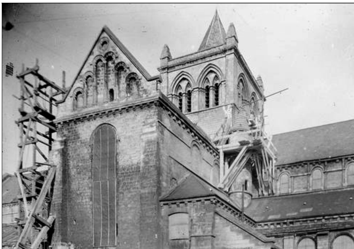
c - 1923. Restauration du mur ouest du bras sud et de la tourelle d'escalier du clocher MAP. Photothèque (cl. n° 26.305)
