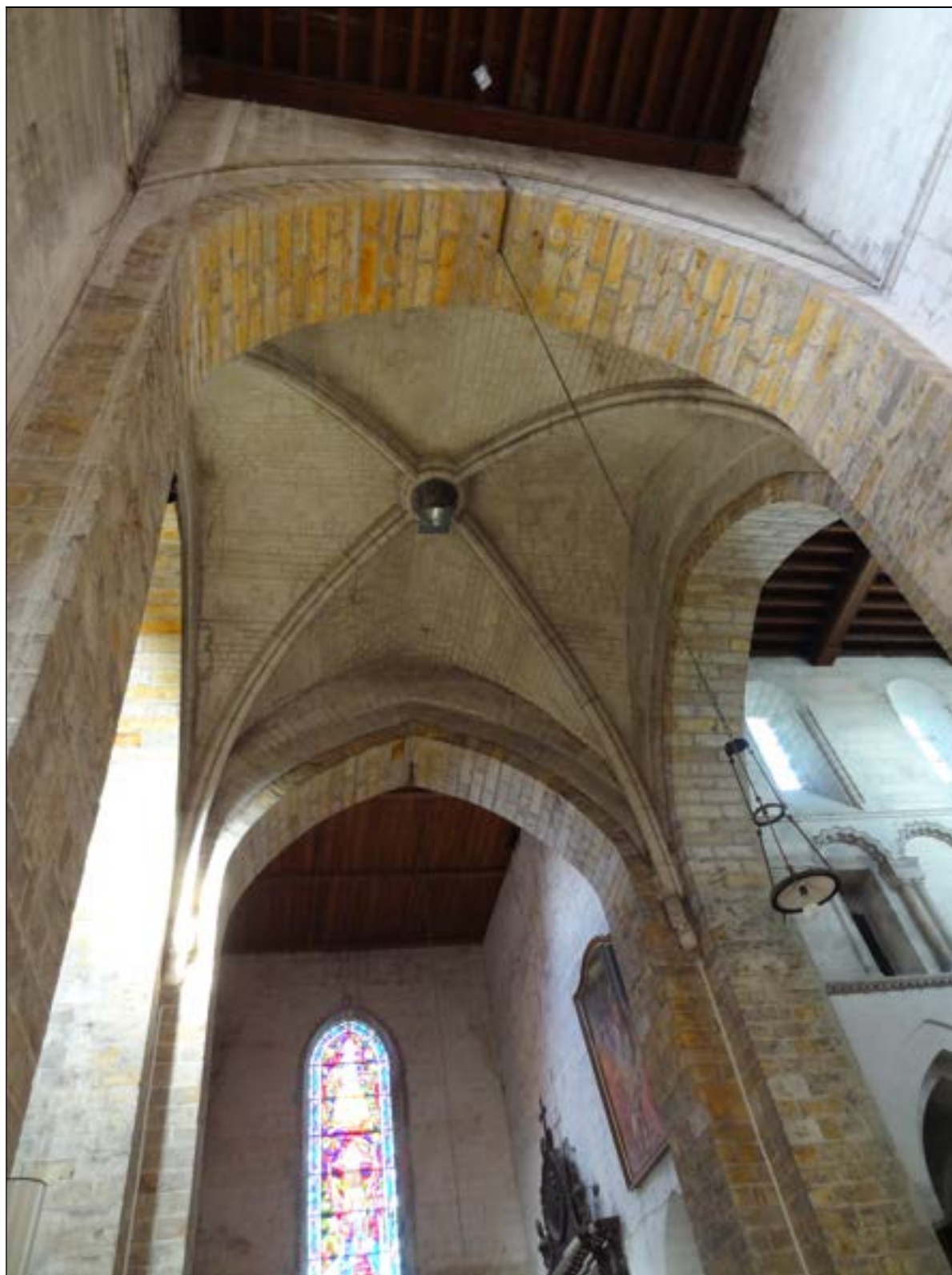
a – Croisée du transept. Vue d'ensemble vers le nord. Piles massives et arcs brisés appareillés en grès de moyen appareil Cliché Br. Danel-Marcé
