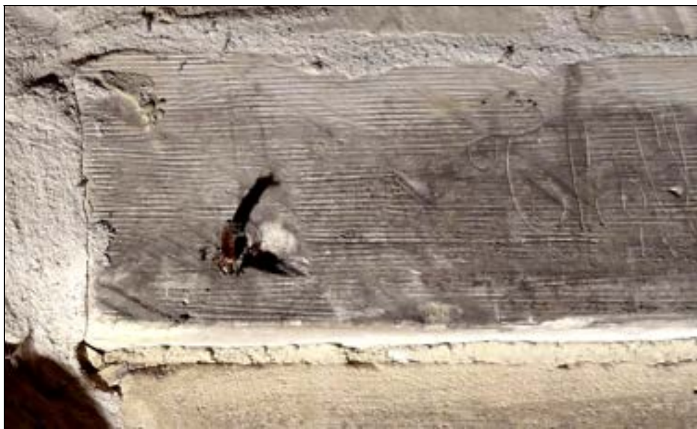
a – Gouttereau du chœur depuis le comble du déambulatoire Face aplanie au taillant droit (8 à 10 cm) du linteau de la baie n° 29. layage longitudinal serré. Cliché Br. Danel-Marcé
