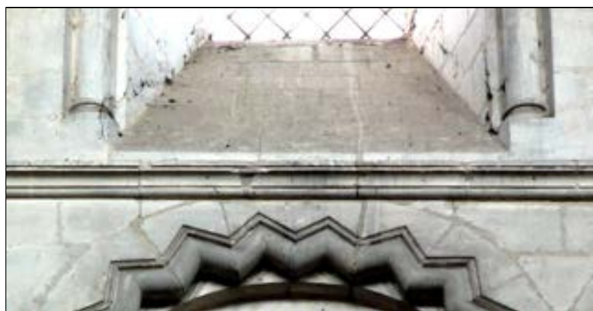
c – Lillers : chœur bandeau du mur nord. Cliché Br. Danel-Marcé
