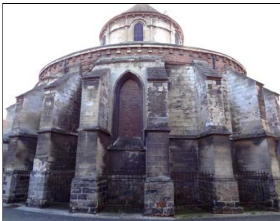
b – Chapelle d'axe vers l'ouest. À l'origine en hémicycle, les chapelles rayonnantes ont été reconstruites en trapèze aux pans très faiblement saillants. Cliché : Br. Danel-Marcé
