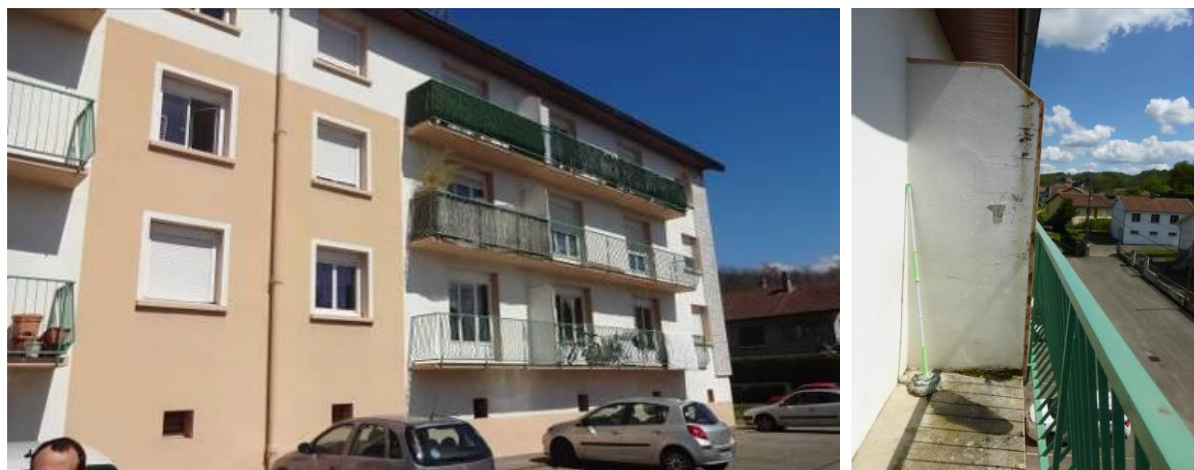
Résidence Ventravent avant ↑ et après ↓ la réhabilitation
