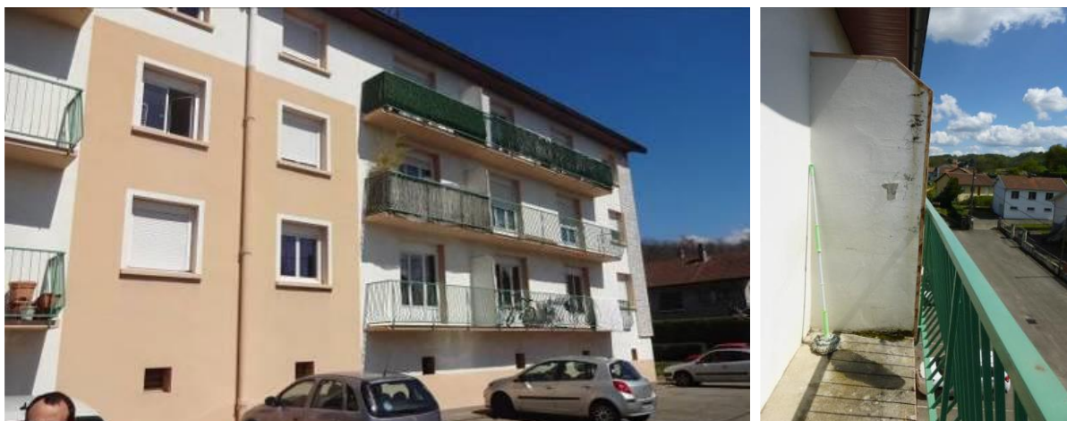
Résidence Ventravent avant ↑ et après ↓ la réhabilitation
