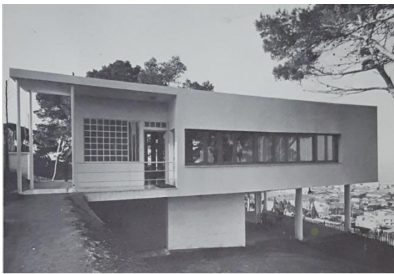
Figure 131 : Villa Contou, sur les hauteurs de Kouba, Alger, archi, Emery, 1932 (P. Emery, art. cit. , p. 55)
