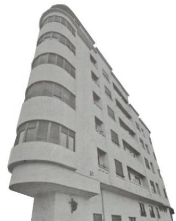
Figure 92 : Immeuble de rapport, Oran (CNA, 1937, p. 41)
