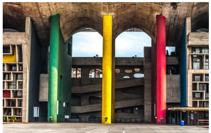
Figure 129 : La façade principale de la haute cour de Chandigarh ( www.chambres-hotes-morin-salome.fr/ )
