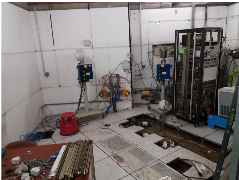
FIGURE C.3.2 – Emplacement de l'ancienne acquisition de l'électronique après le démontage complet.
