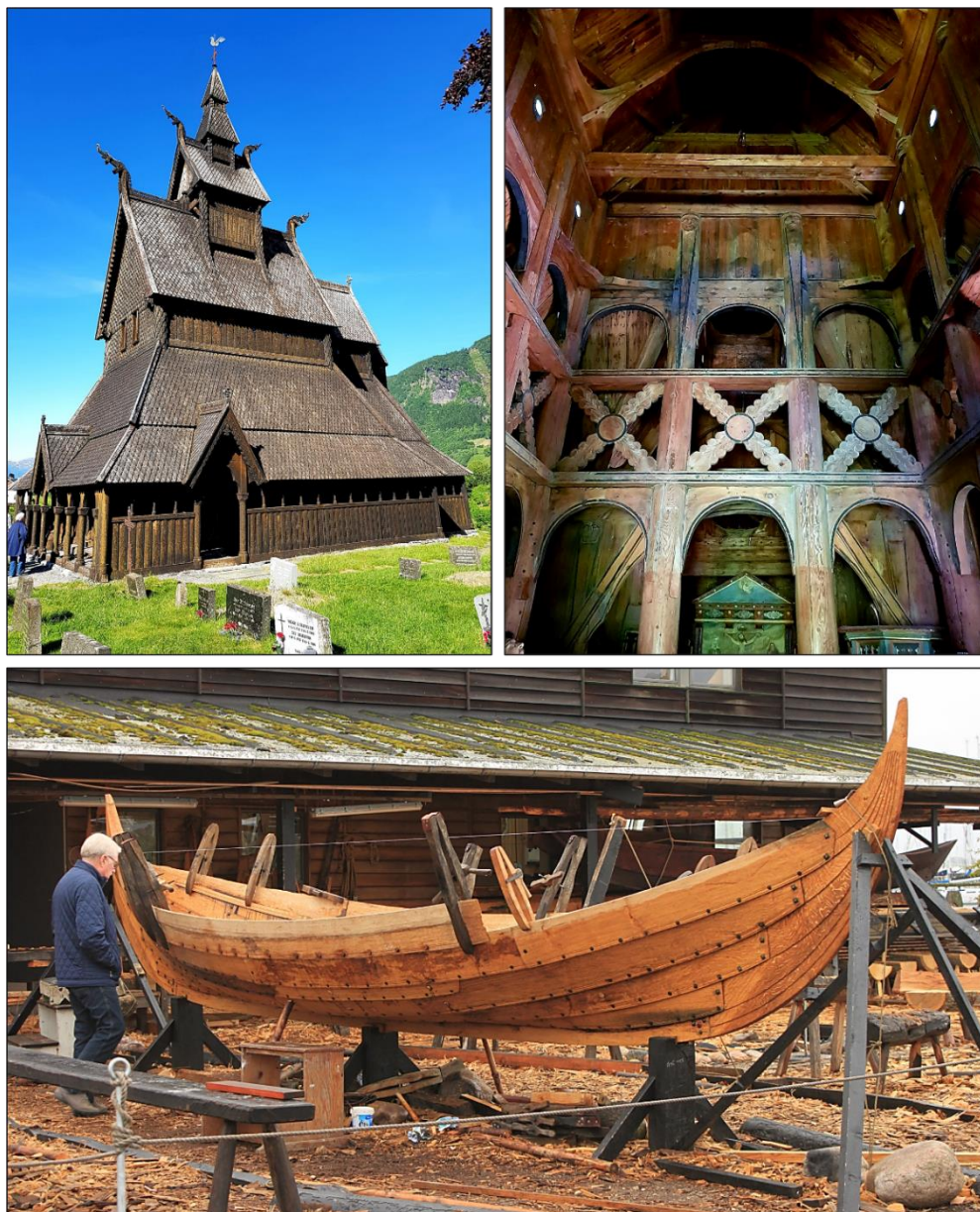
Figure 34: (haut) Vues extérieure et intérieure de la stavekirke de Borgund en Norvège ; (bas) réplique d'une embarcation 'à clin' en cours de construction au Musée des navires vikings de Roskilde au Danemark.
