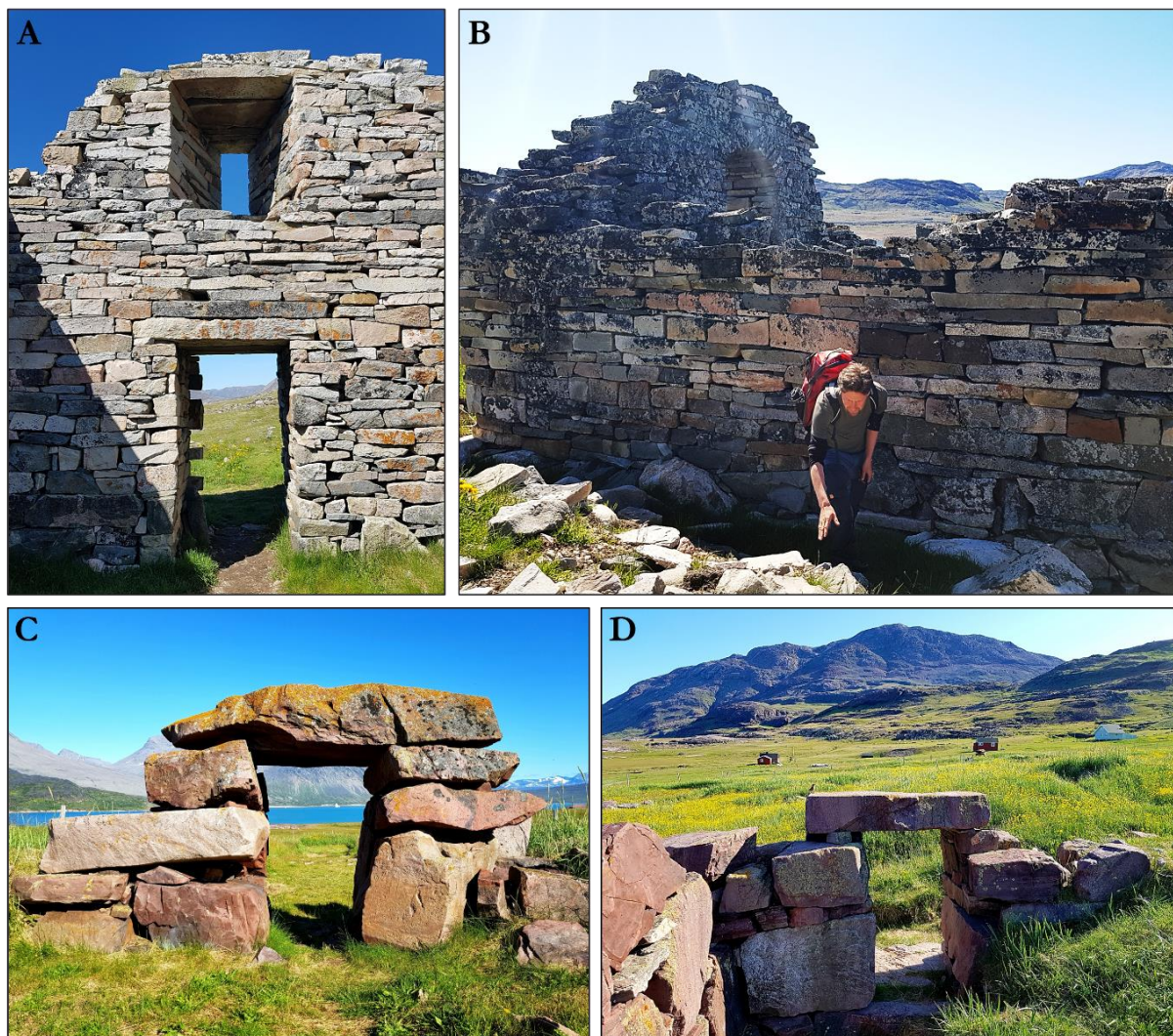
Figure 25 : Les ruines de l'église de Hvalsey (A et B), construite en granite, et de l'établissement manorial de Gardar (C et D), construit en grès (Photographies : E. Pinta).
