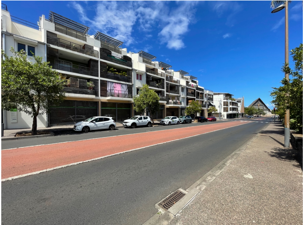
Figure 99 : Bâtiment à rue du Père Favron
