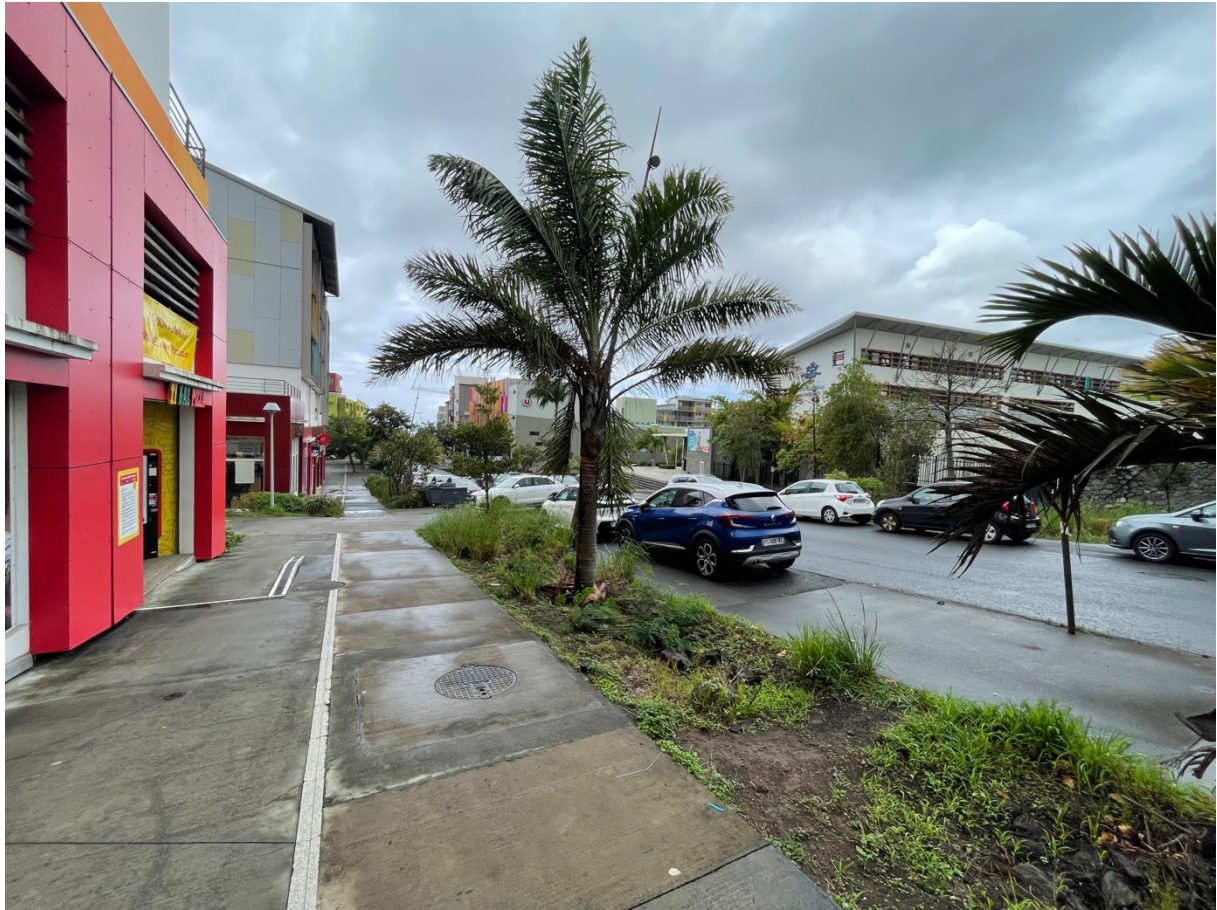
Figure 96 : Haut de l'Avenue du Beau Pays (2/3)
