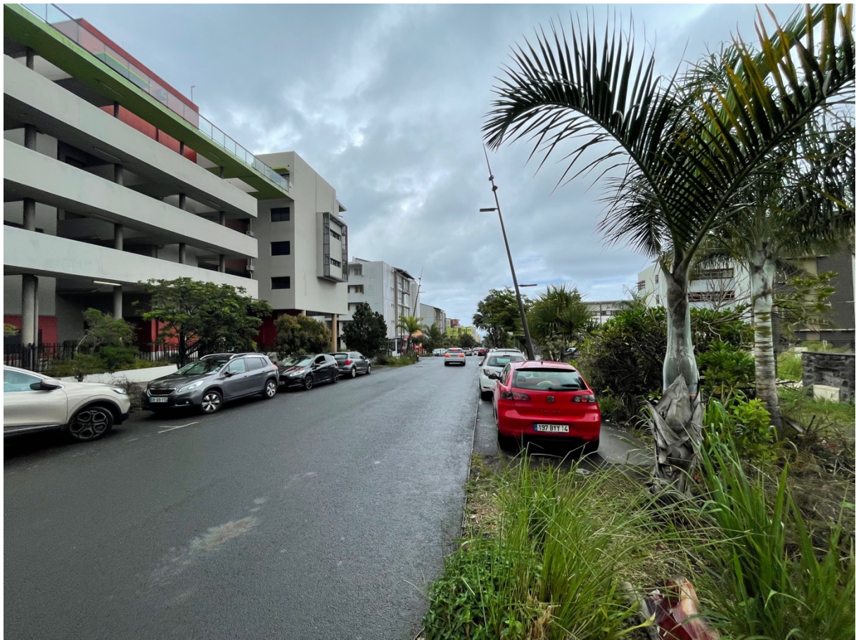
Figure 97 : Haut de l'Avenue du Beau Pays (3/3)
