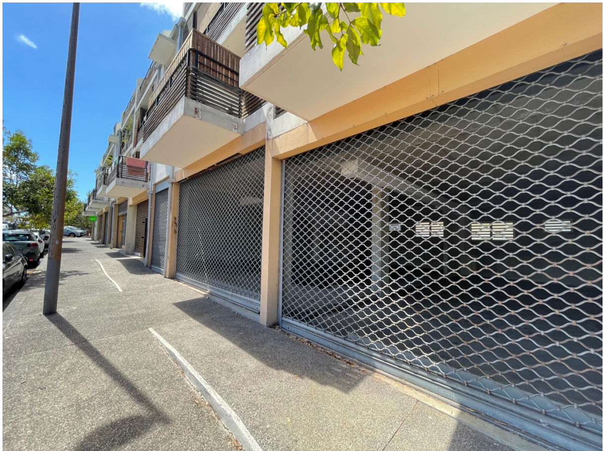
Figure 103 : Locaux commerciaux route du Père Favron
