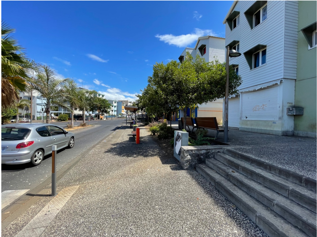
Figure 110 : Logements sociaux à rue Père Favron
