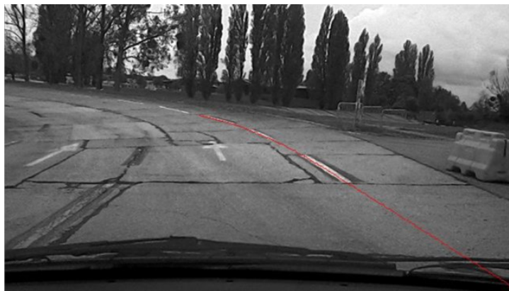
FIGURE 2.2 – Une détection perturbée à cause d'une infrastructure dégradée [137]
