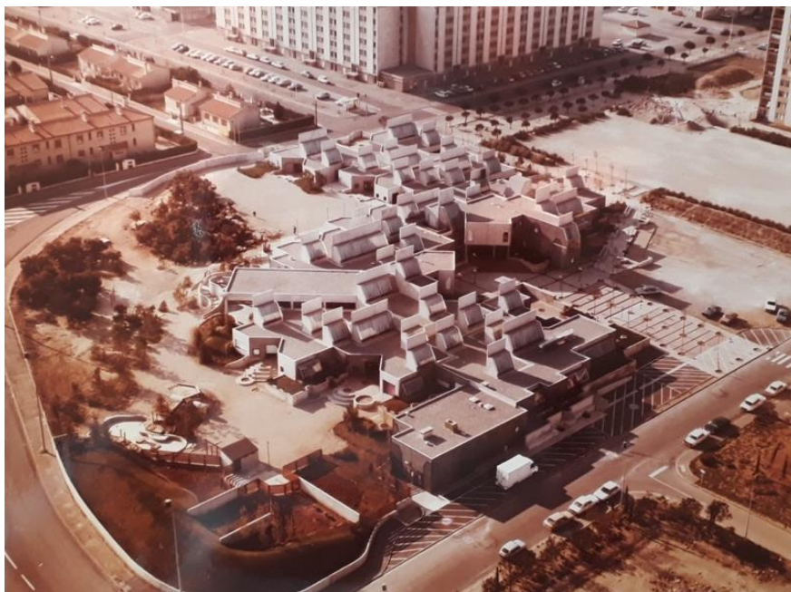
Figure n° 28 - Architecture de l'école n°2
