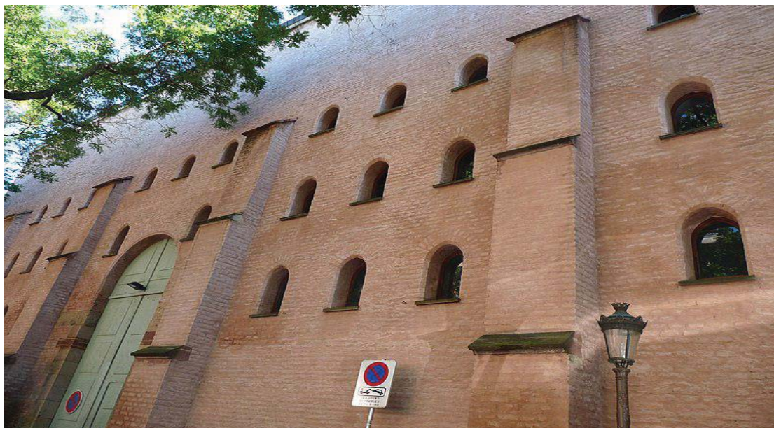
Image 7 : Grenier du Kornspeicher de Strasbourg
