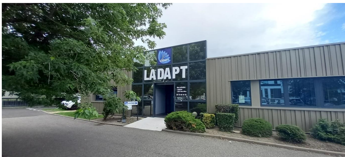
Fig. 59 – Les locaux de LADAPT Puy-de-Dôme depuis septembre 2018, 15 avenue Léonard de Vinci
