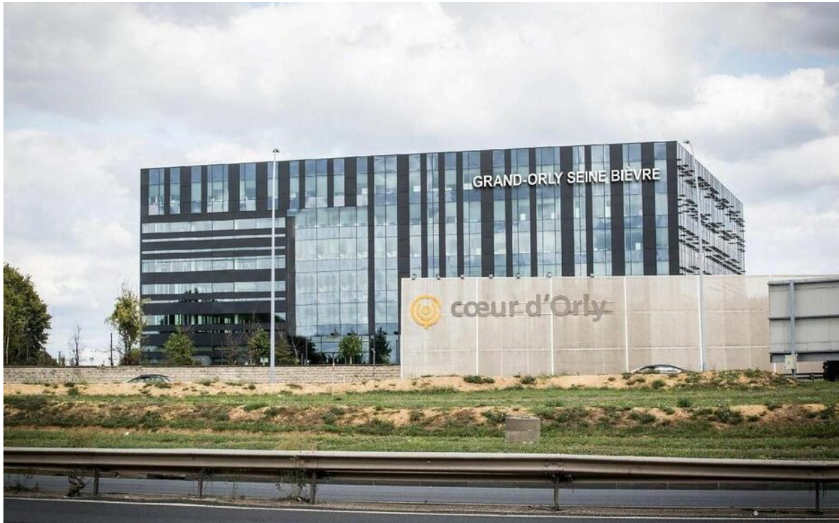
Figure n°43 : Siège de Grand Orly Seine Bièvre sur la zone aéroportuaire d'Orly
