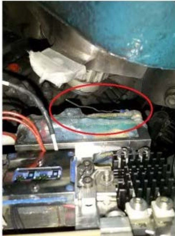
Figure 172. Antenne du TAG lors de l'intégration
