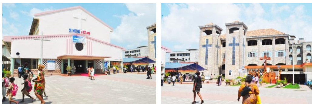
La cathédrale Saint-Michel Gbeto de Cotonou (Eglise, parvis et séminaire), dans le quartier éponyme. Fondée en 1936, elle est aujourd'hui la plus grande paroisse catholique du Bénin. (Source : Archidiocèse de Cotonou)
