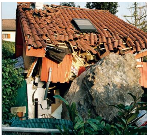
Figure 1-2 Événement chute de bloc sur habitation
