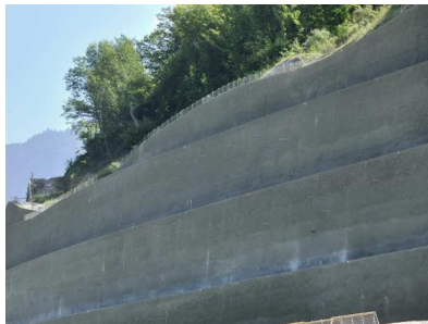
Figure 1-5 Béton projeté
