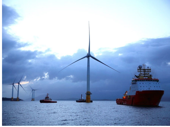
(b) Hywind - SPAR Type FOWT
