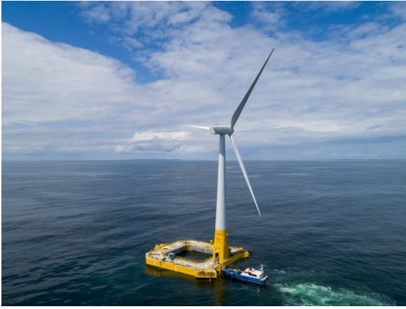
(a) FLOATGEN - Barge Type FOWT
