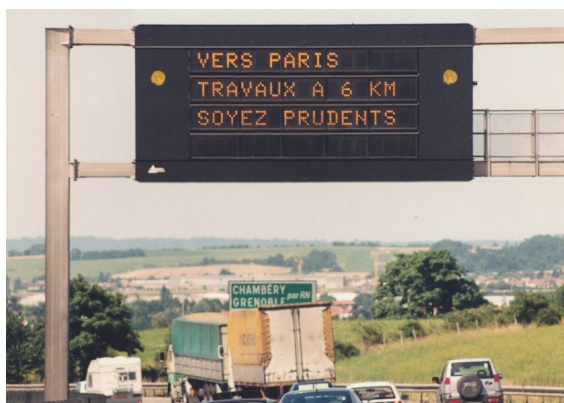
FIGURE 1.9 – Un panneau à messages variables autoroutier
